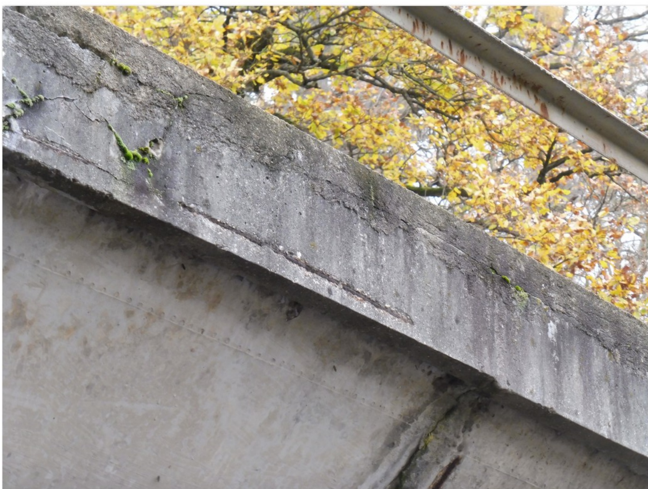
2.1-91 Detail fotografie č. 2.1-90 - v římsové části trhliny s uchycenou vegetací - obnažená korodující výztuž
