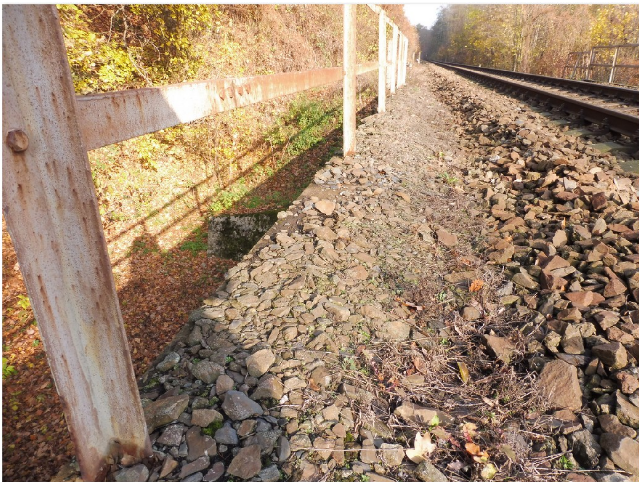
3.2-06 Levá římsa na konci mostu překrytá štěrkem kolejového lože a uchycenou vegetací
