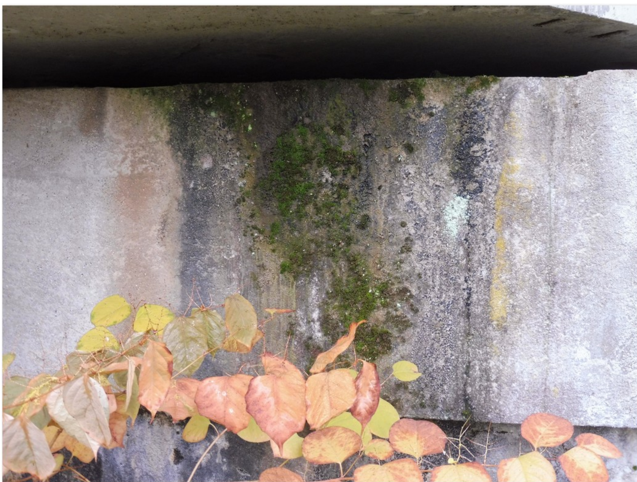
1.2-62 Vegetace uchycená na úložném prahu opěry 4
