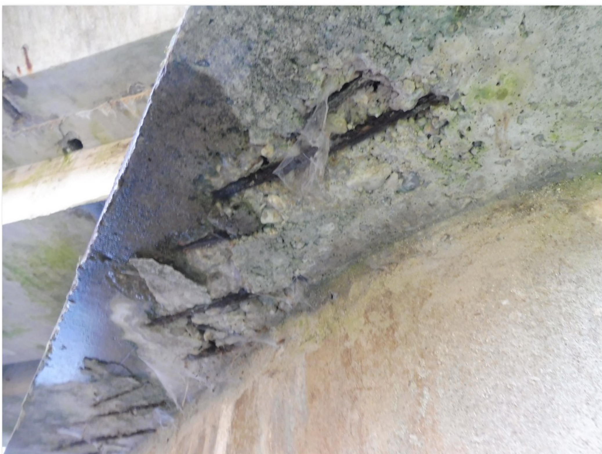
1.2-22 Úložný práh pilíře 2 - beton odlomený působením rozpínavých účinků korozních zplodin výztuže
