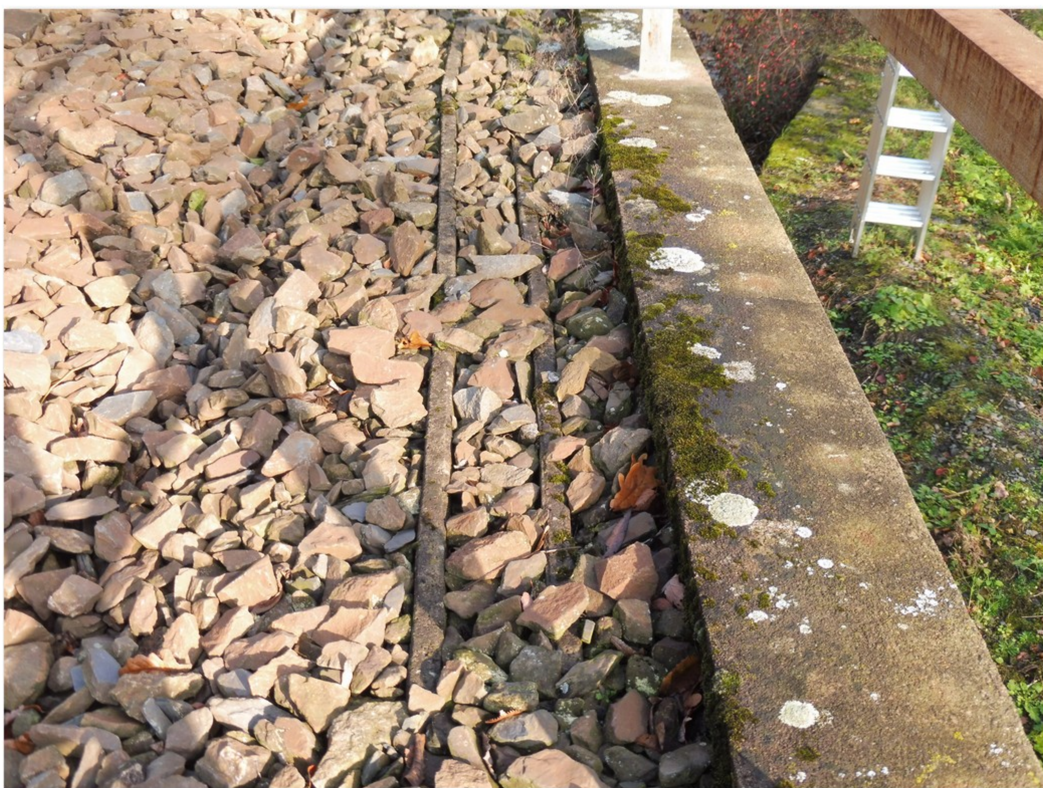
3.2-08 Vegetace uchycená na povrchu pravé římsy
