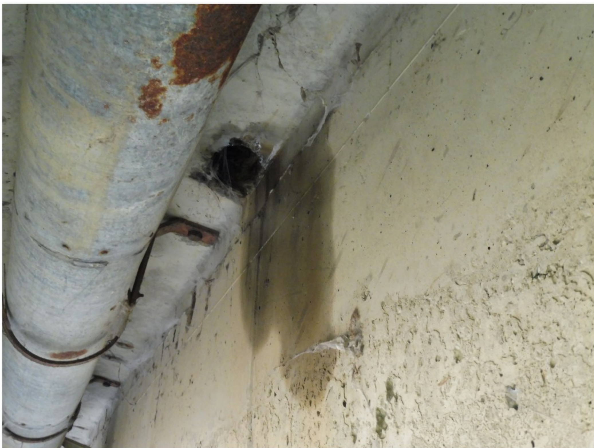
2.1-72 Levá stěna nosníku č. 3.2 - zatékání nezapraveným montážním otvorem
