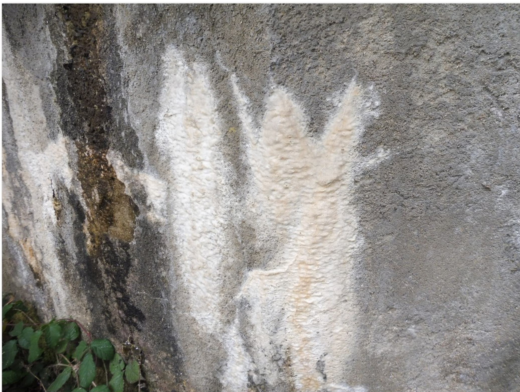
1.2-64 Trhliny s výluhy a inkrustacemi v dříku opěry 4
