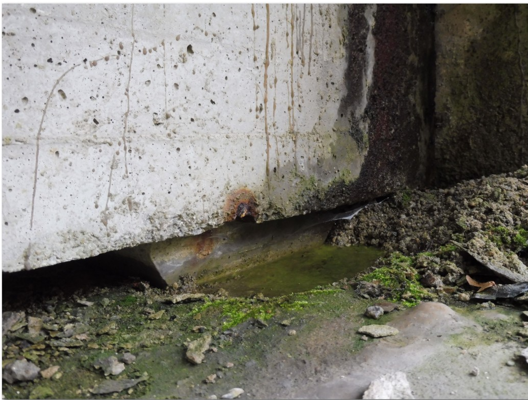
2.2-01 Uložení nosníku č. 1.1 na opěře 1 vlevo
