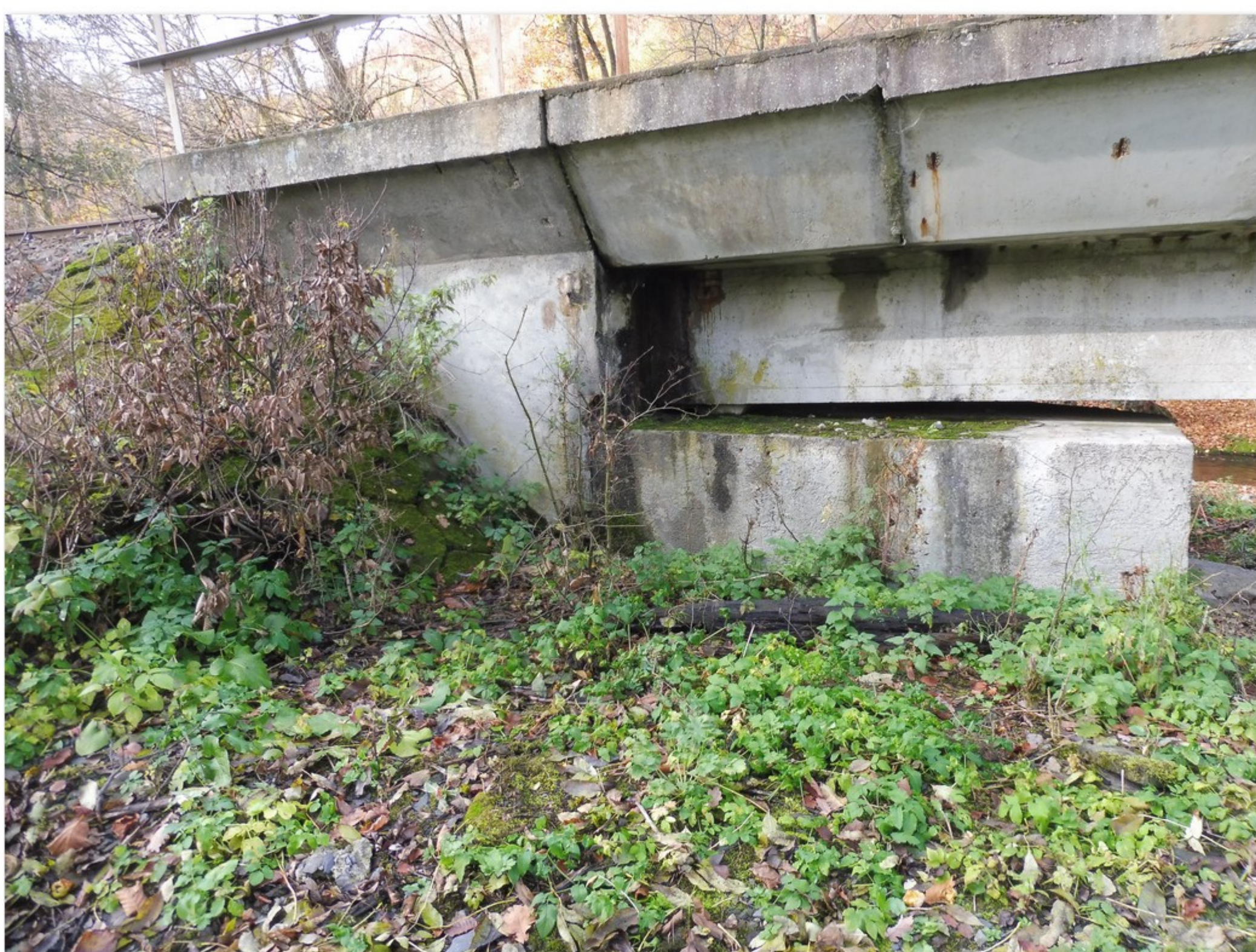
1.2-04 Opěra 1 - pravé čelo a navazující křídlo
