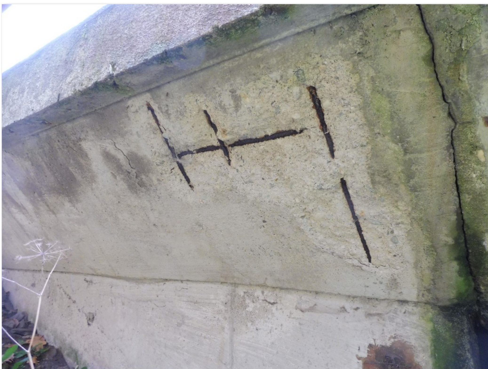
1.2-58 Levá konzola opěry 4 - korodující výztuž s nedostatečným krytím - beton odlomený působením rozpínavých účinků korozních zplodin
