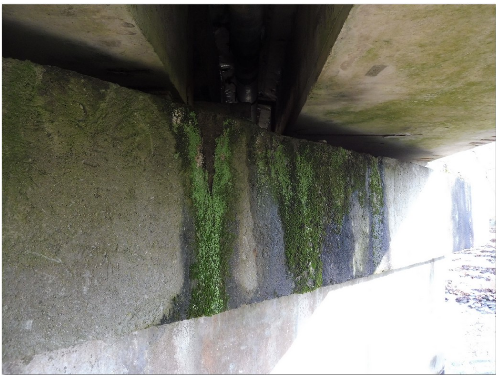
1.2-15 Vegetace uchycená na úložném prahu pilíře 2
