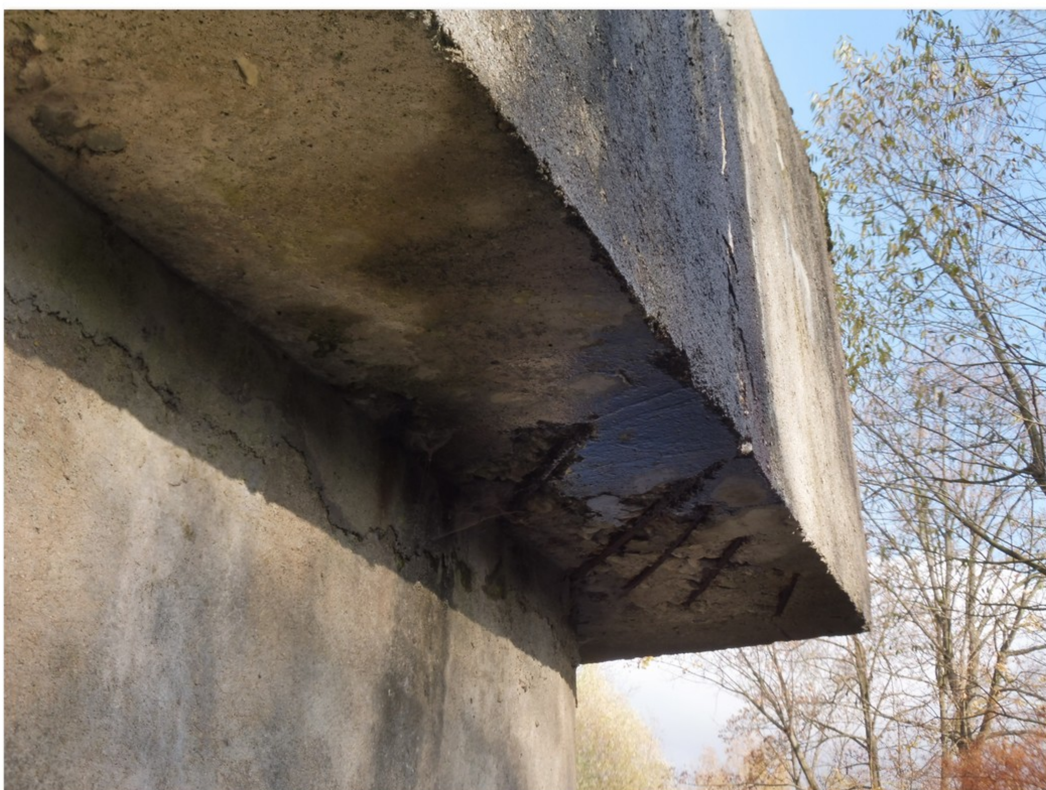
1.2-18 Obnažená korodující výztuž v úložném prahu pilíře 2
