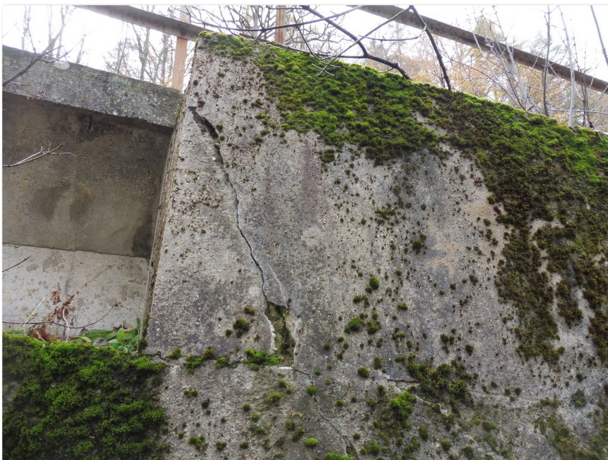
1.2-68 Pravostranná opěrná zeď za opěrou 4 - praskliny - degradace betonu
