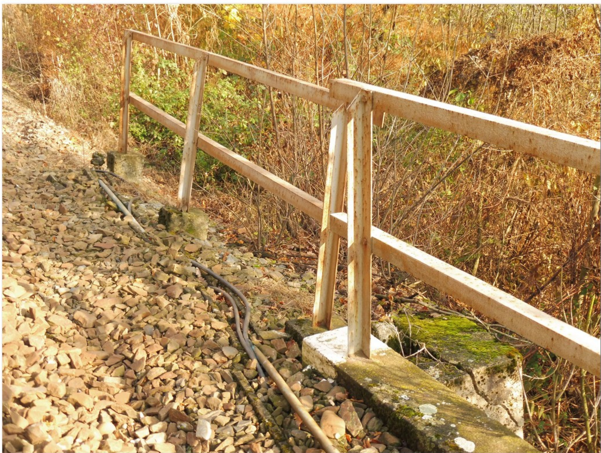
4.1-02 Vykloněné zábradlí za pravým křídlem opěry 4
