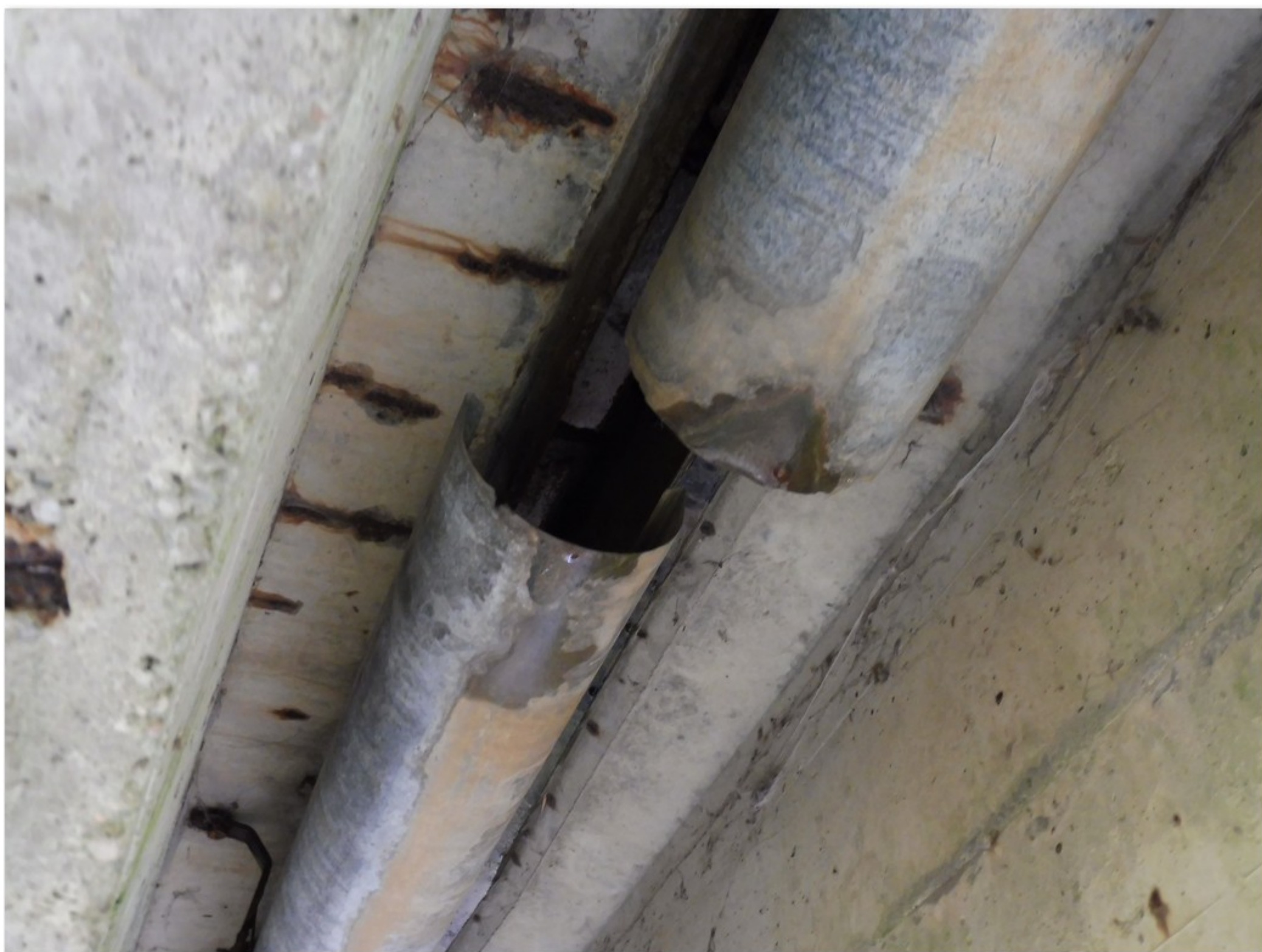
3.4-01 Rozpojený odvodňovací žlab - chybějící kotlík v 1. poli
