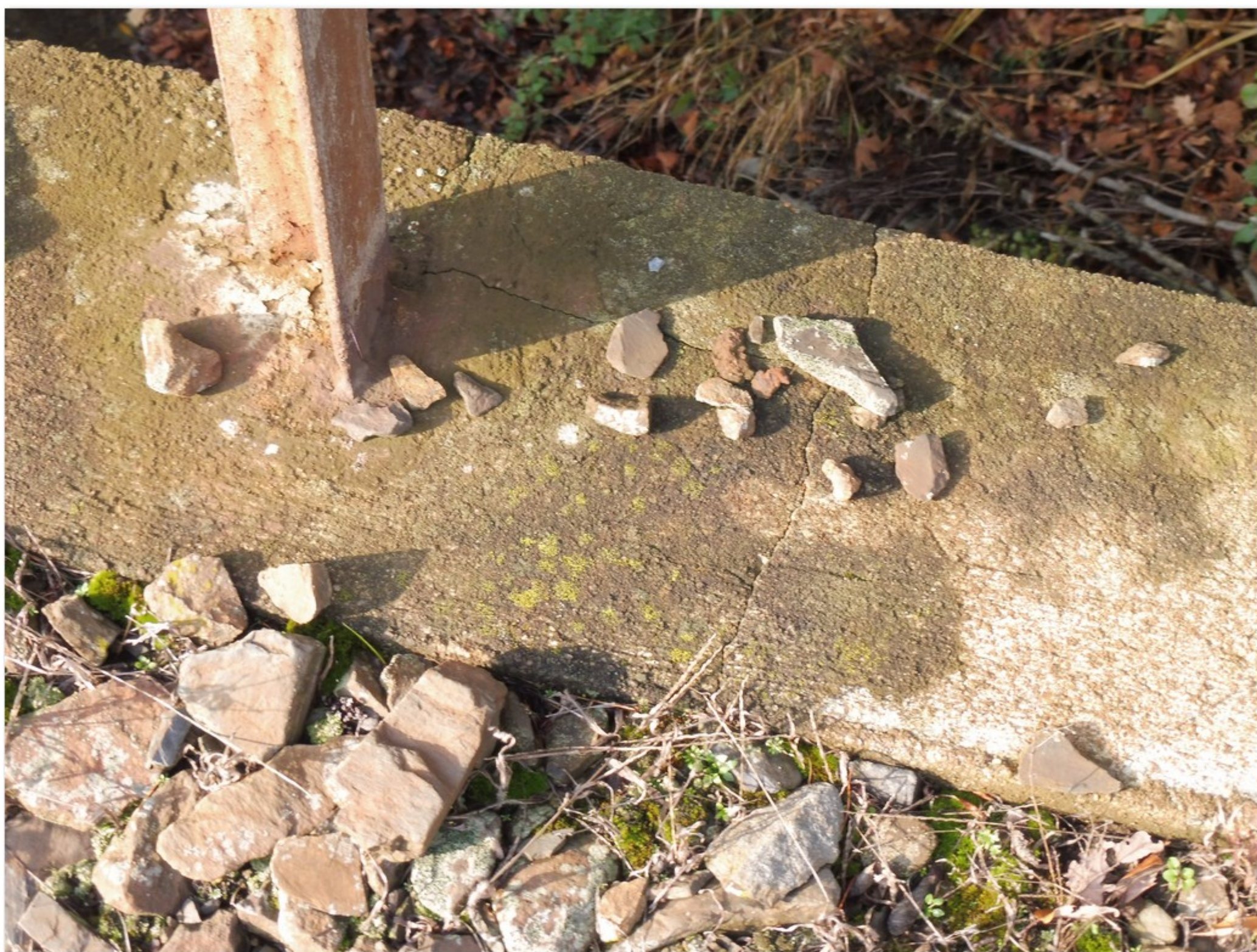
3.2-04 Povrch levé římsy - trhliny v místě uložení sloupku zábradlí
