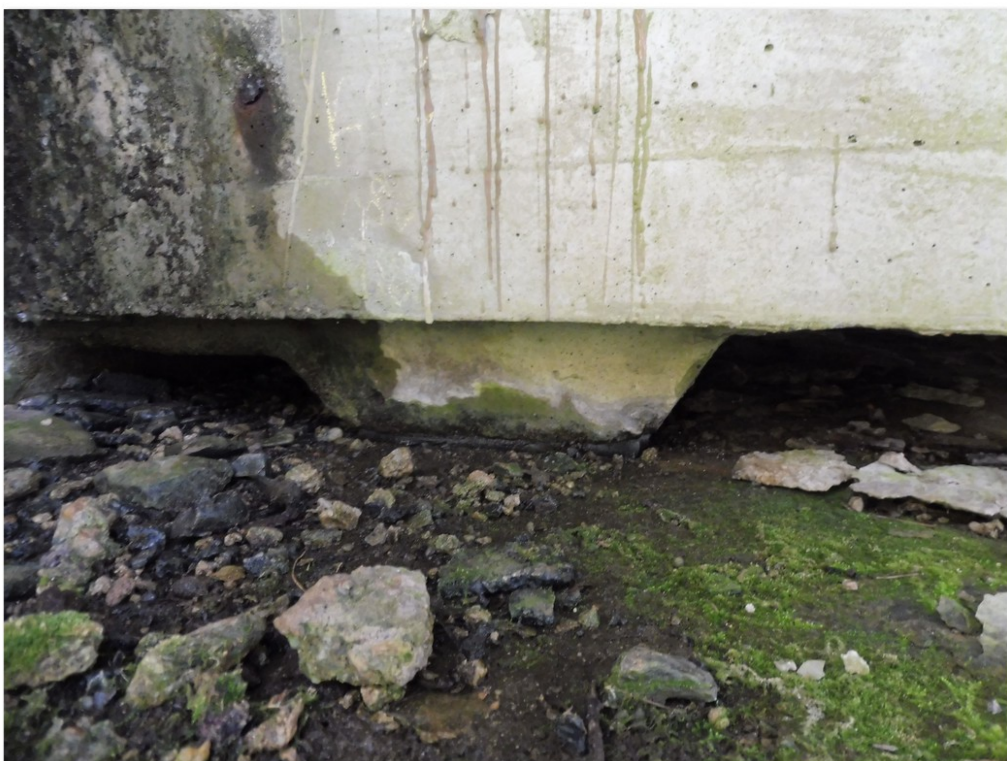
2.2-16 Uložení nosníku č. 3.1 na opěře 4 vlevo
