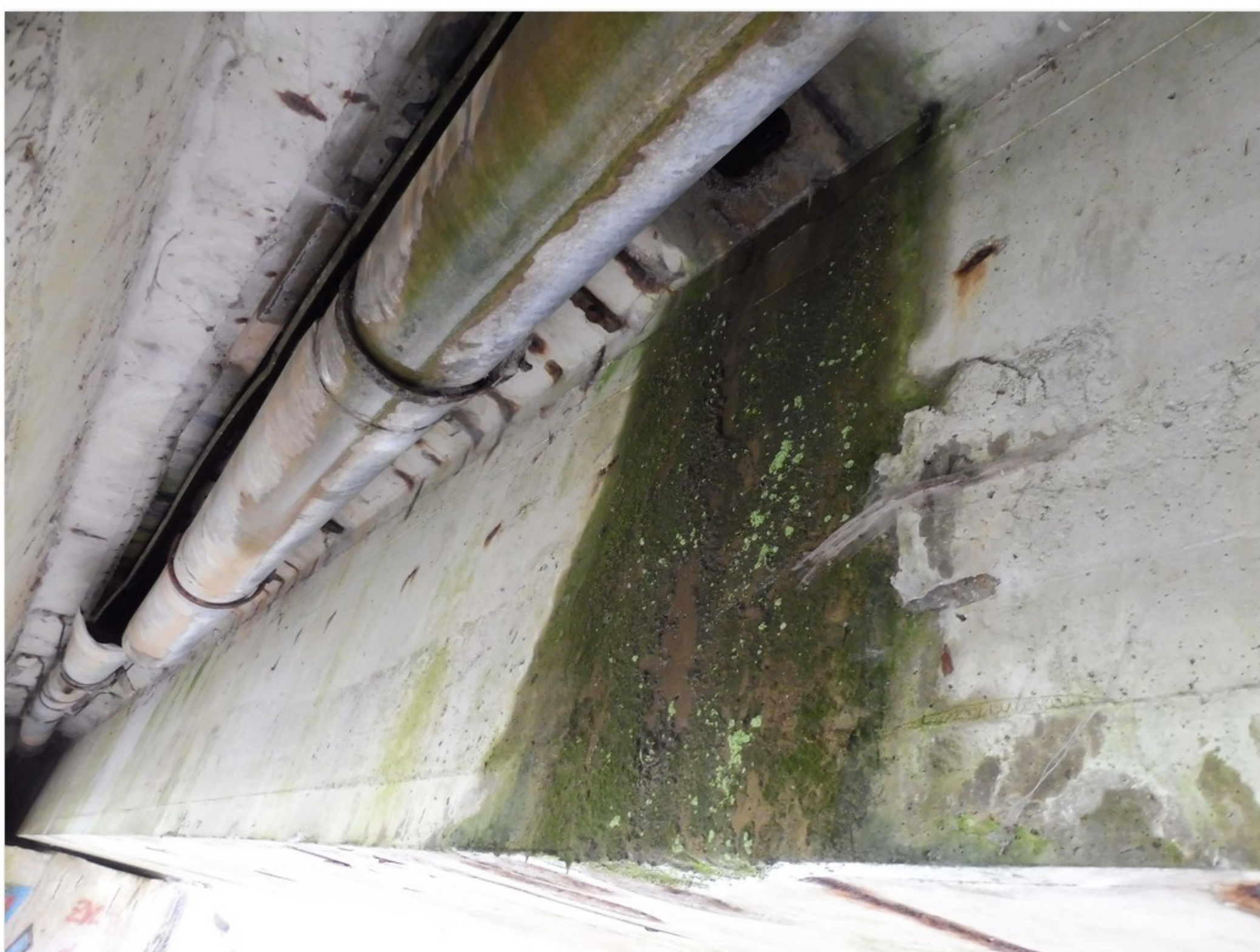
3.4-02 Rozpojený odvodňovací žlab v 1. poli
