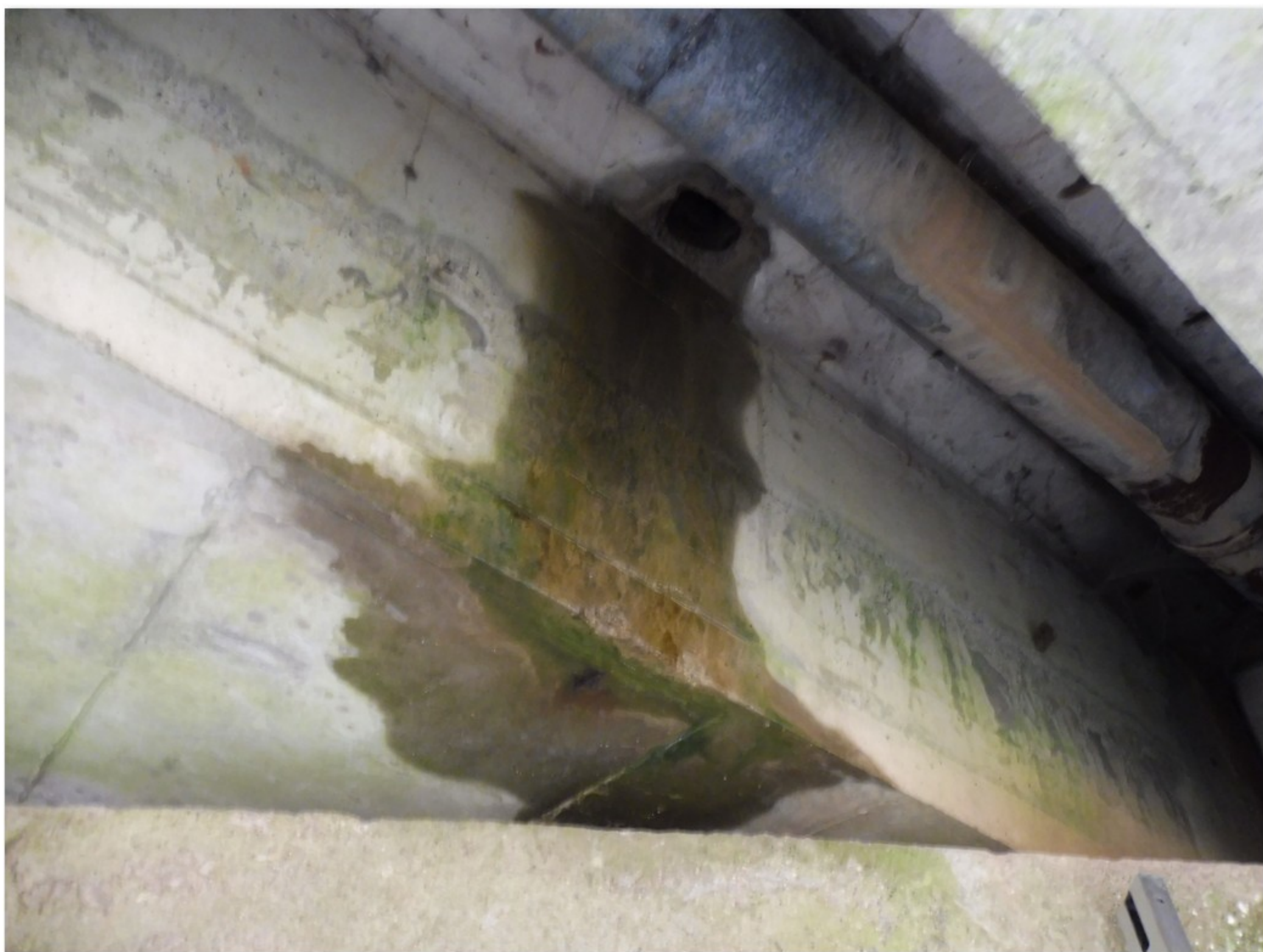
2.1-22 Levá stěna nosníku č. 1.2 - zatékání nezapraveným montážním otvorem nad opěrou 1
