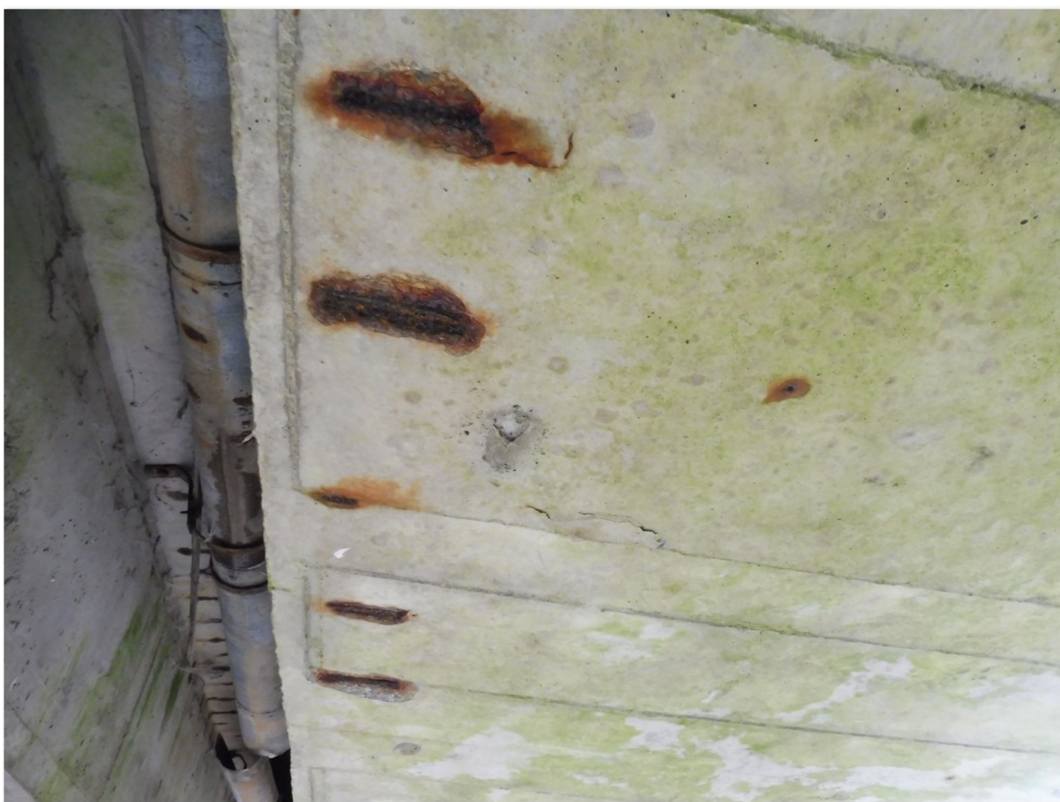
2.1-24 Detail fotografie č. 2.2-03 - korodující výztuž s nedostatečným krytím - beton odlomený působením rozpínavých účinků korozních zplodin
