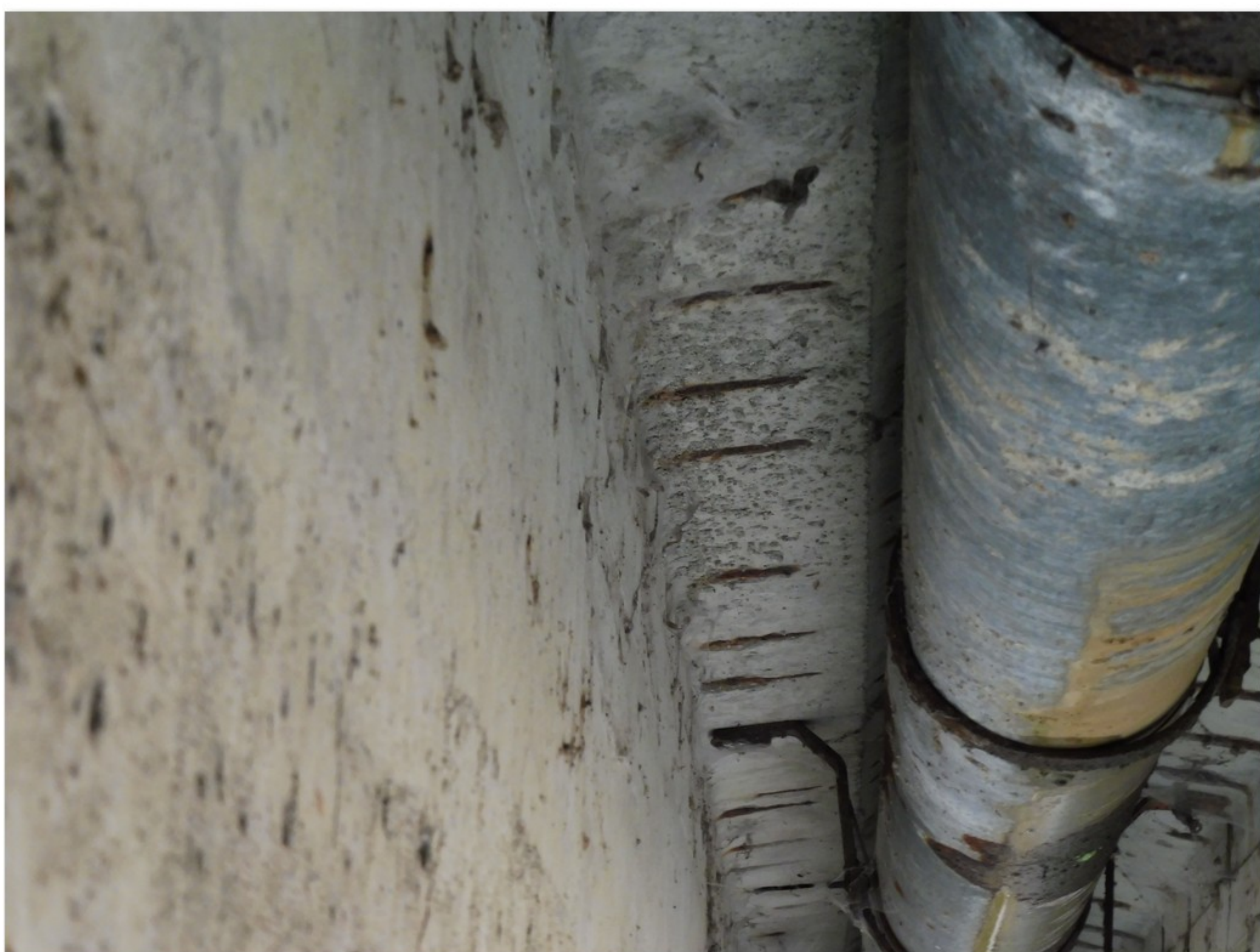
2.1-73 Podhled levé horní příruby nosníku č. 3.2 - korodující výztuž s nedostatečným krytím - beton odlomený působením rozpínavých účinků korozních
