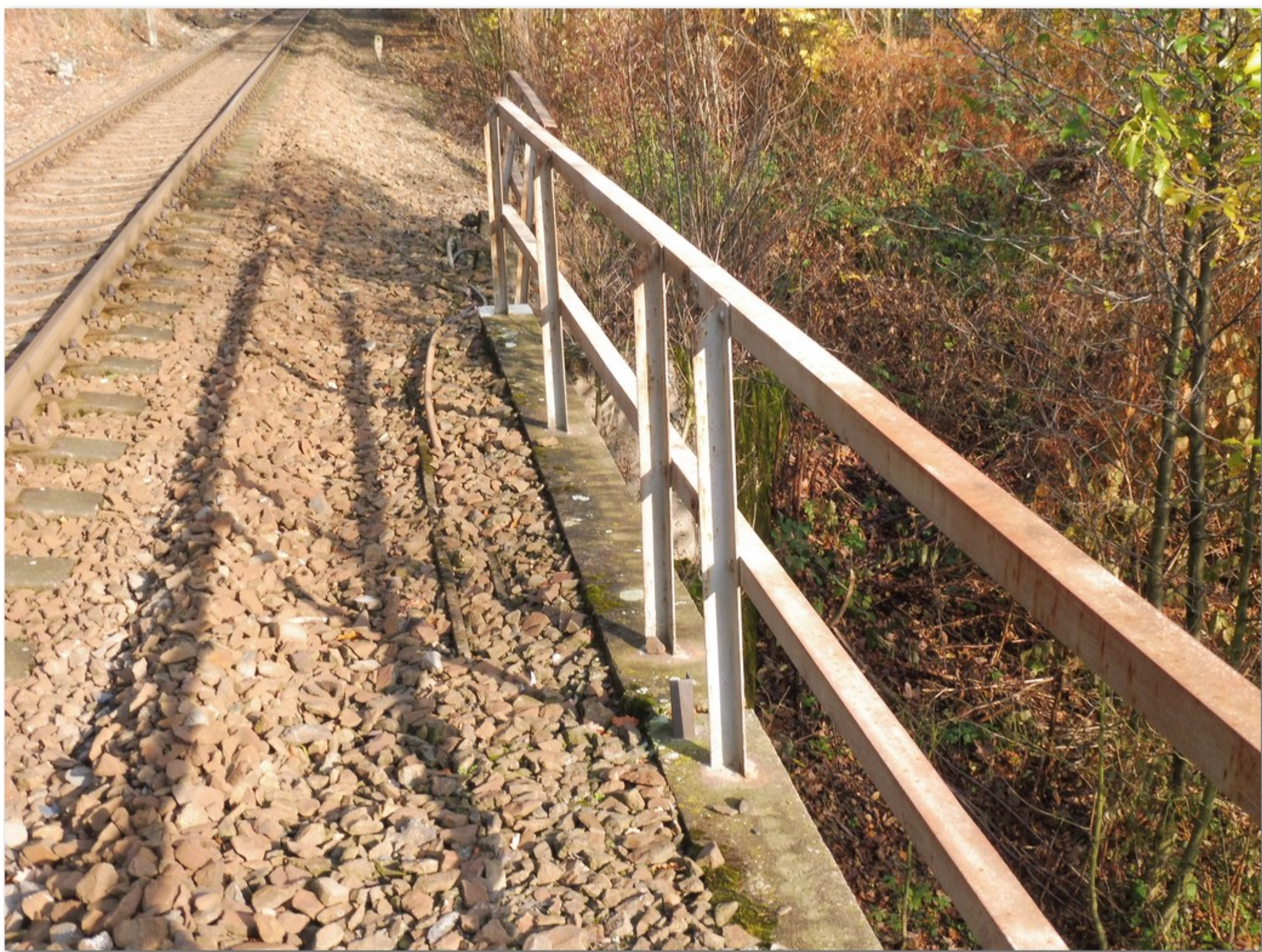
4.2-05 Kabelový žlab na konci mostu
