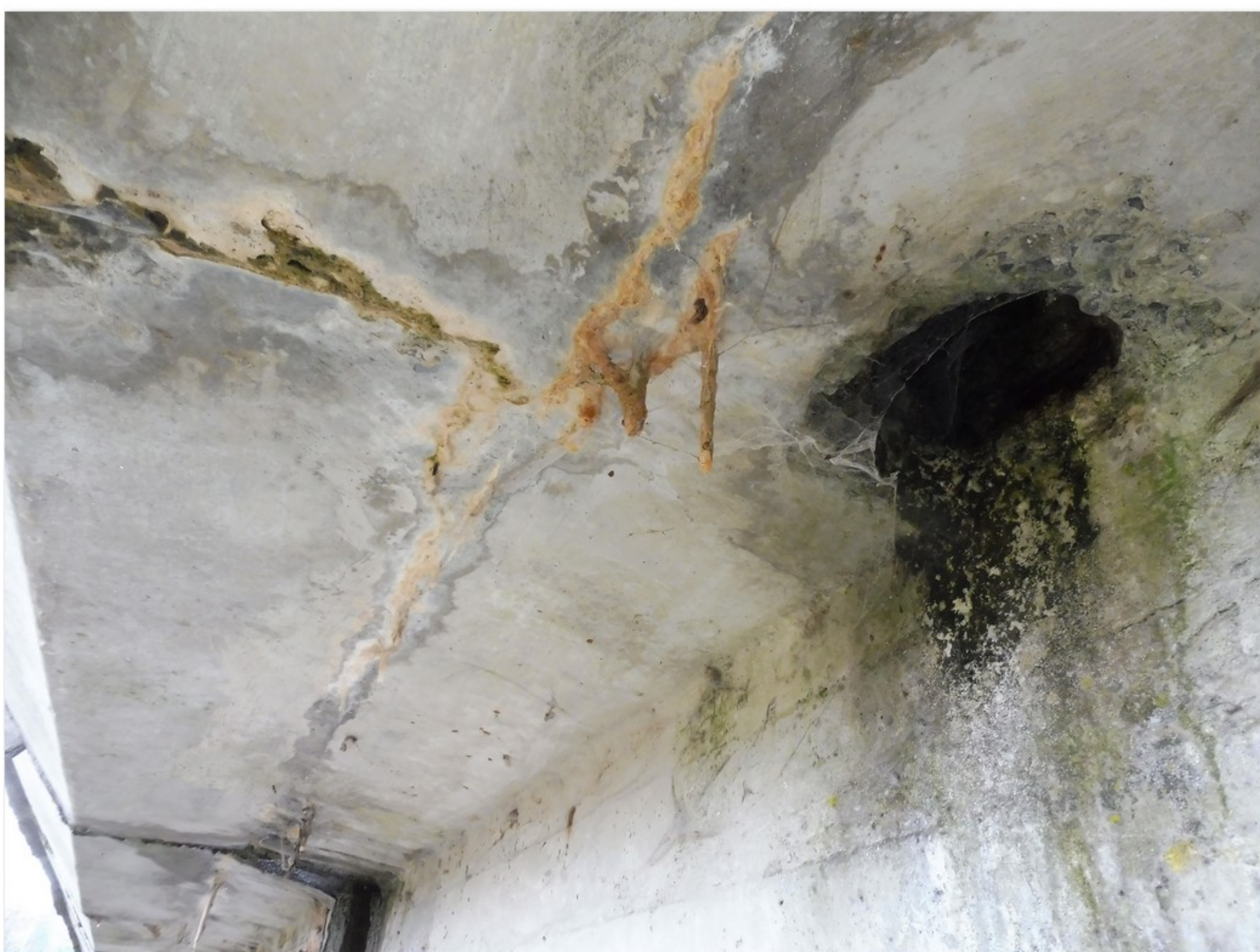
2.1-57 Pravá horní příruba nosníku č. 2.2 - zatékání nezapraveným montážním otvorem nad pilířem 2
