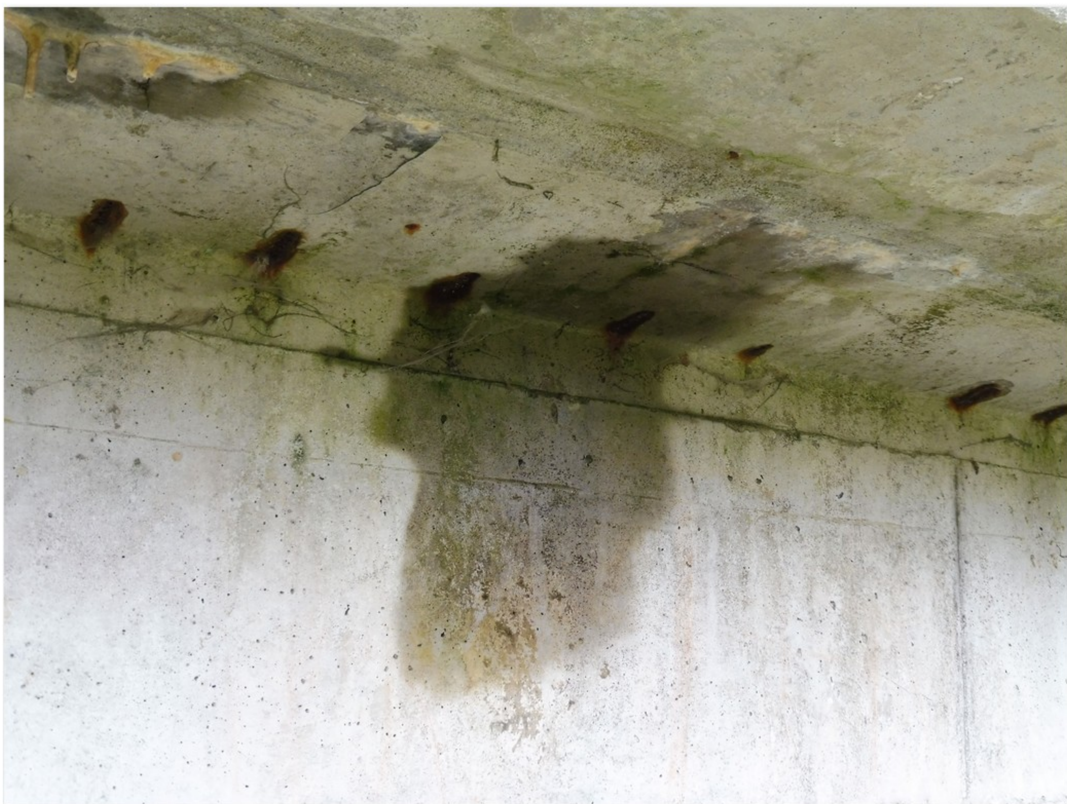
2.1-30 Pravá stěna nosníku č. 1.2 - zatékání - korodující výztuž s nedostatečným krytím - beton odlomený působením rozpínavých účinků korozních zplodin
