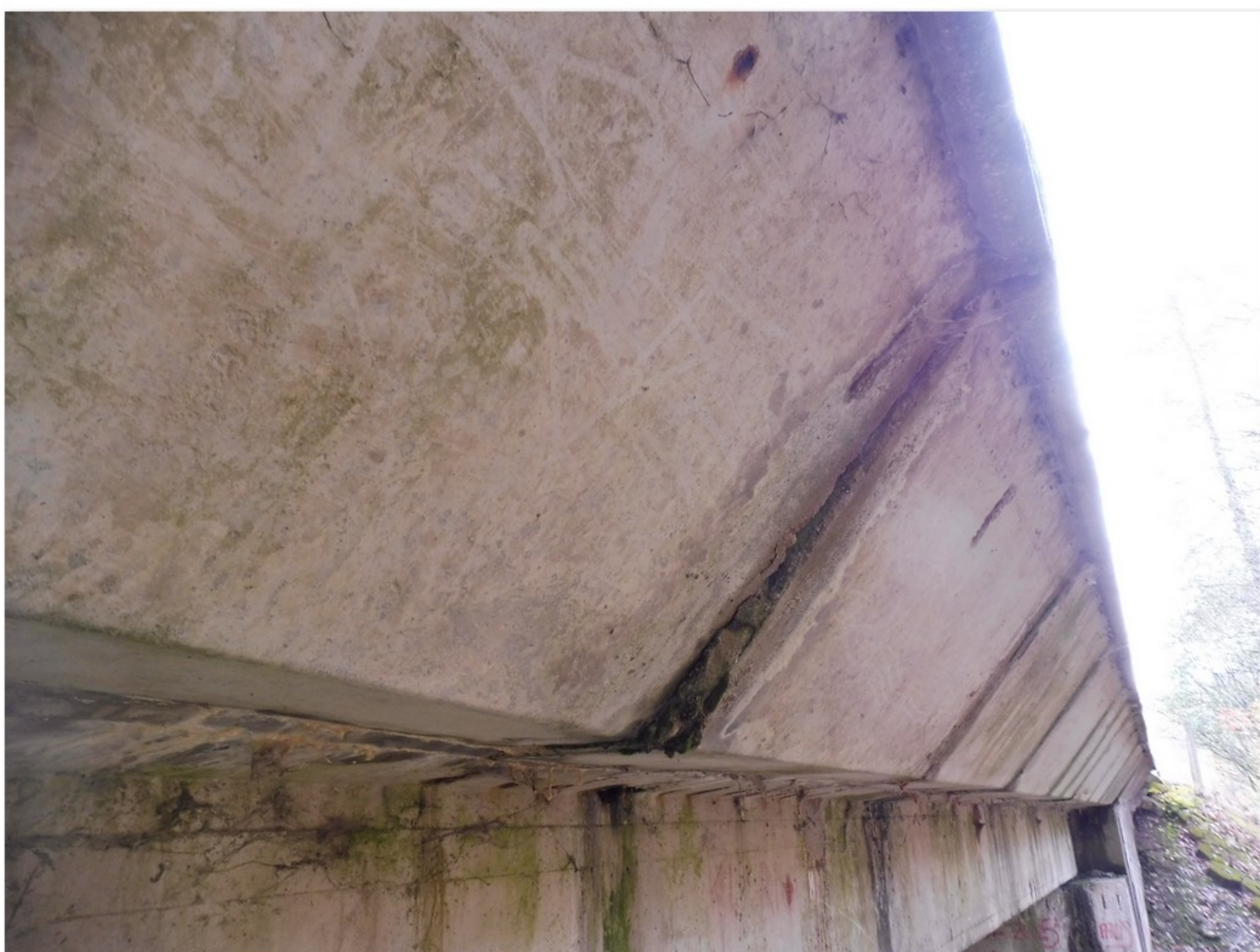
2.1-83 Prefabrikované konzoly na levém okraji mostu v 1. poli
