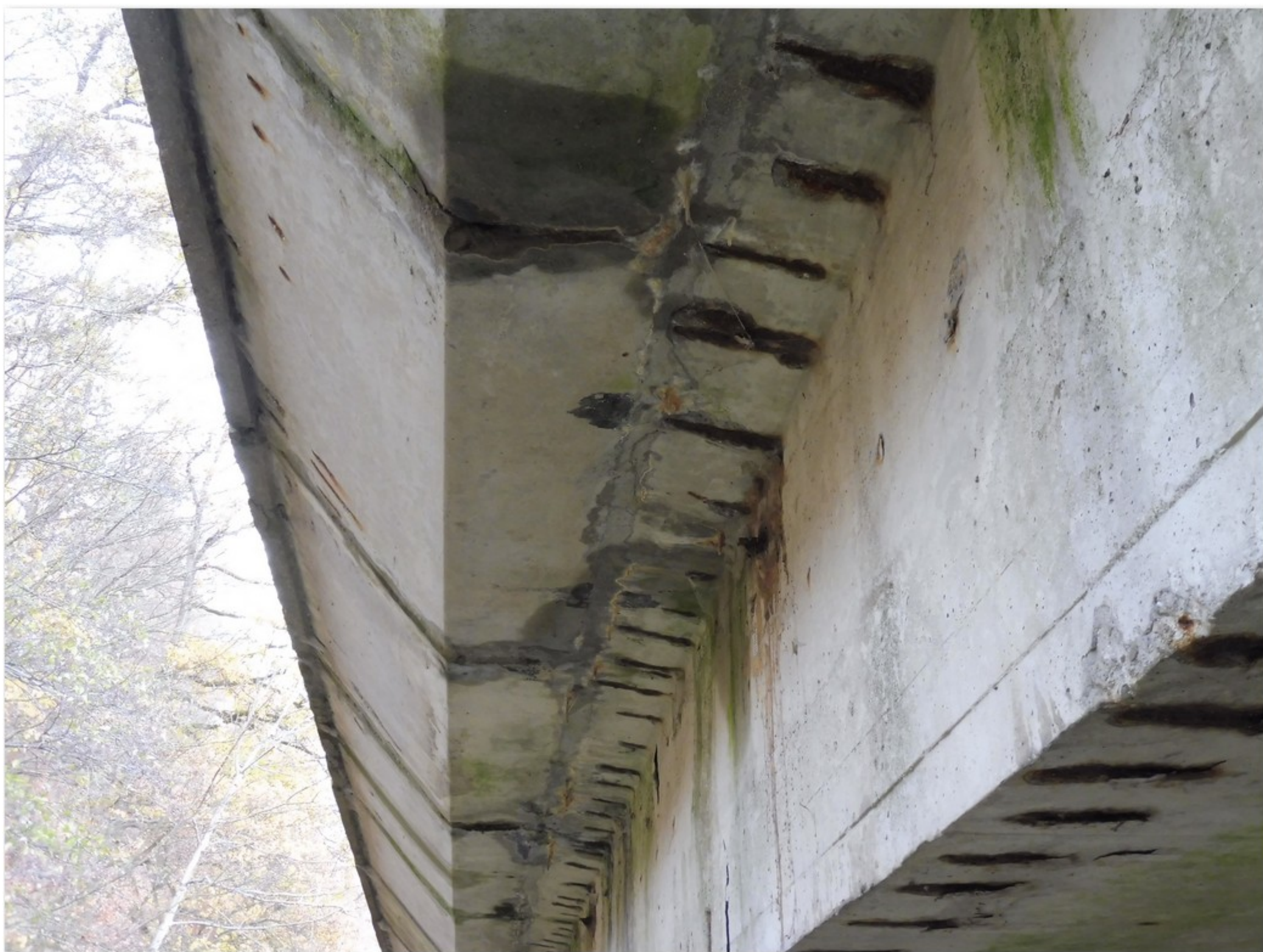
2.1-02 Podhled levé konzoly nosníku č. 1.1
