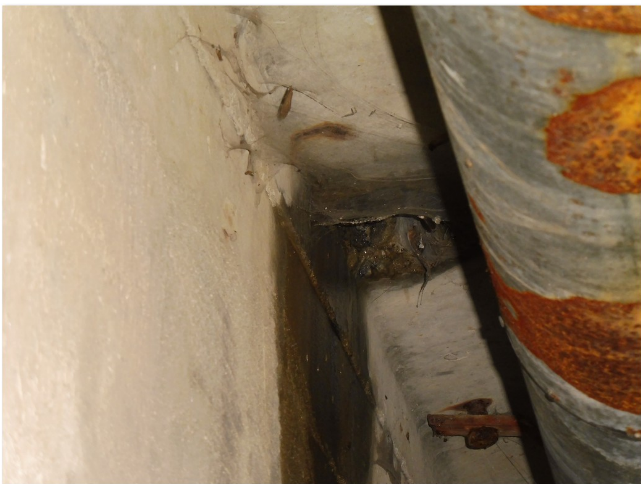
2.1-46 Pravá stěna nosníku č. 2.1 - zatékání nezapraveným montážním otvorem nad pilířem 2
