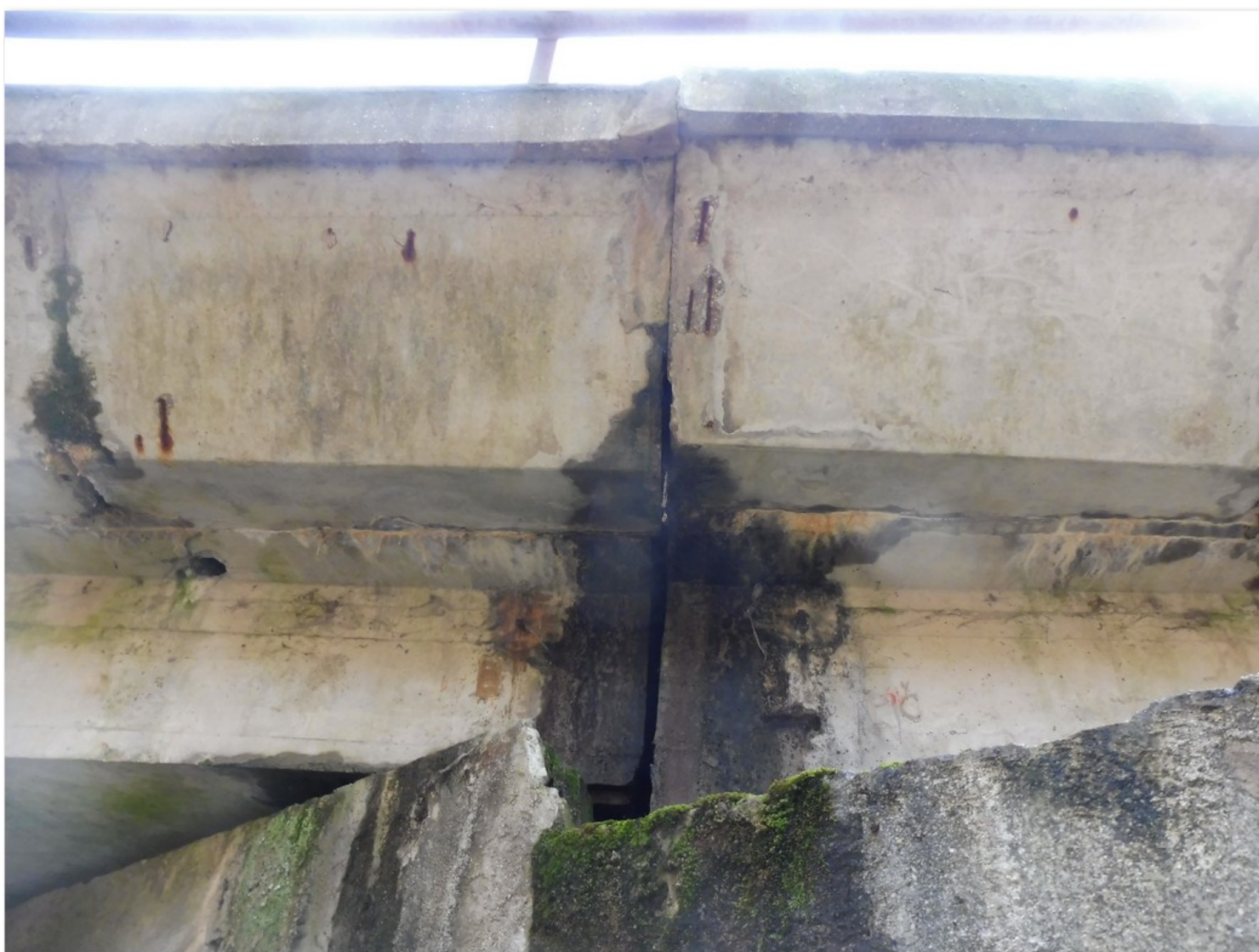
2.1-88 Dilatační spára mezi prefabrikovanými konzolami nad pilířem 2 vlevo - spára zavřená - mechanicky poškozený beton v římsové části
