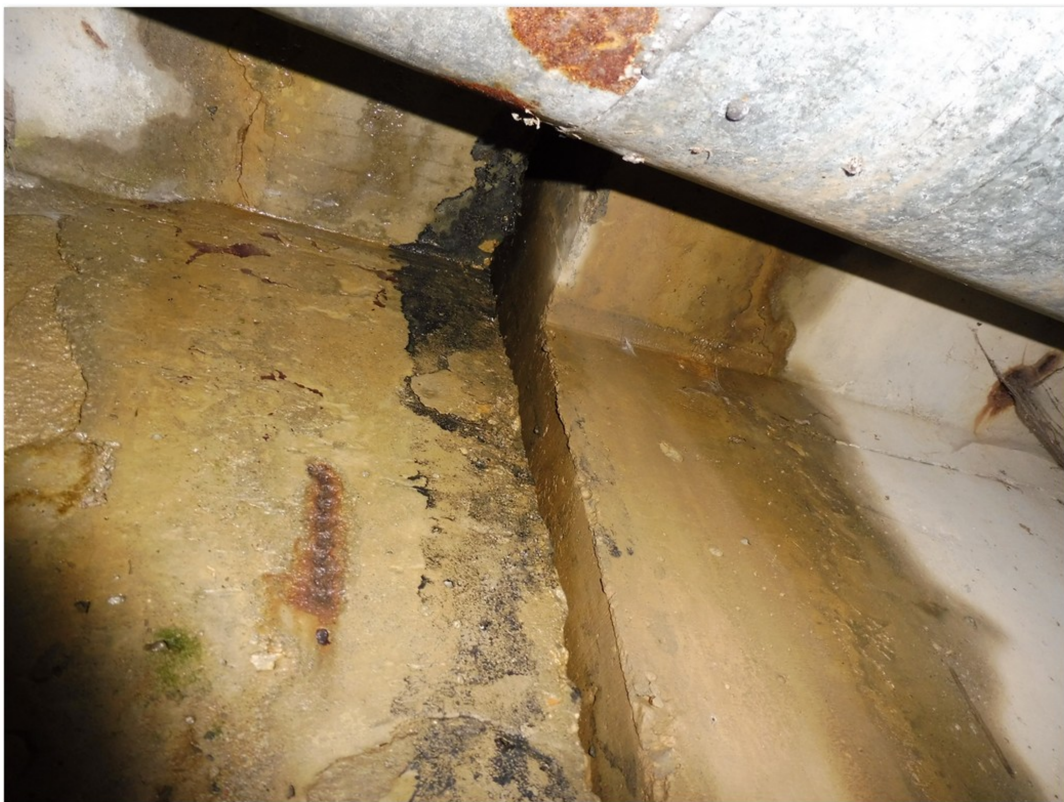
2.1-50 Mezera mezi čely nosníků č. 2.1 a č. 3.1 nad pilířem 3 - pohled zprava
