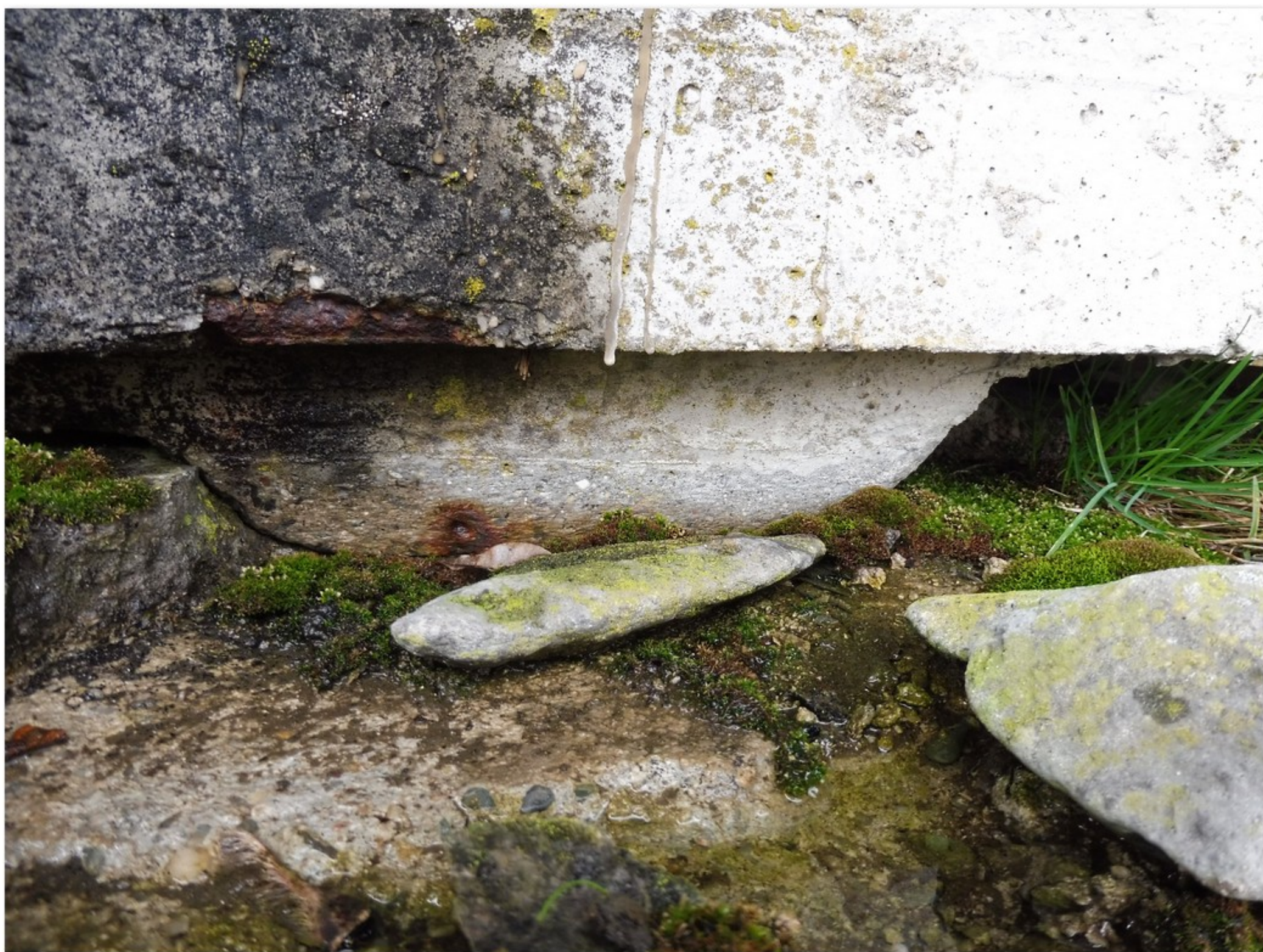
2.2-19 Uložení nosníku č. 3.2 na pilíři 3 vpravo
