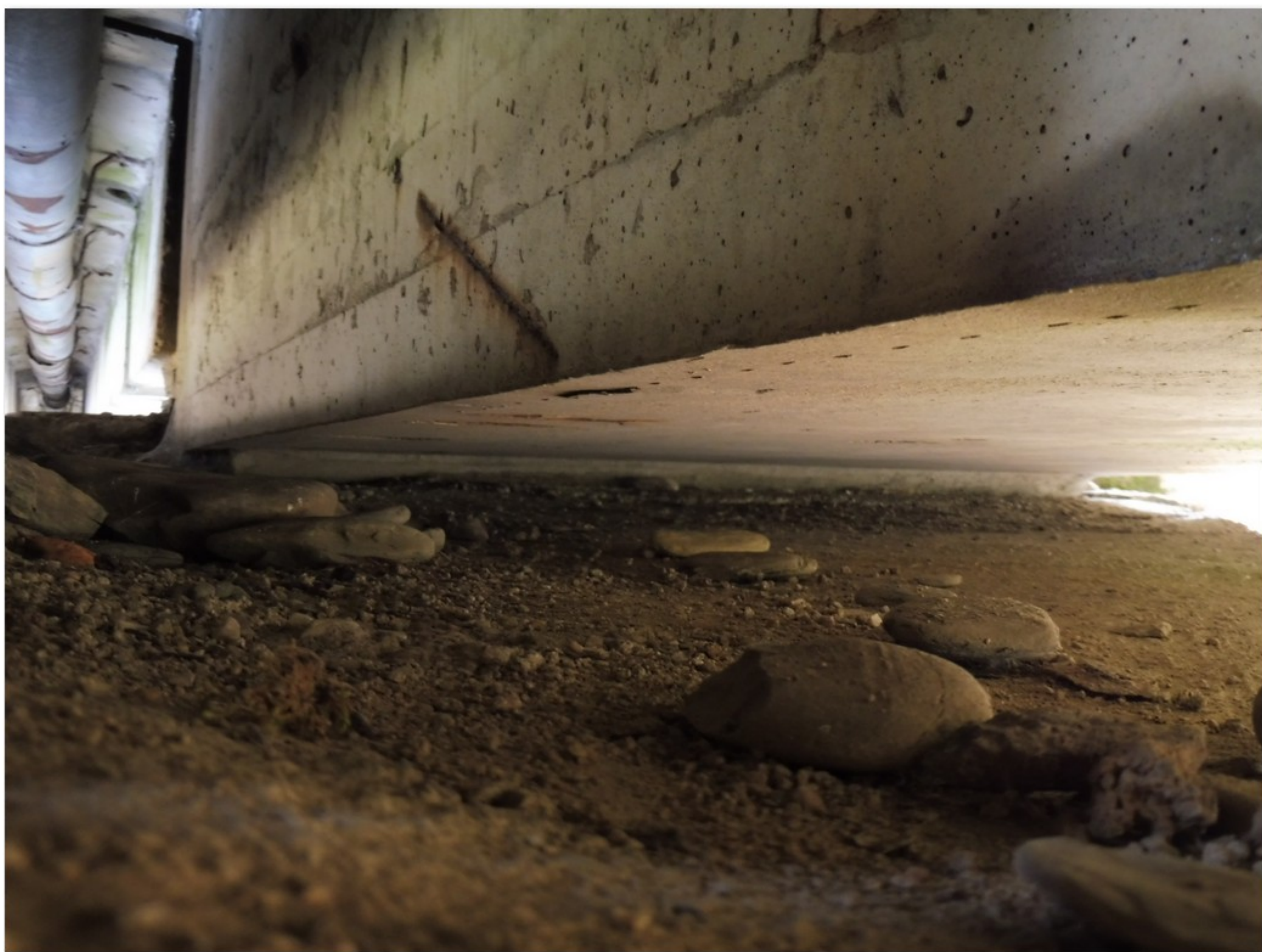
2.2-15 Uložení nosníku č. 3.1 na pilíři 3 - pohled proti směru staničení
