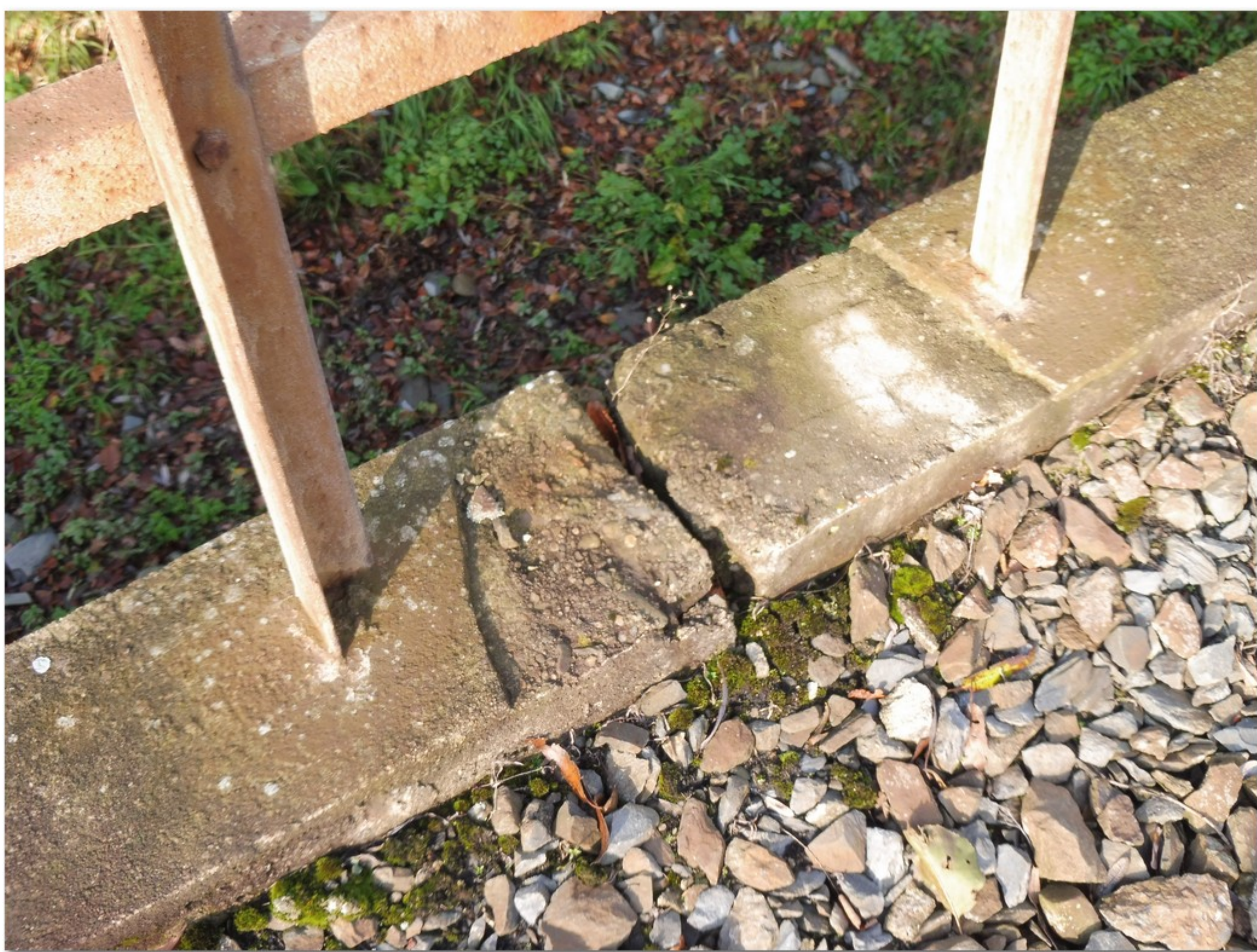
3.2-02 Dilatační spára levé římsy nad opěrou 1 - degradace betonu
