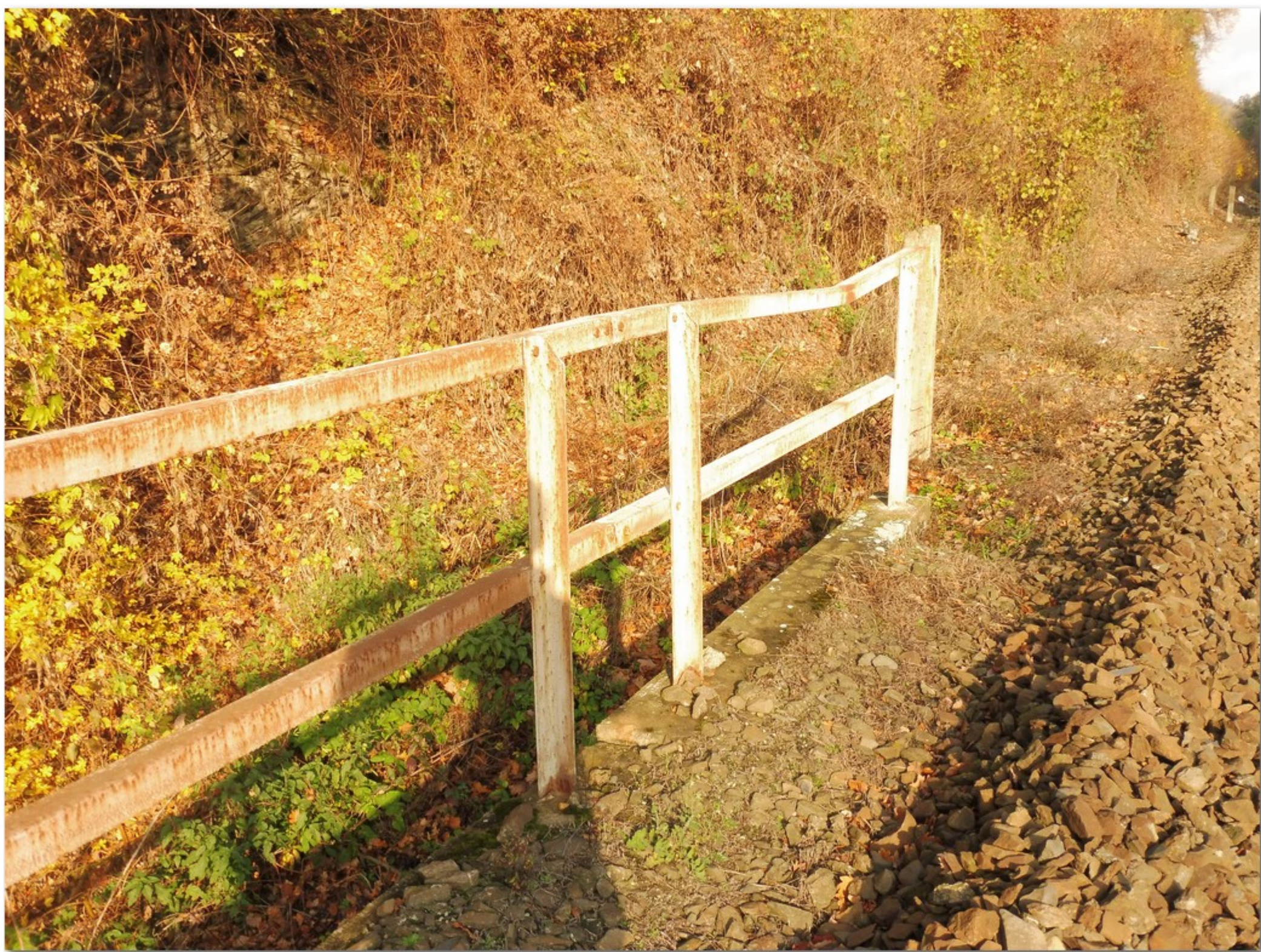
4.1-01 Zábradlí na levém křídle opěry 4 - mechanické poškození
