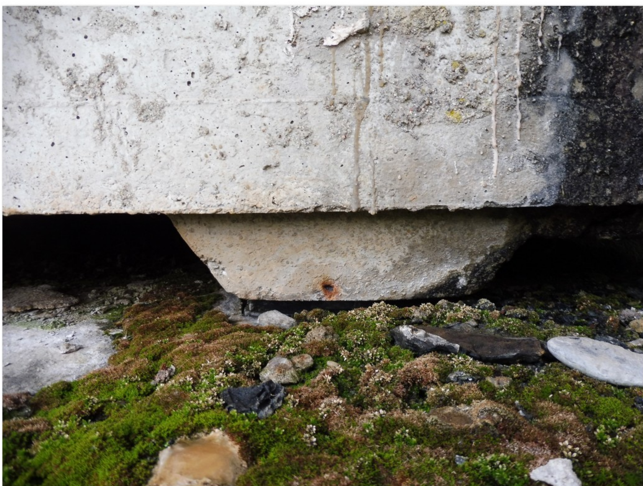
2.2-20 Uložení nosníku č. 3.2 na opěře 4 vpravo
