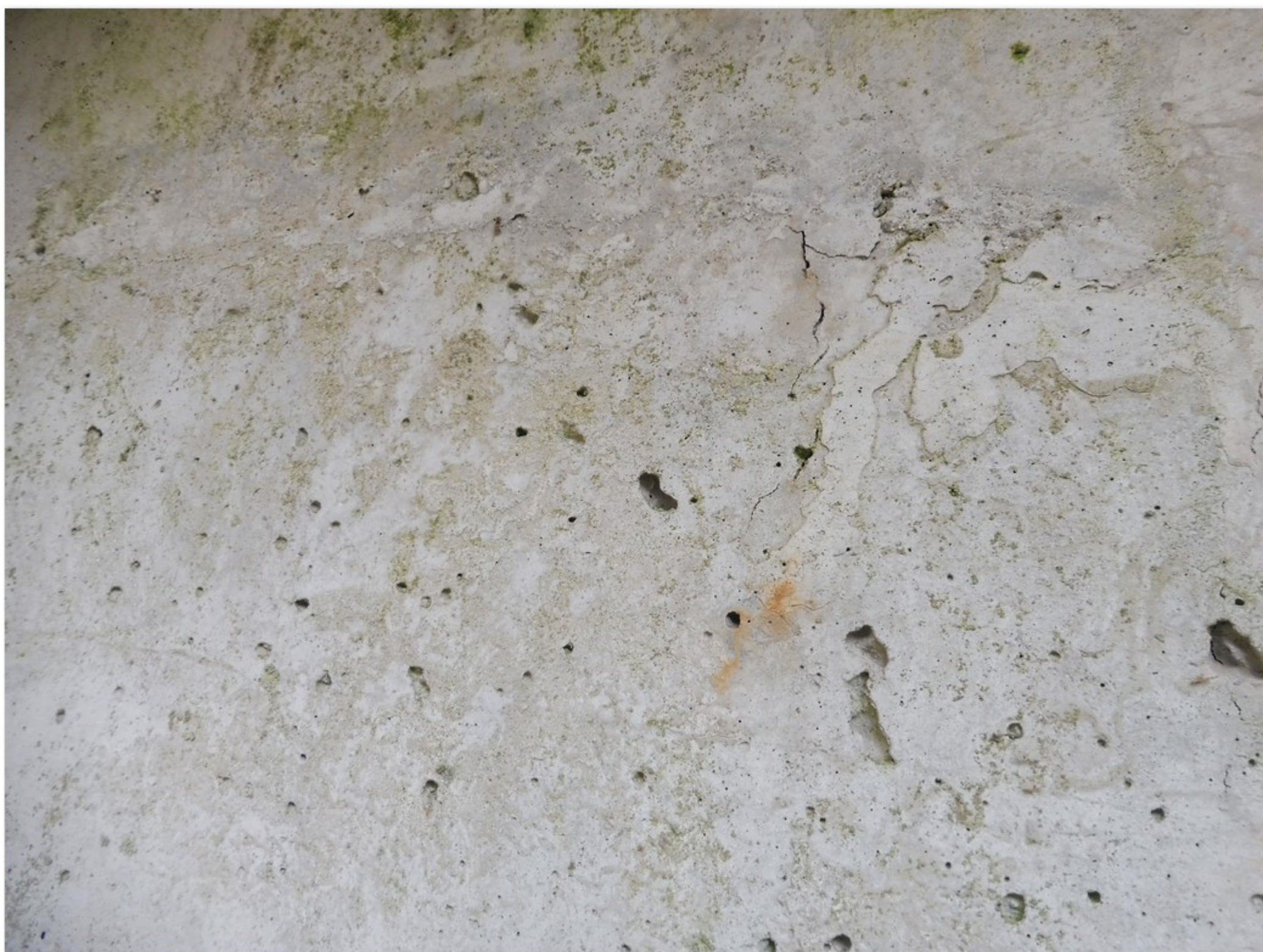
2.1-06 Trhliny v levé stěně nosníku č. 1.1 před opěrou 1
