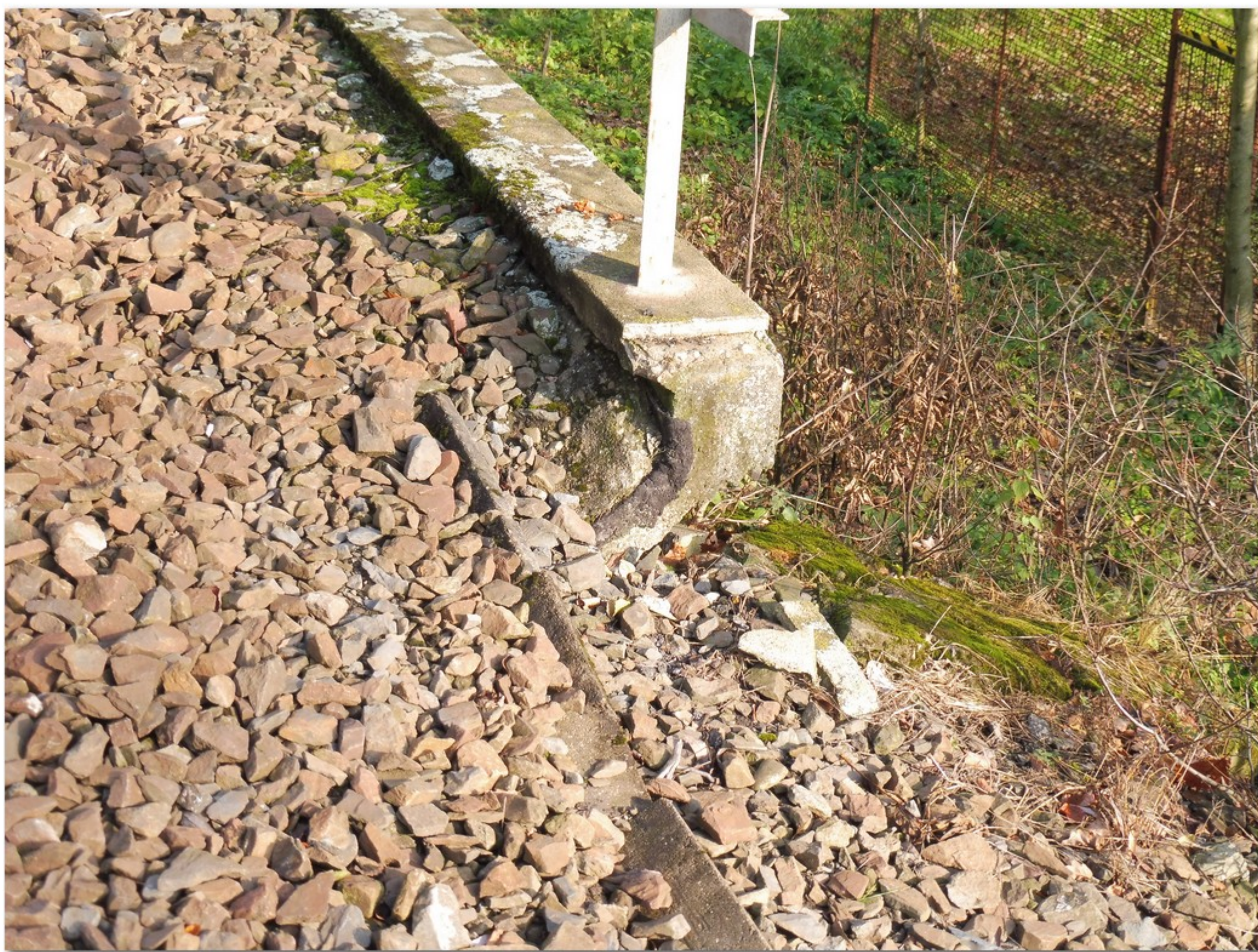
1.3-02 Obnažený konec pravé římsy před opěrou 1
