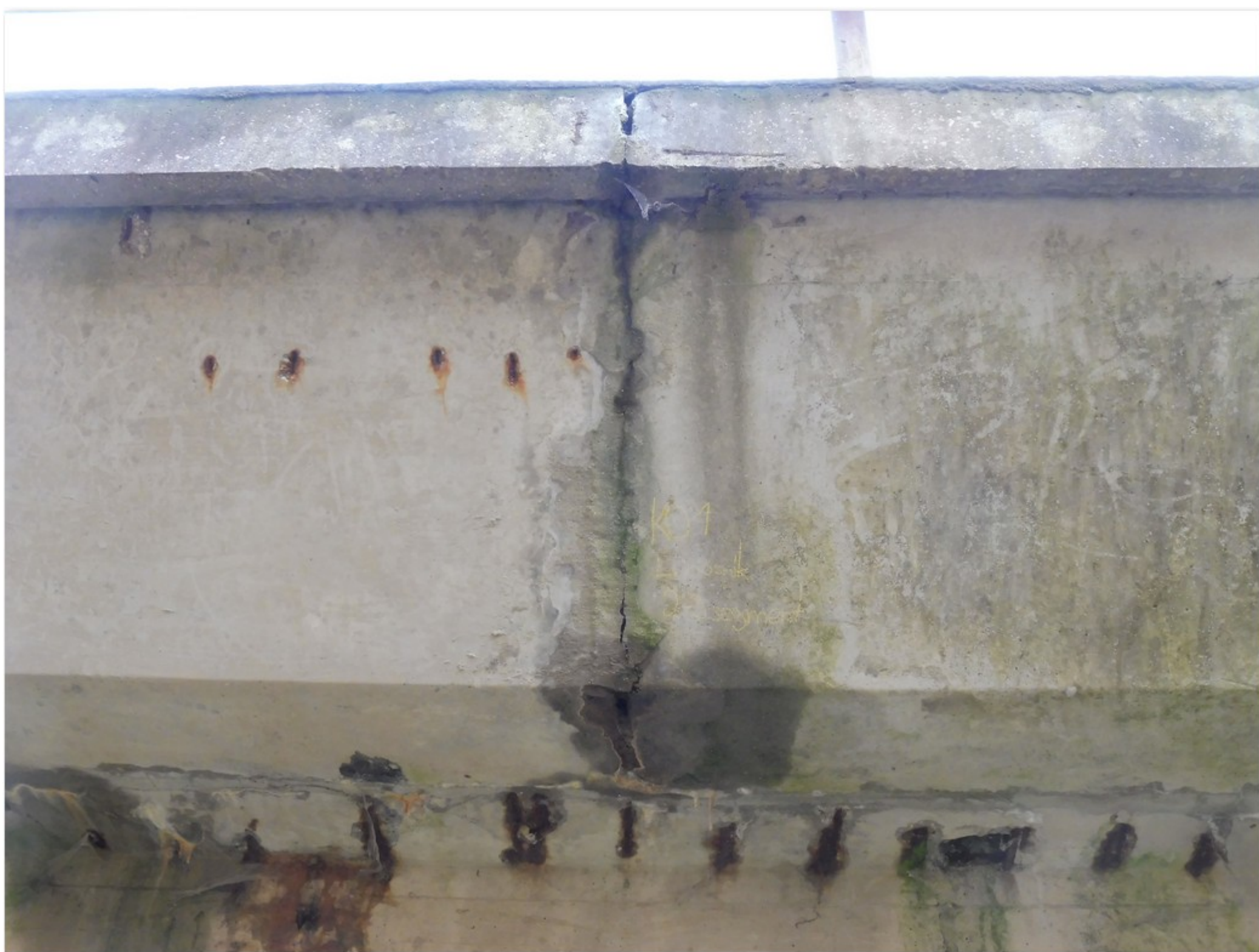
2.1-84 Detail fotografie č. 2.1-83 - stopy zatékání v příčné spáře - degradace výplně spáry
