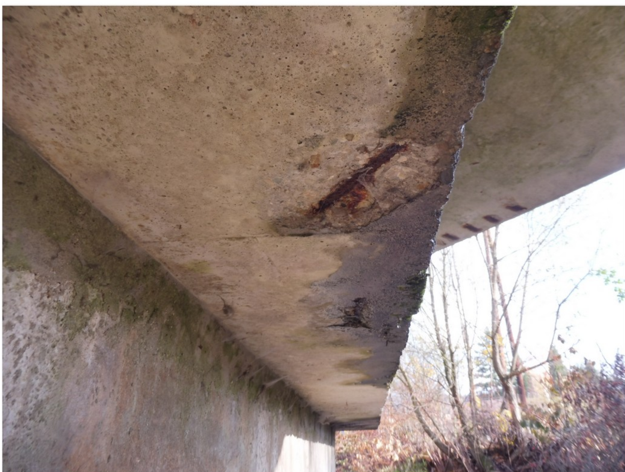
1.2-20 Úložný práh pilíře 2 - beton odlomený působením rozpínavých účinků korozních zplodin výztuže
