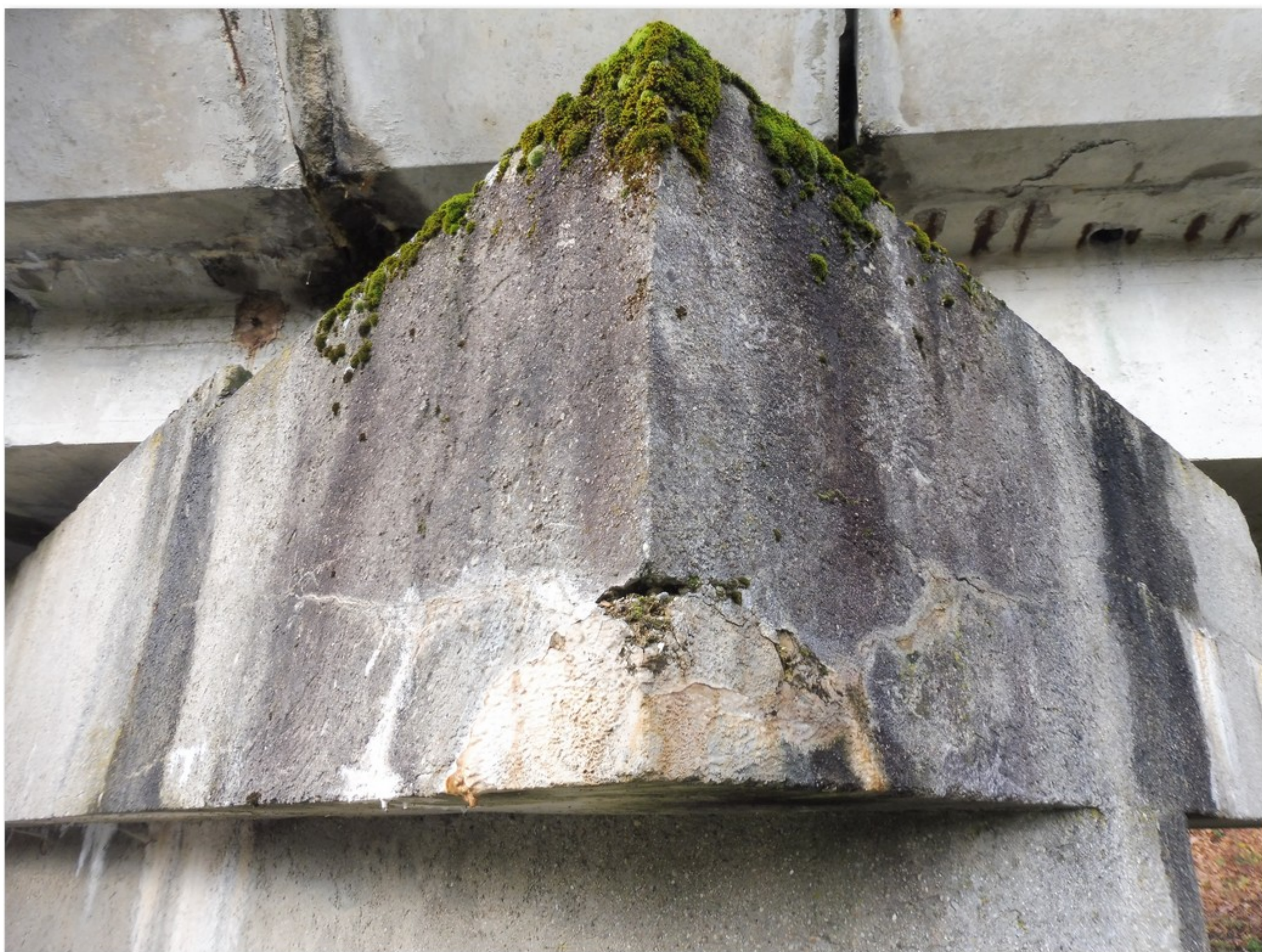
1.2-39 Trhliny s výluhy v úložném prahu pilíře 3
