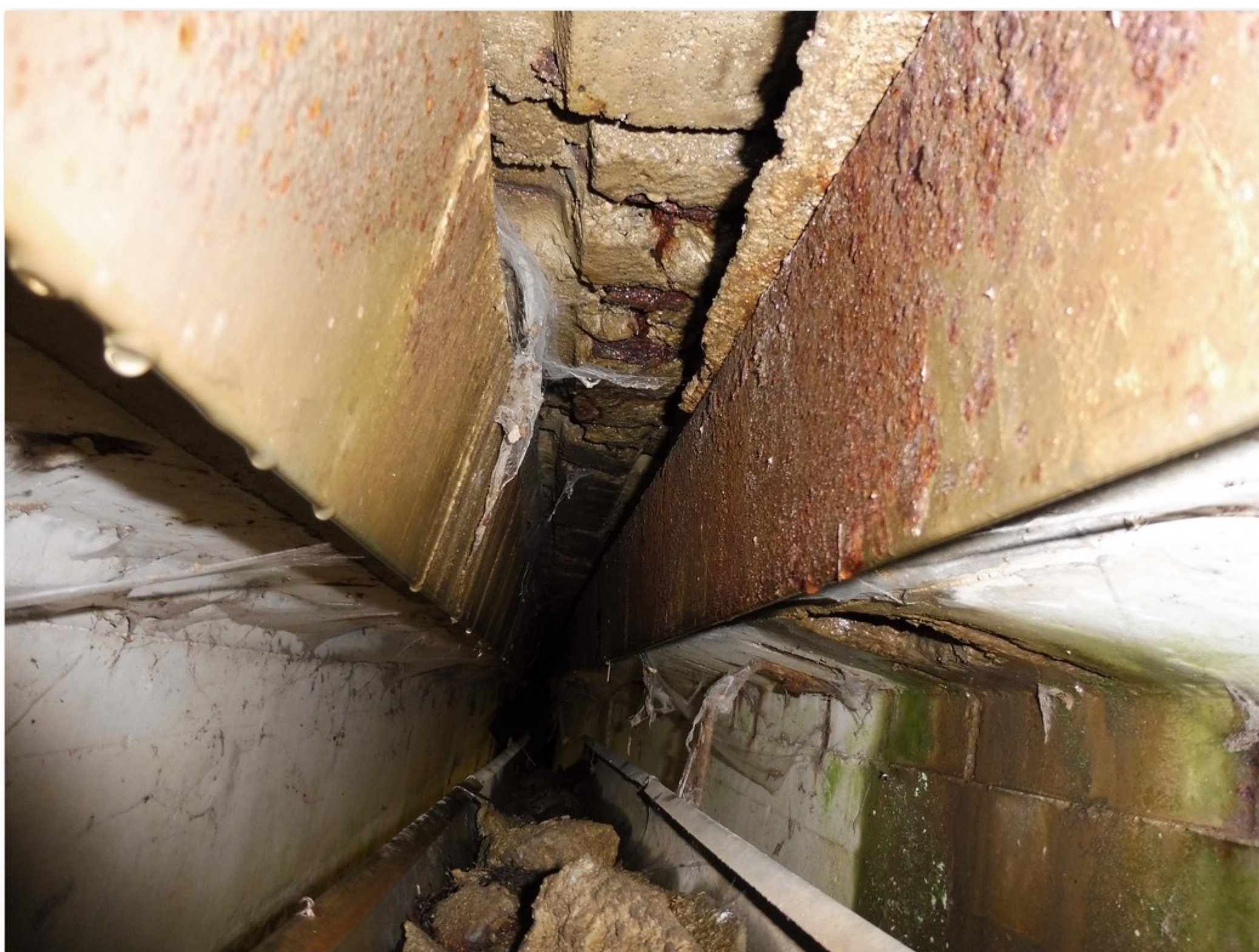
2.1-32 Prostor mezi konzolami nebo též horními přírubami nosníků č. 1.1 a č. 1.2
