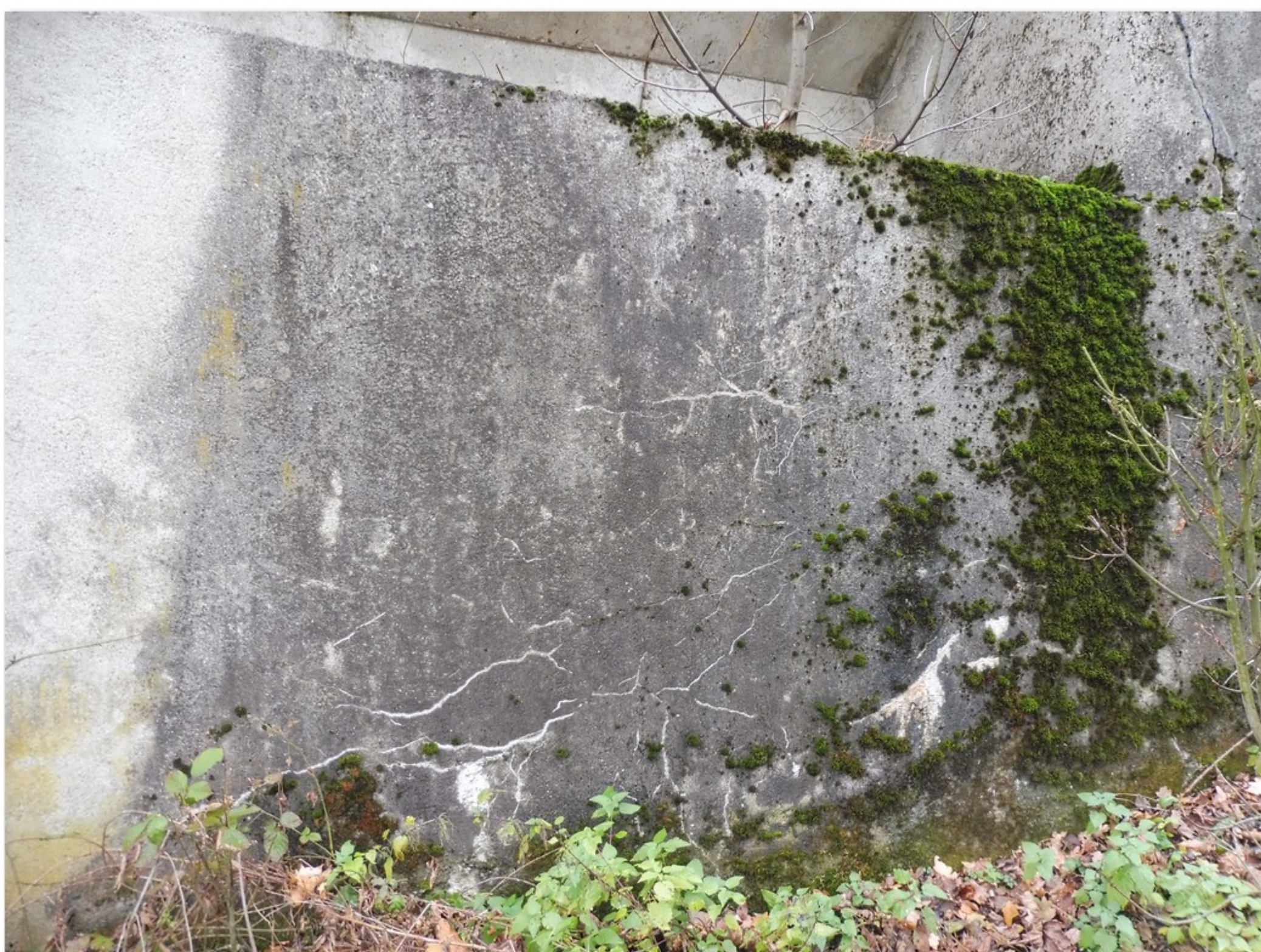
1.2-67 Opěrná zeď před pravým křídlem opěry 4 - síť trhlín s výluhy
