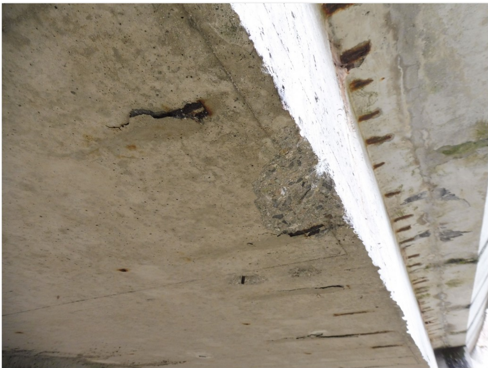
2.1-78 Dno nosníku č. 3.2 - mechanické poškození
