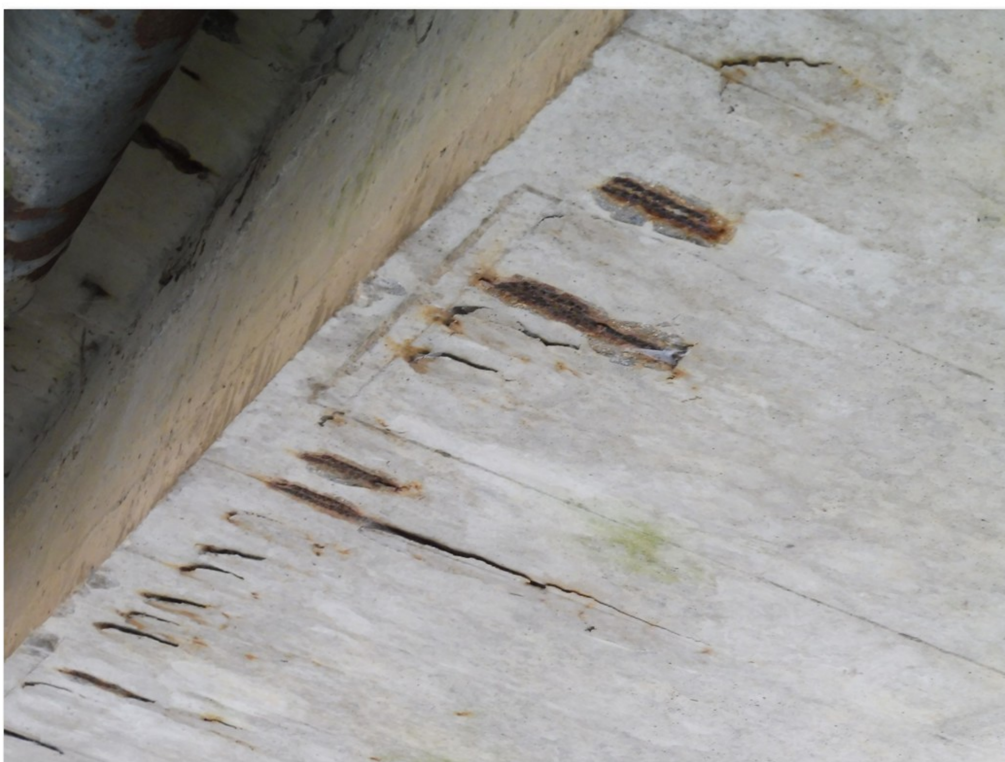
2.1-55 Detail fotografie č. 2.1-54 - korodující výztuž s nedostatečným krytím - beton odlomený působením rozpínavých účinků korozních zplodin
