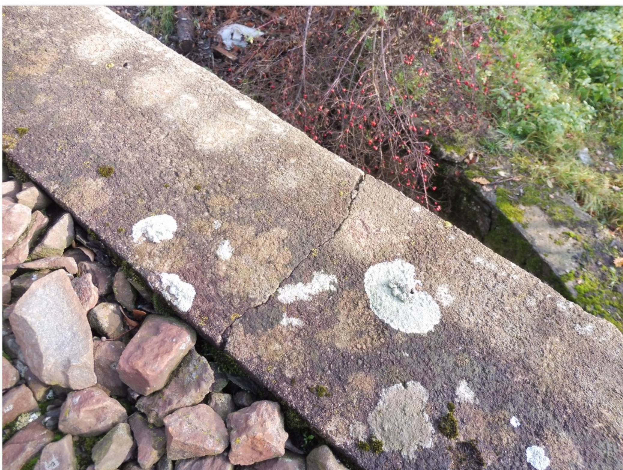
3.2-11 Povrch pravé římsy - příčná trhlina
