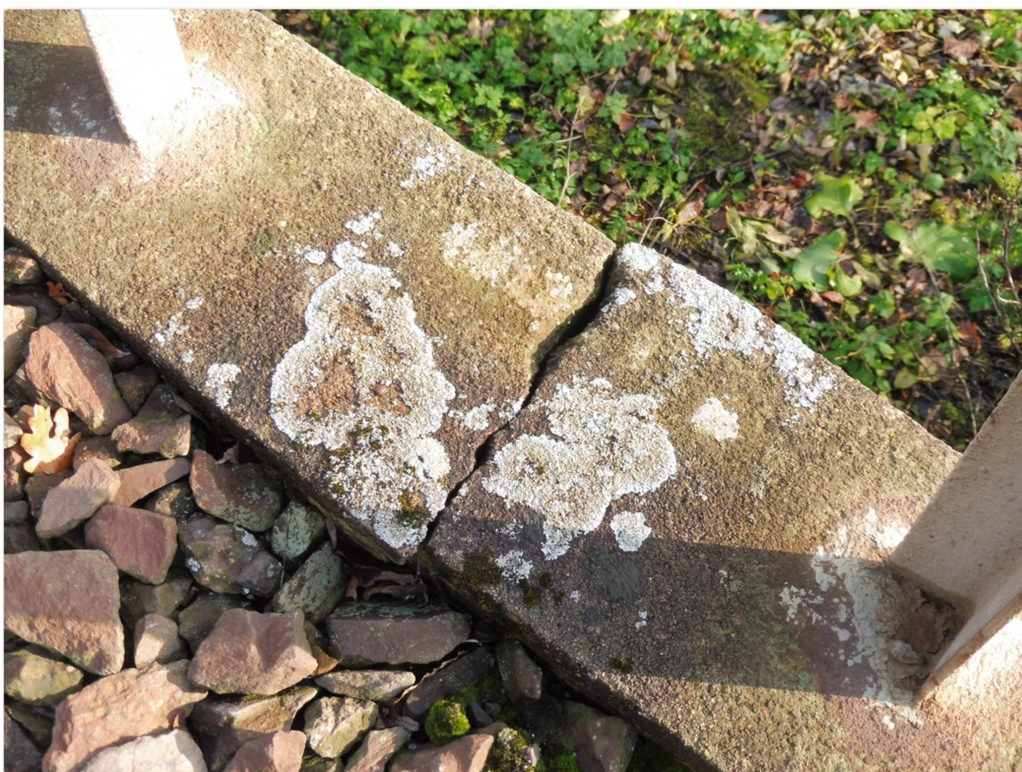
3.2-09 Dilatační spára pravé římsy nad opěrou 1
