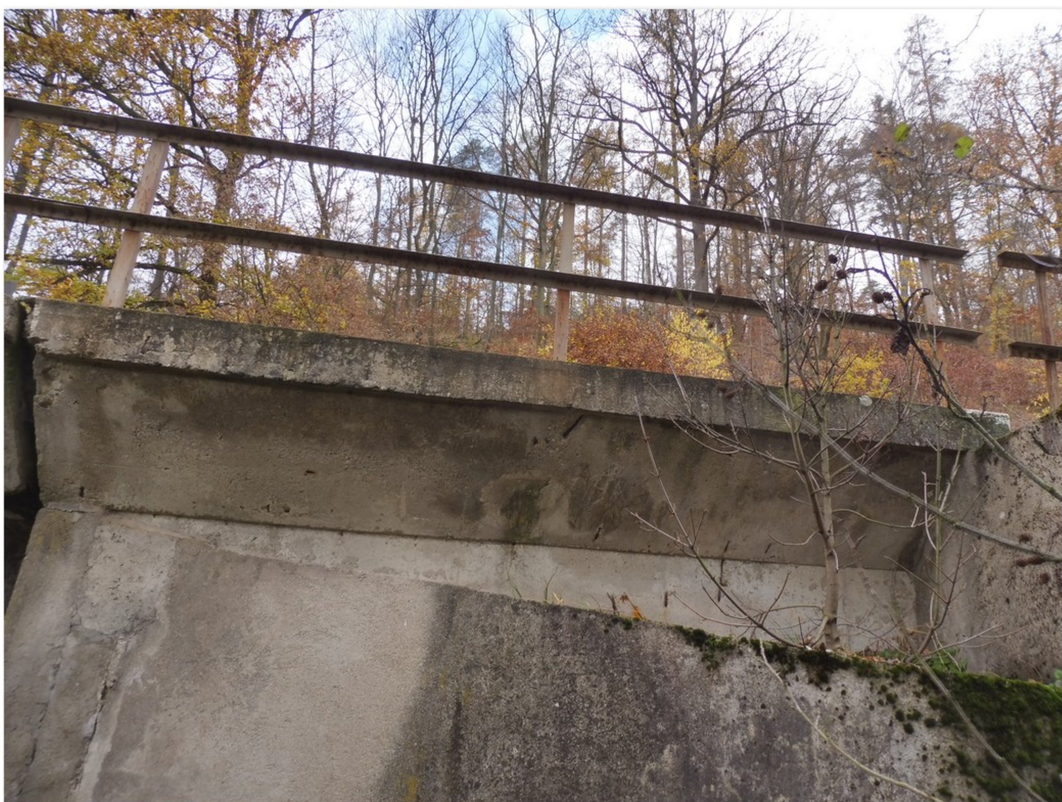
1.2-70 Pravé křídlo opěry 4 - v konzole trhliny se stopami zatékání - beton odlomený působením rozpínavých účinků korozních zplodin výztuže
