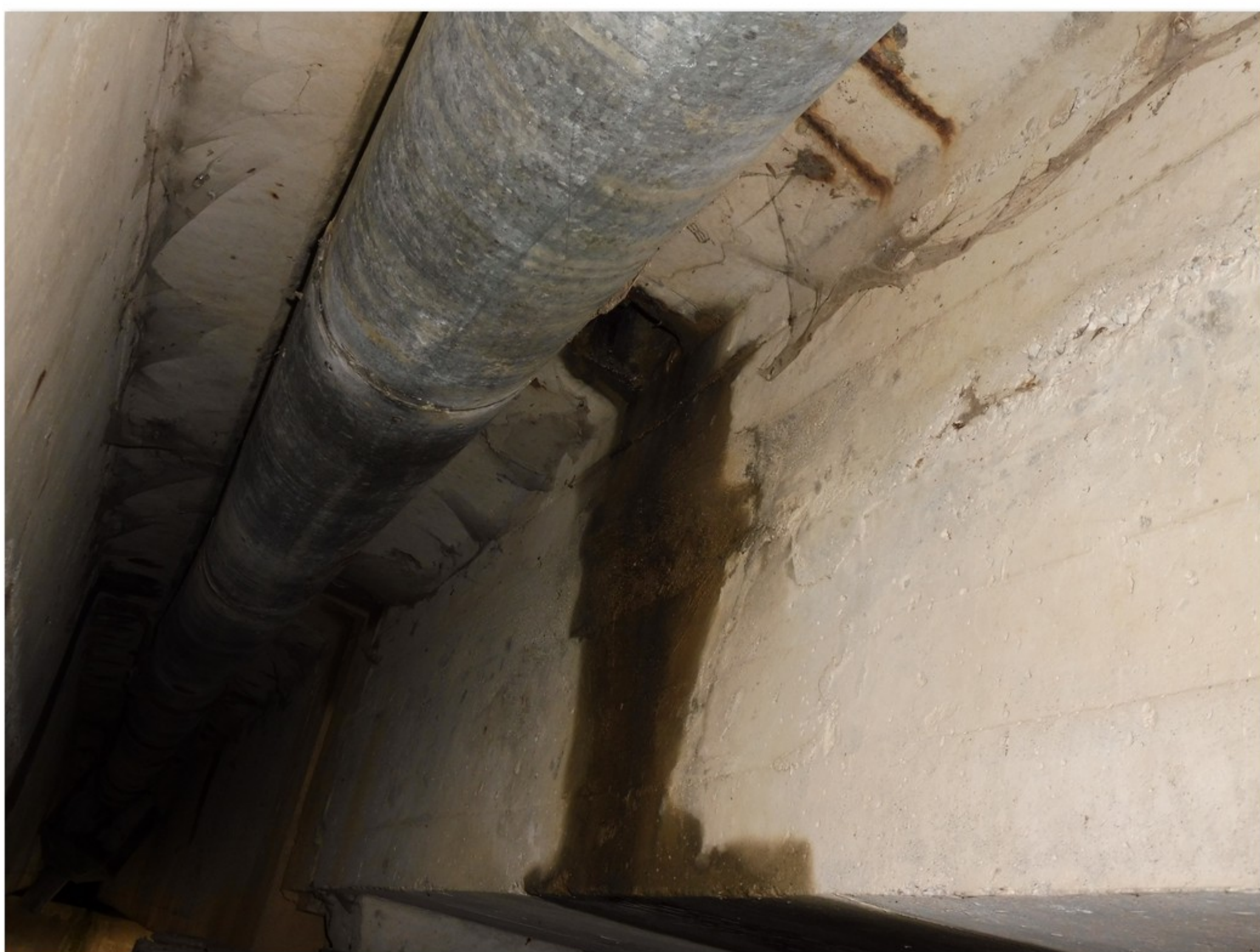
2.1-53 Levá stěna nosníku č. 2.2 - zatékání nezapraveným montážním otvorem nad pilířem 3
