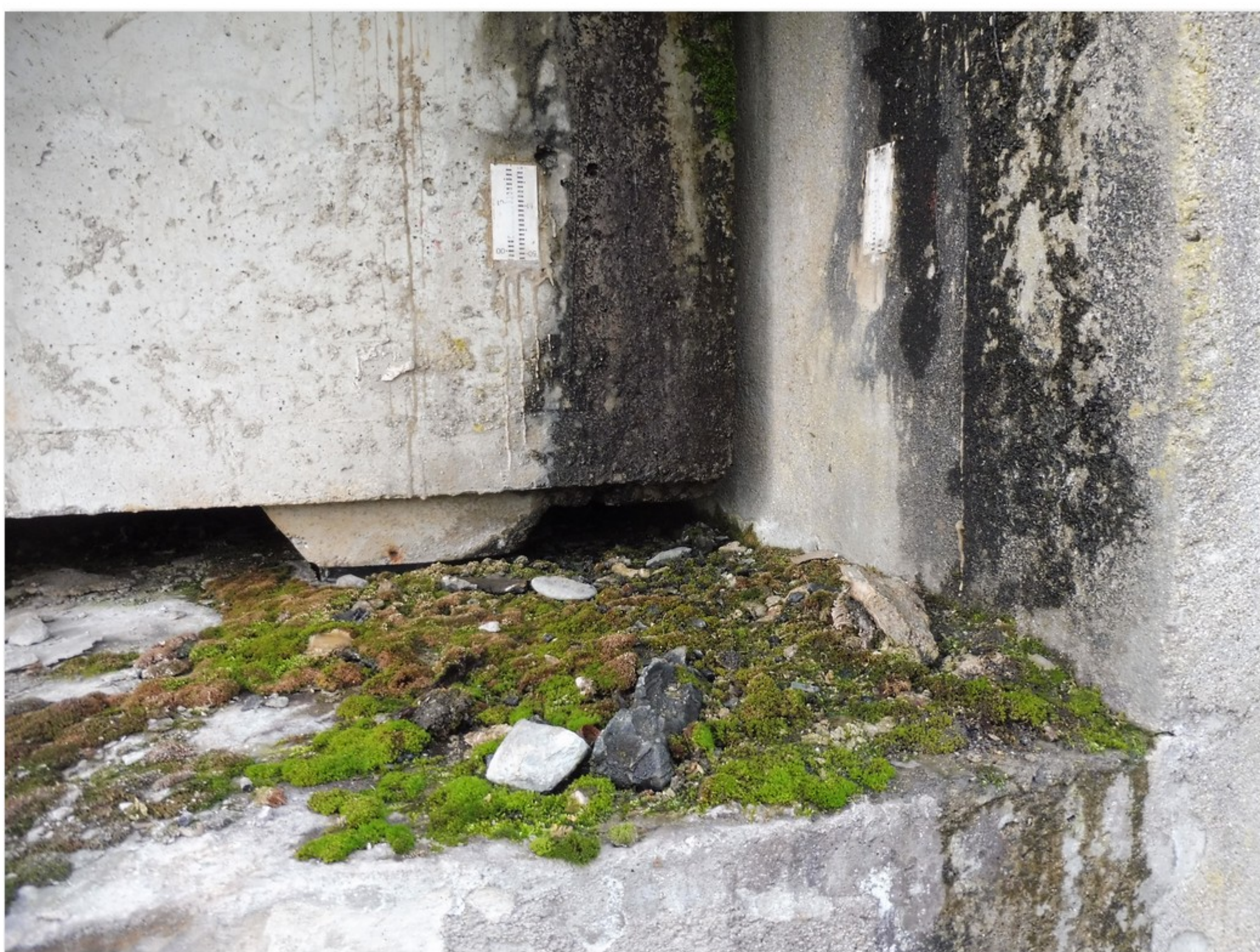
1.2-65 Úložný práh u pravého čela opěry 4 - vegetace uchycená v naplavených nečistotách
