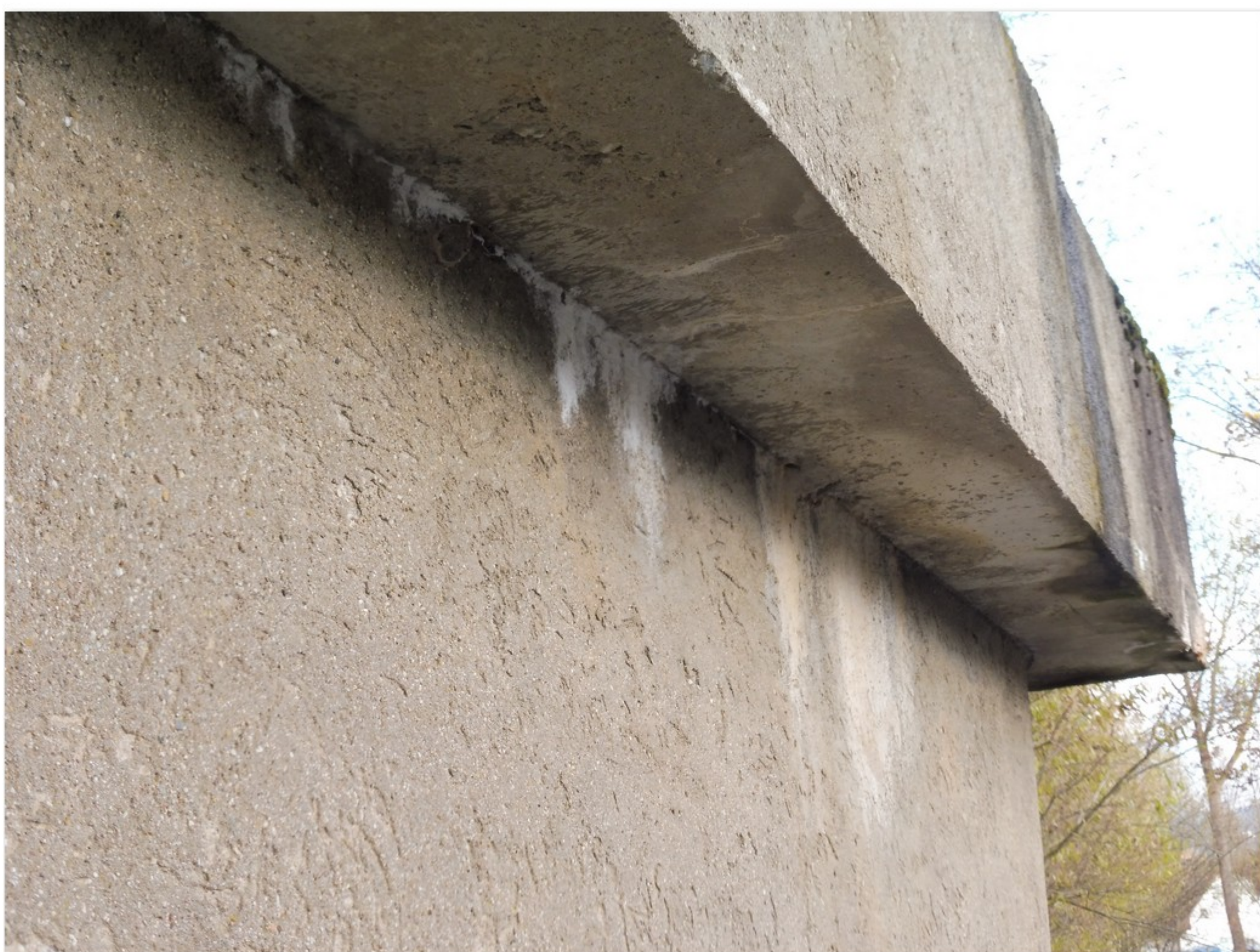
1.2-36 Znamky zatékání ve spáře mezi dříkem a úložným prahem pilíře 3
