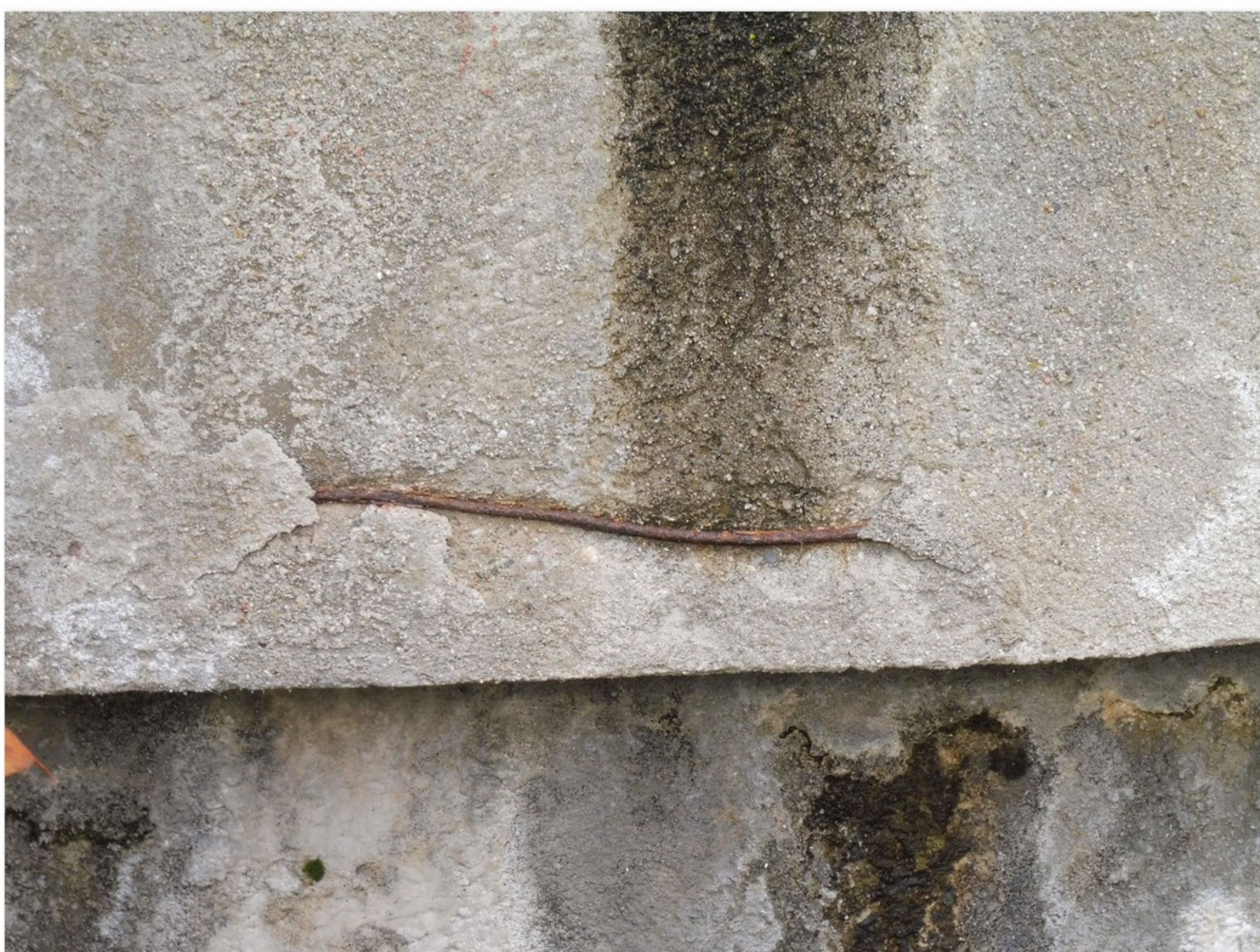
1.2-63 Úložný práh opěry 4 - korodující výztuž s nedostatečným krytím
