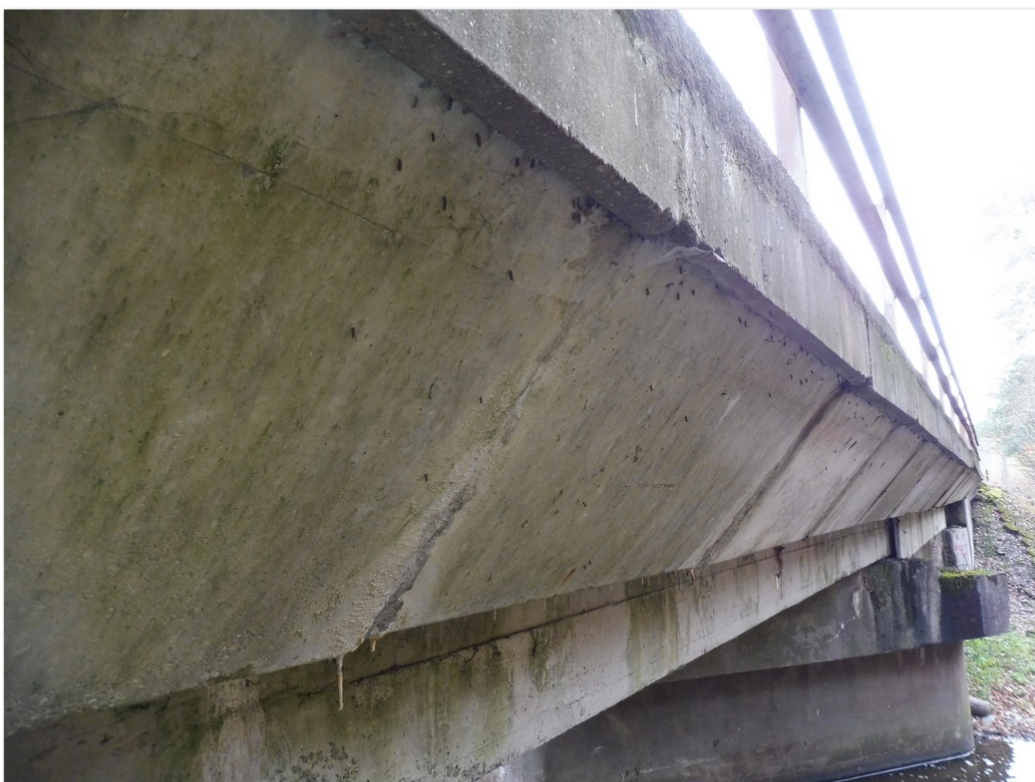
2.1-87 Prefabrikované konzoly na levém okraji mostu ve 2. poli
