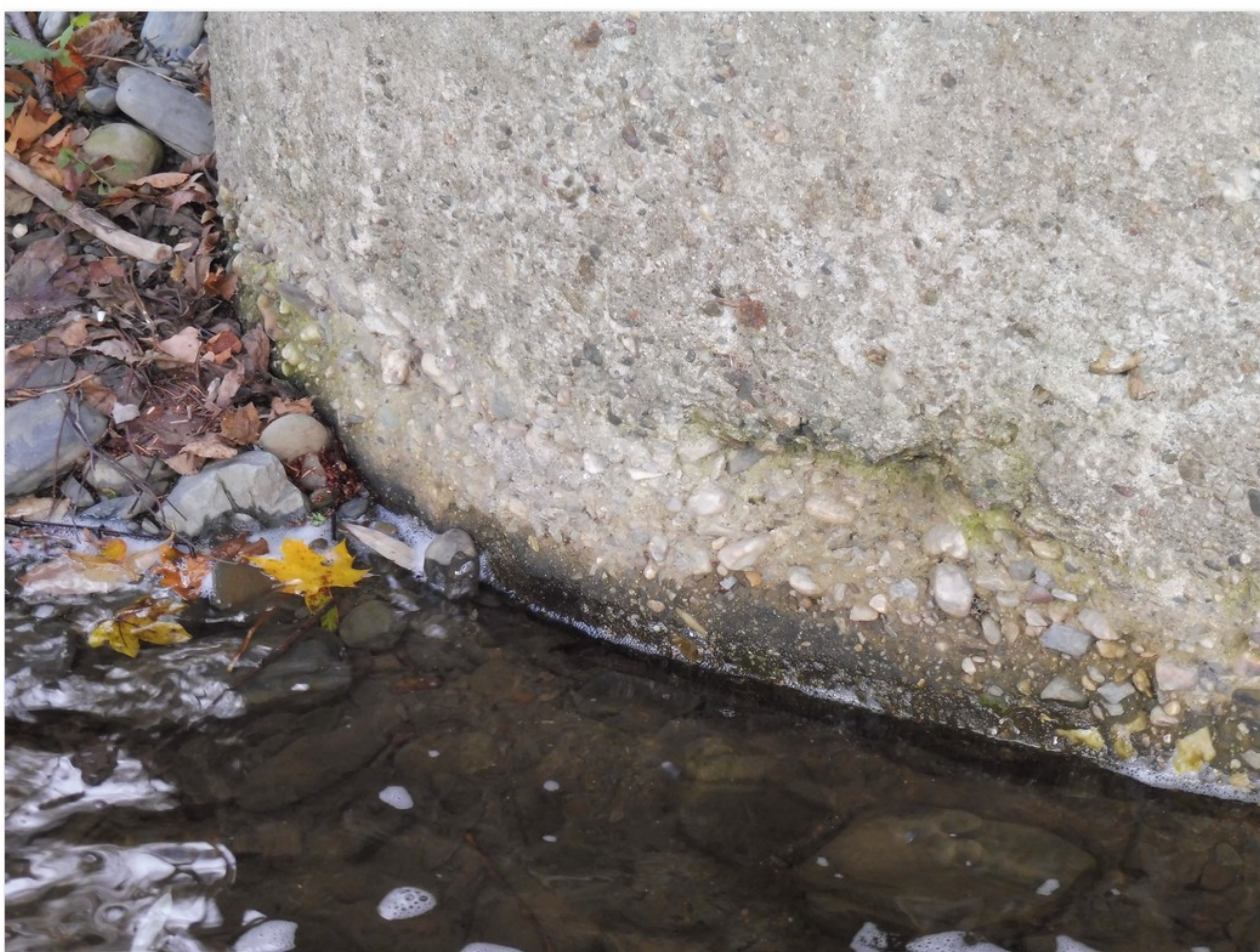
1.2-38 Degradace betonu v patě dříku pilíře 3 způsobená prouděním vody
