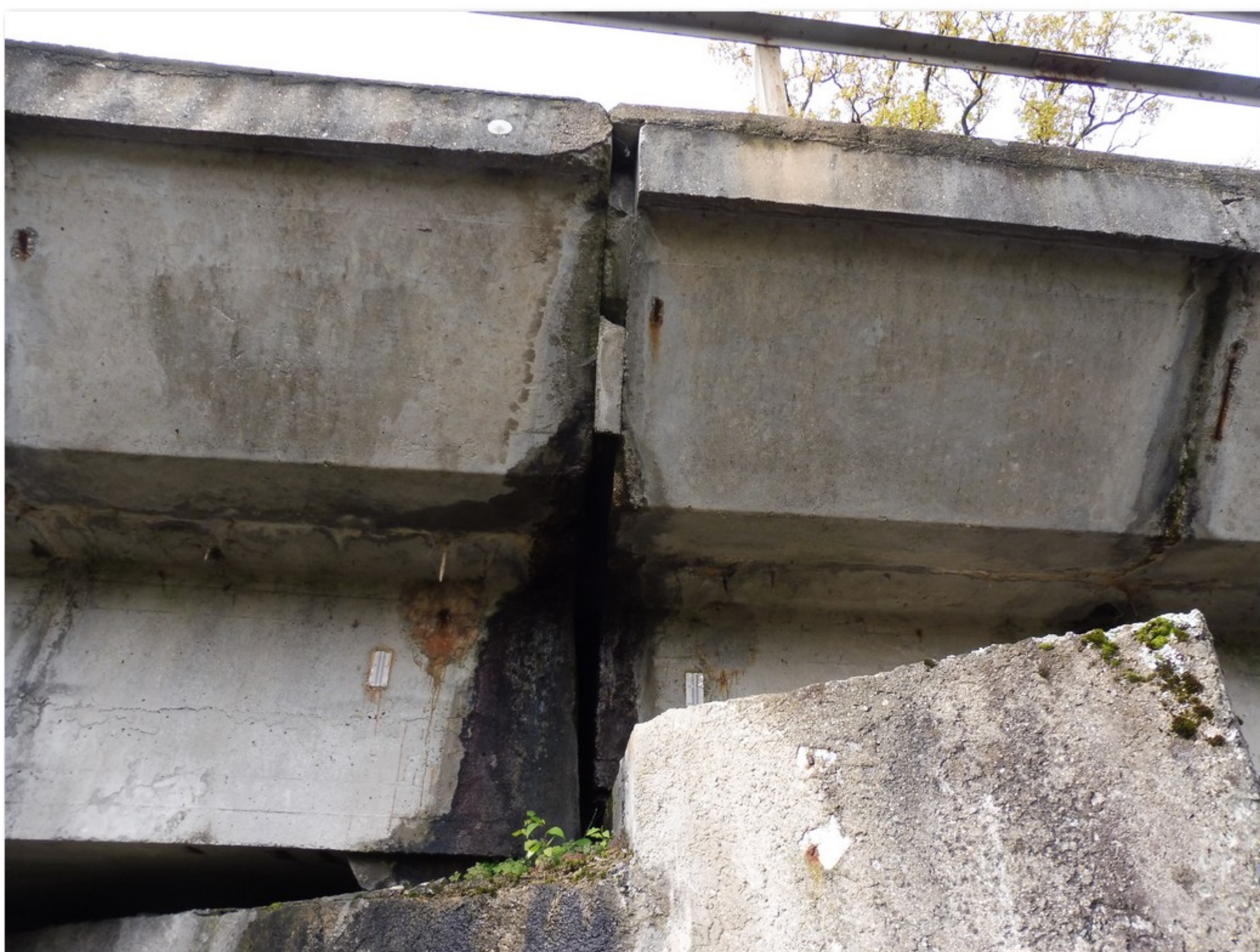
2.1-31 Mezera mezi čely nosníků č. 1.2 a č. 2.2 nad pilířem 2
