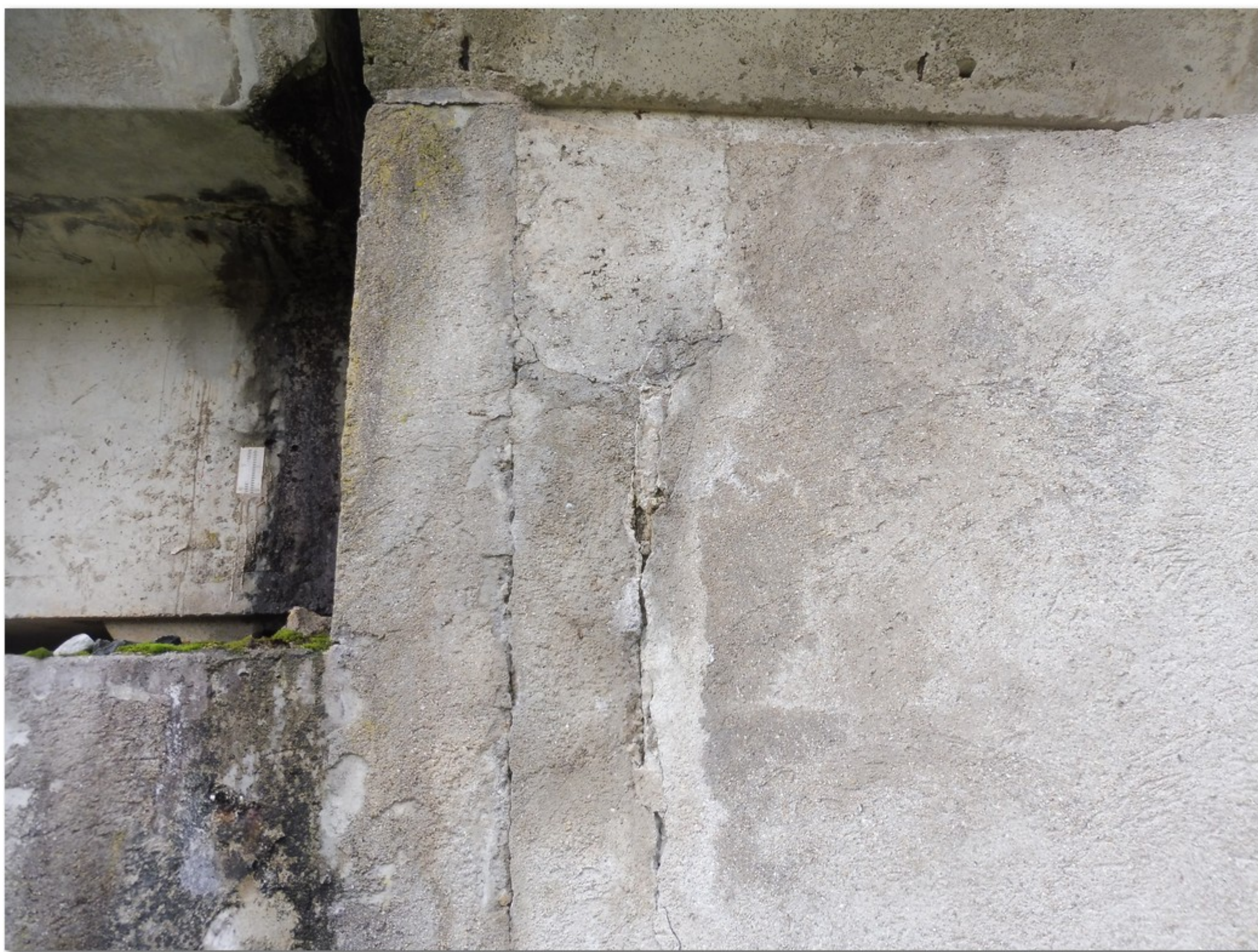
1.2-66 Pravé čelo opěry 4 - praskliny mezi závěrnou zídkou a křídlem resp. opěrnou zdí
