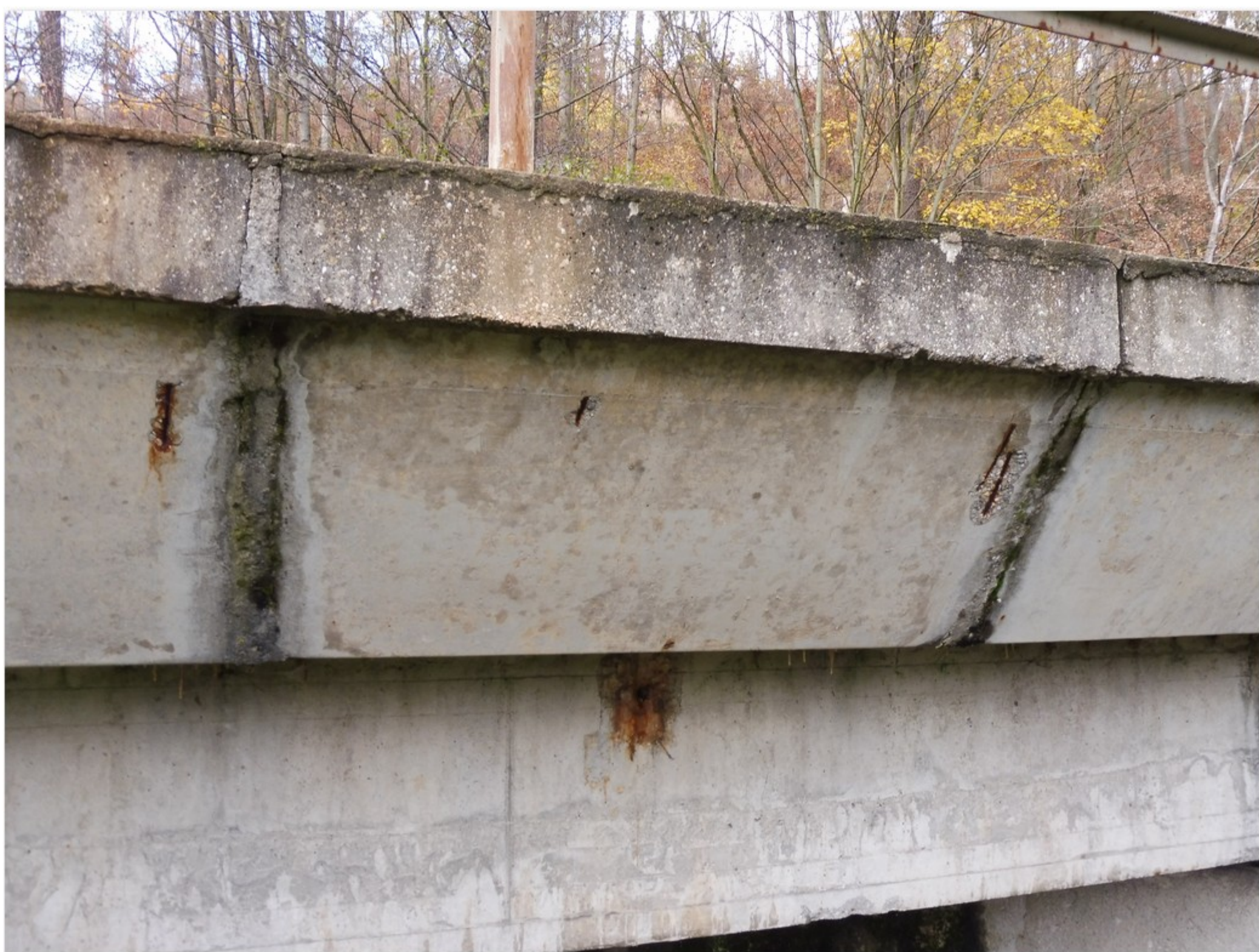
2.1-86 Prefabrikované konzoly na pravém okraji mostu v 1. poli
