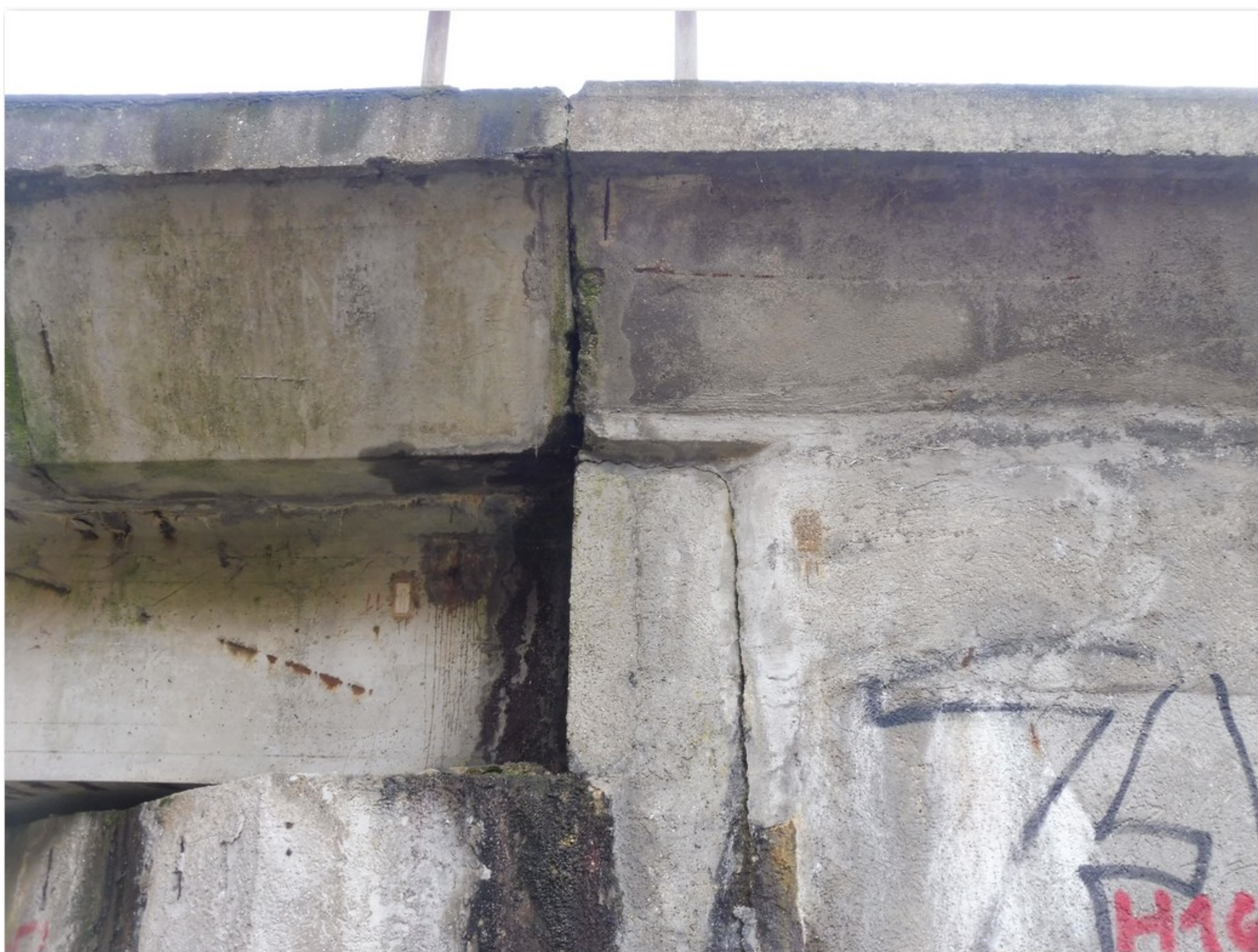
1.2-05 Levé čelo opěry 1 - prasklina mezi závěrnou zídou a křídlem
