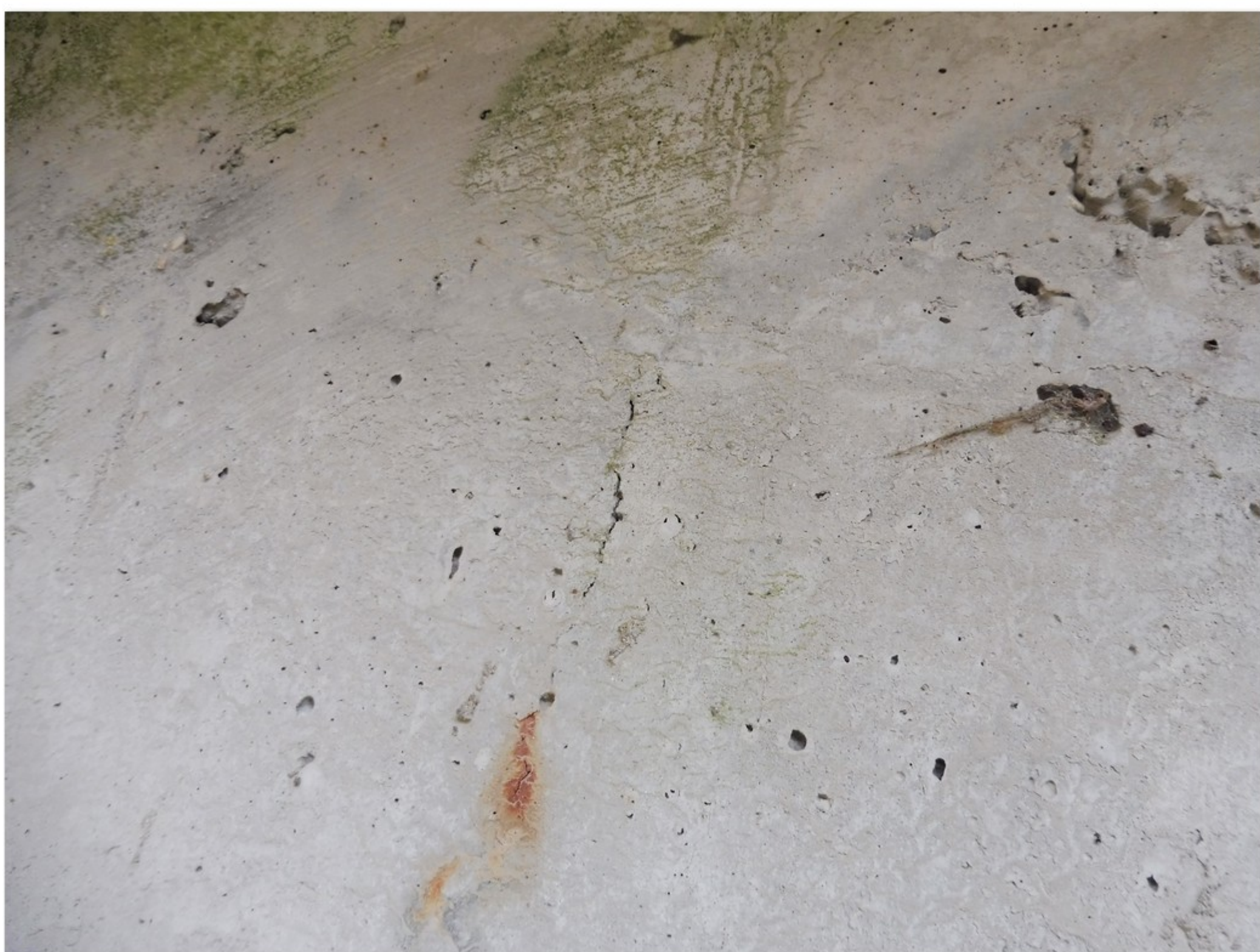
2.1-07 Trhliny v levé stěně nosníku č. 1.1 před opěrou 1
