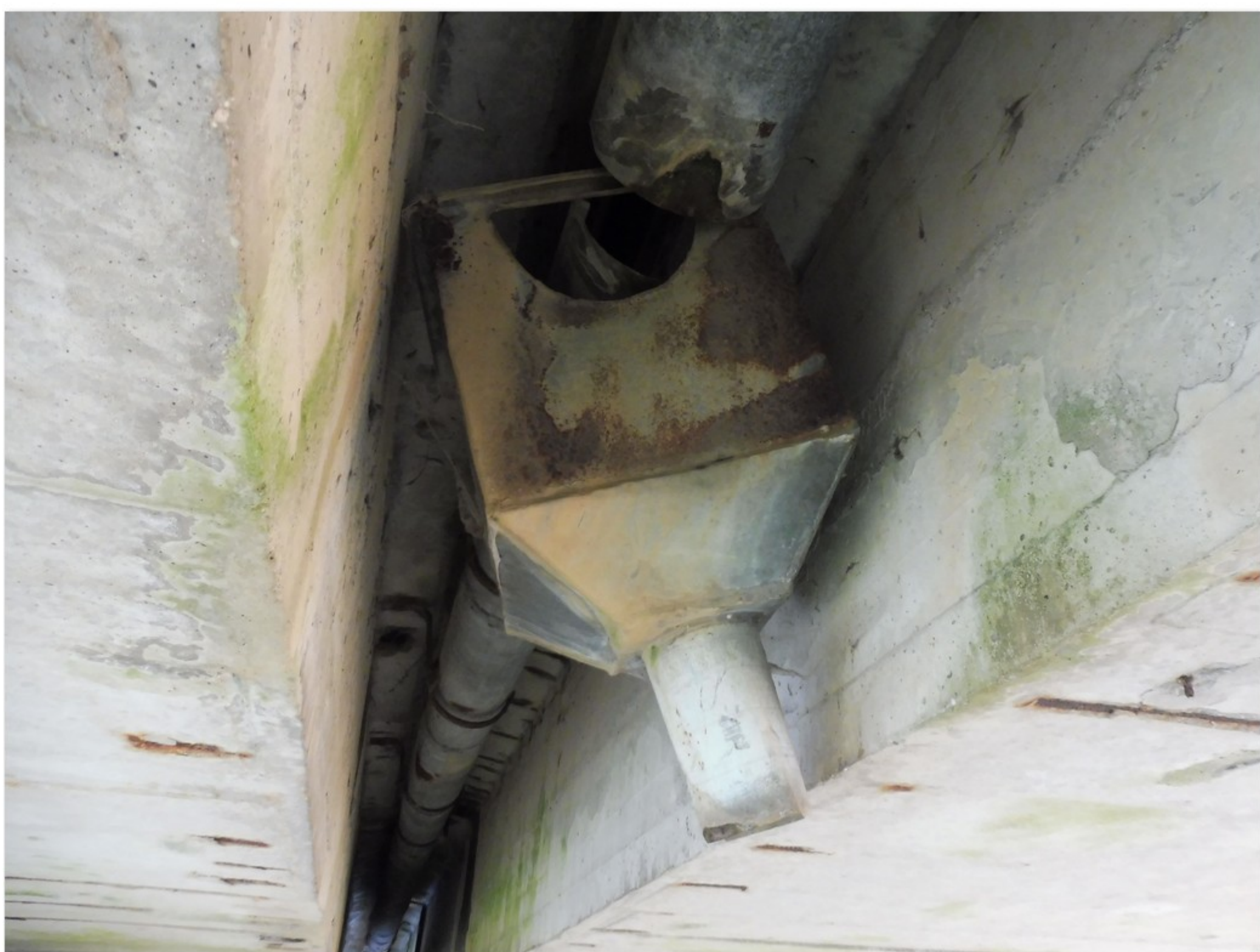
3.4-04 Porucha odvodňovacího žlabu ve 3. poli - uvolněný kotlík
