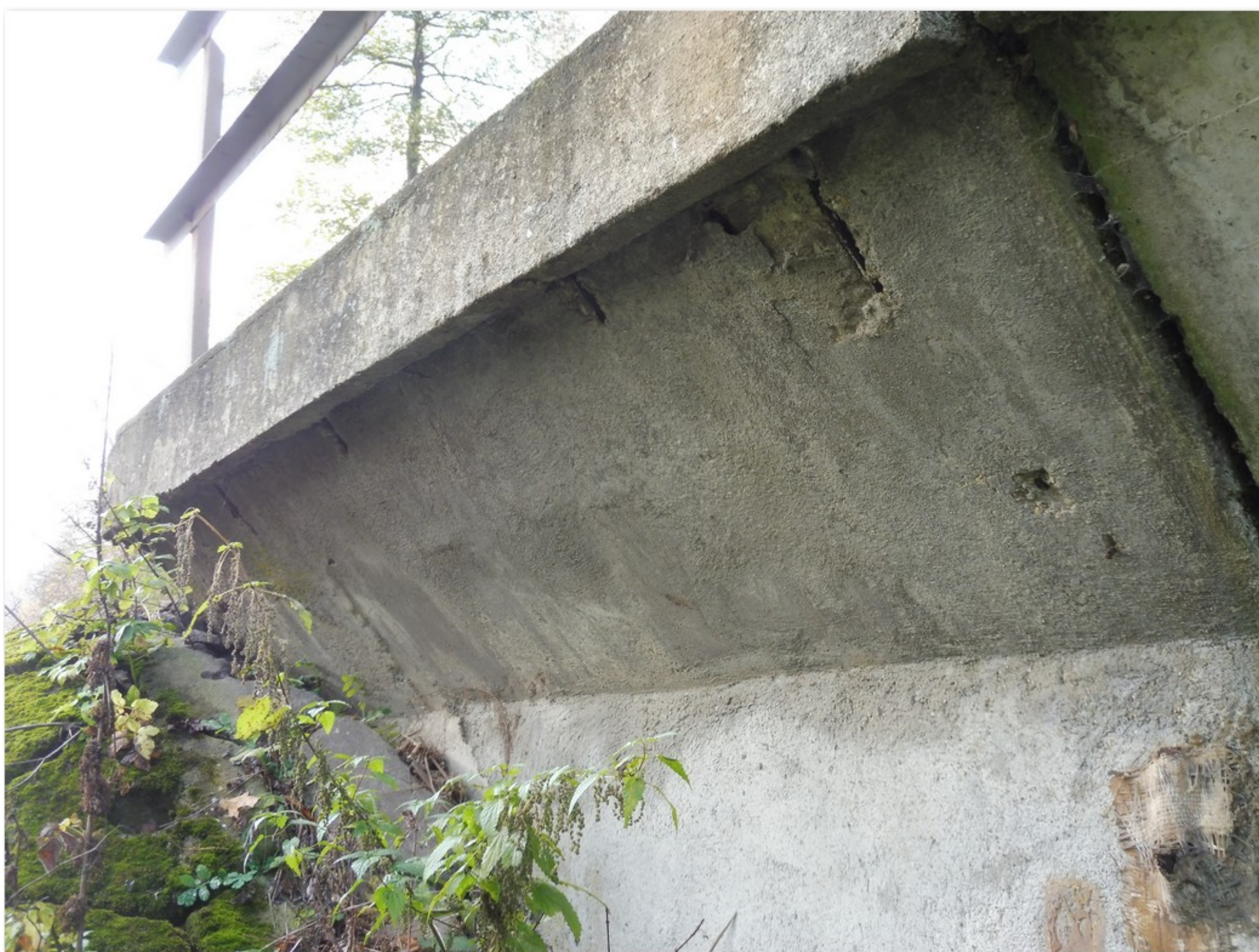
1.2-09 Pravá konzola opěry 1 - korodující výztuž s nedostatečným krytím
