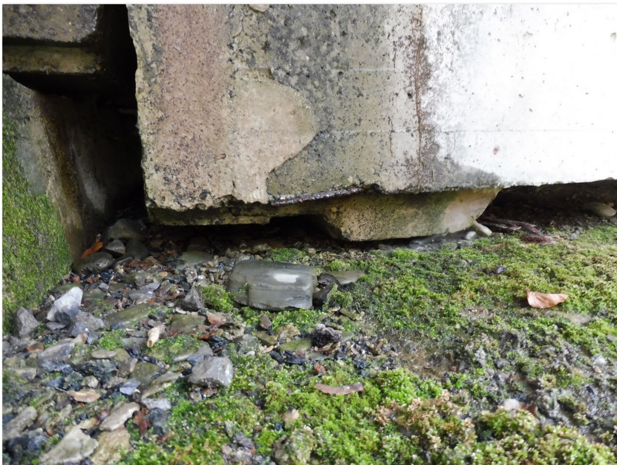
2.2-02 Uložení nosníku č. 1.1 na pilíři 2 vlevo
