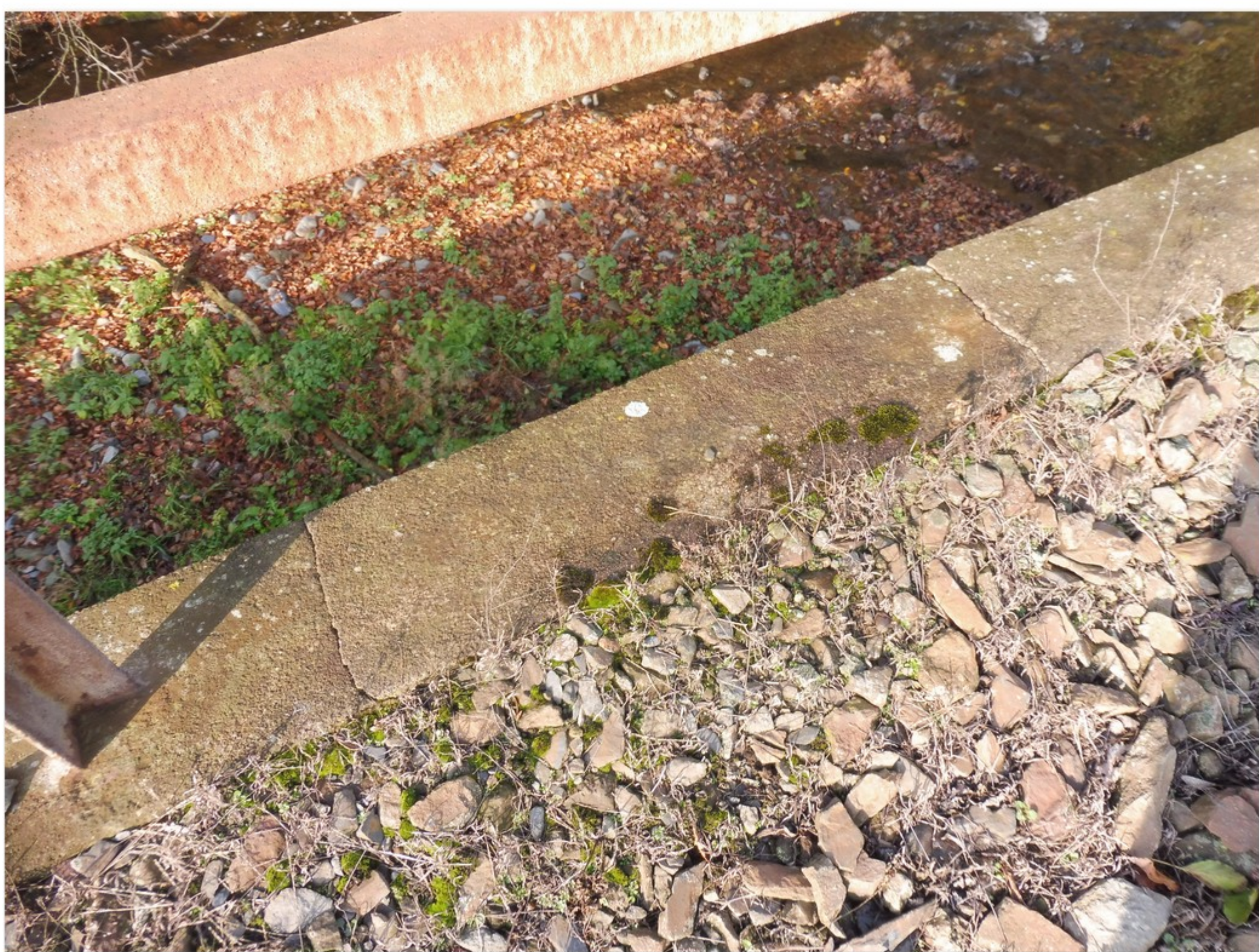
3.2-03 Povrch levé římsy - příčné trhliny
