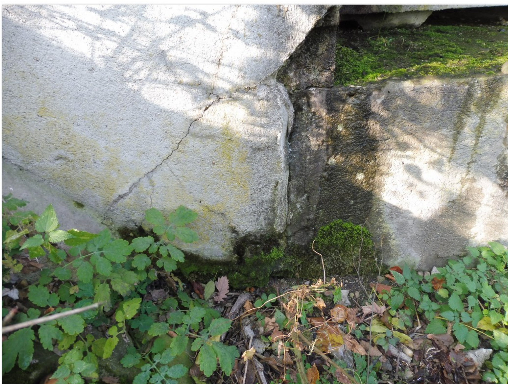
1.2-10 Trhliny v omítce pravého křídla opěry 1
