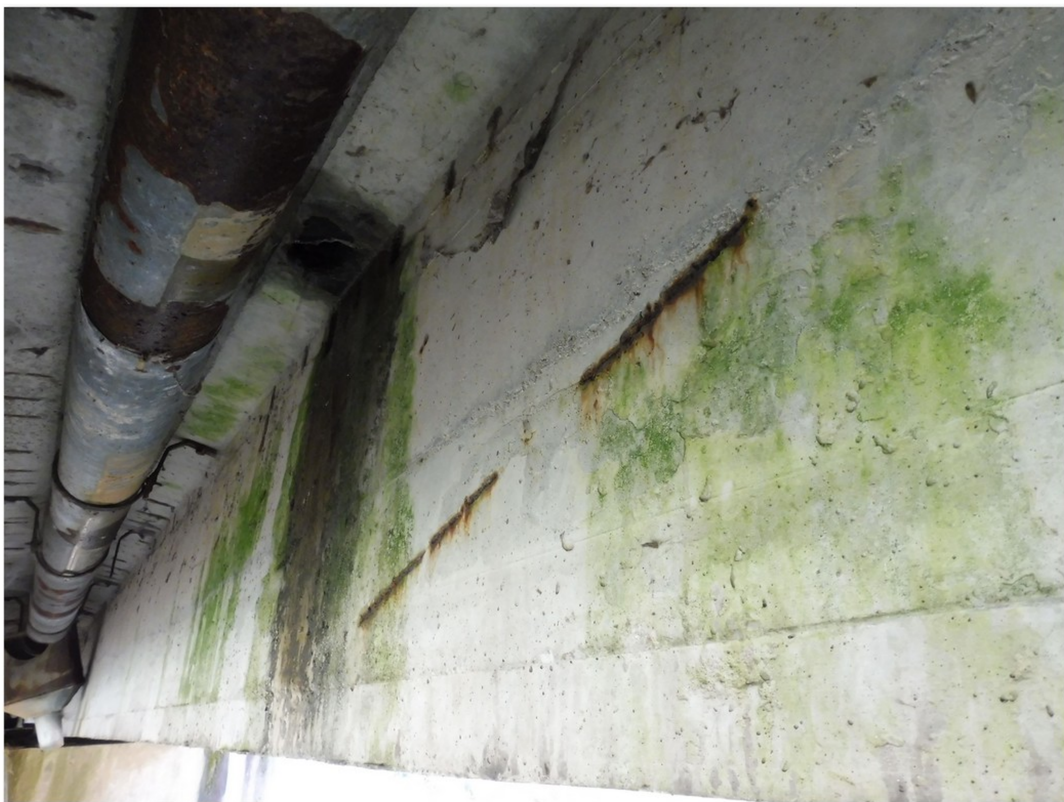
2.1-70 Pravá stěna nosníku č. 3.1 - korodující výztuž s nedostatečným krytím - beton odlomený působením rozpínavých účinků korozních zplodin
