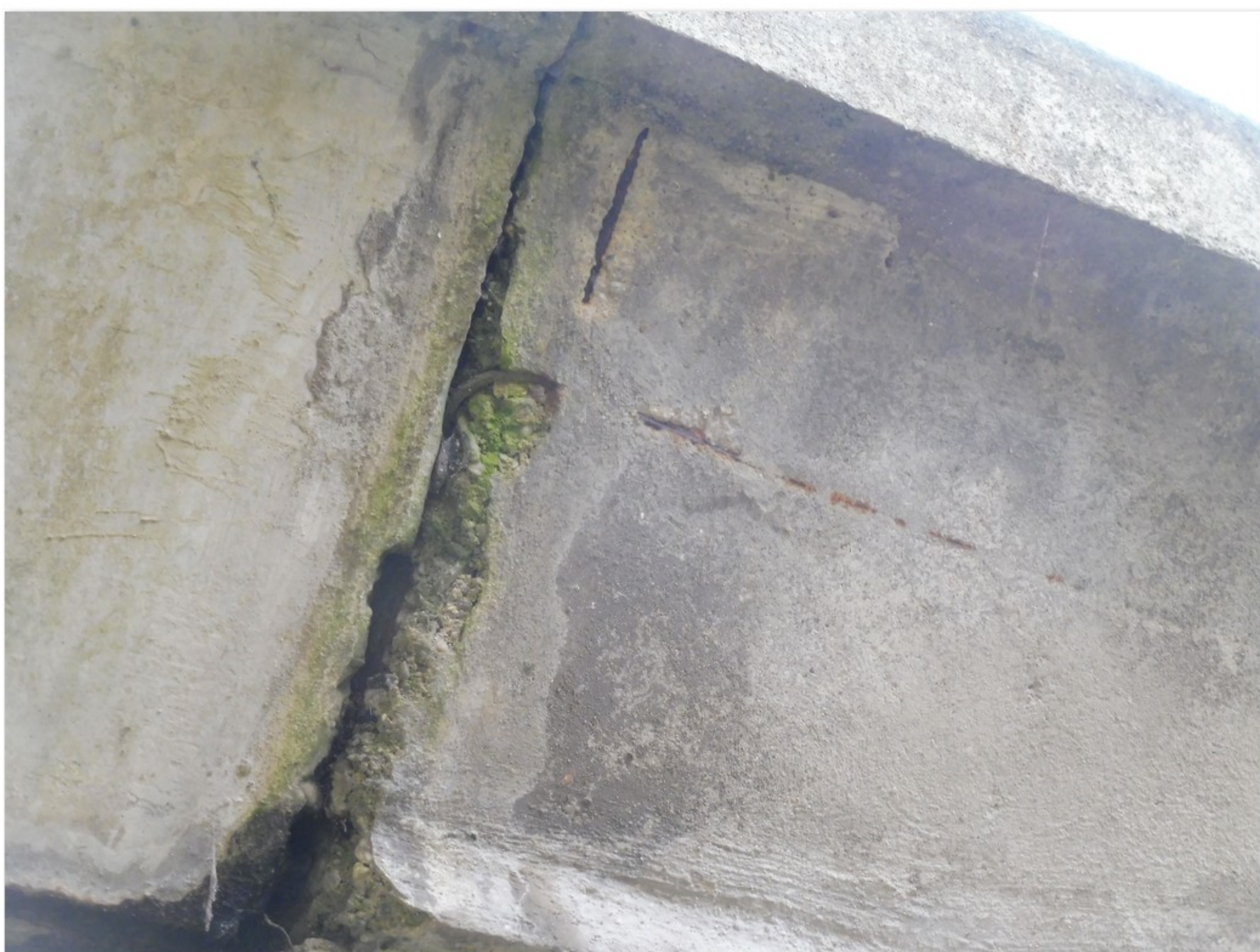
1.2-06 Levá konzola opěry 1 - korodující výztuž s nedostatečným krytím - degradace betonu v dilatační spáře způsobená zatékáním
