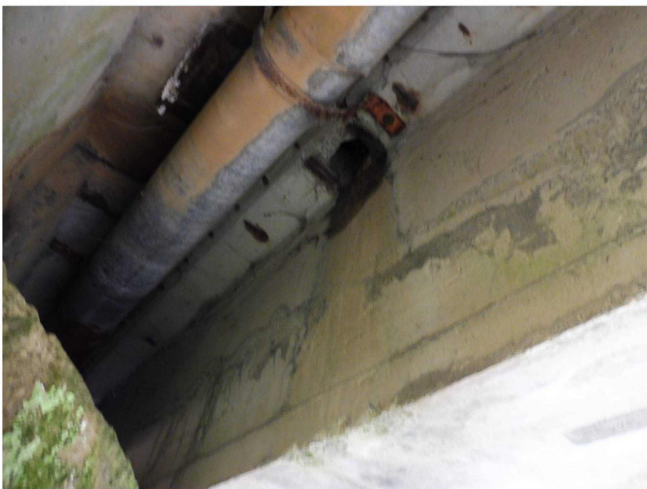
2.1-25 Levá stěna nosníku č. 1.2 - zatékání nezapraveným montážním otvorem nad pilířem 2
