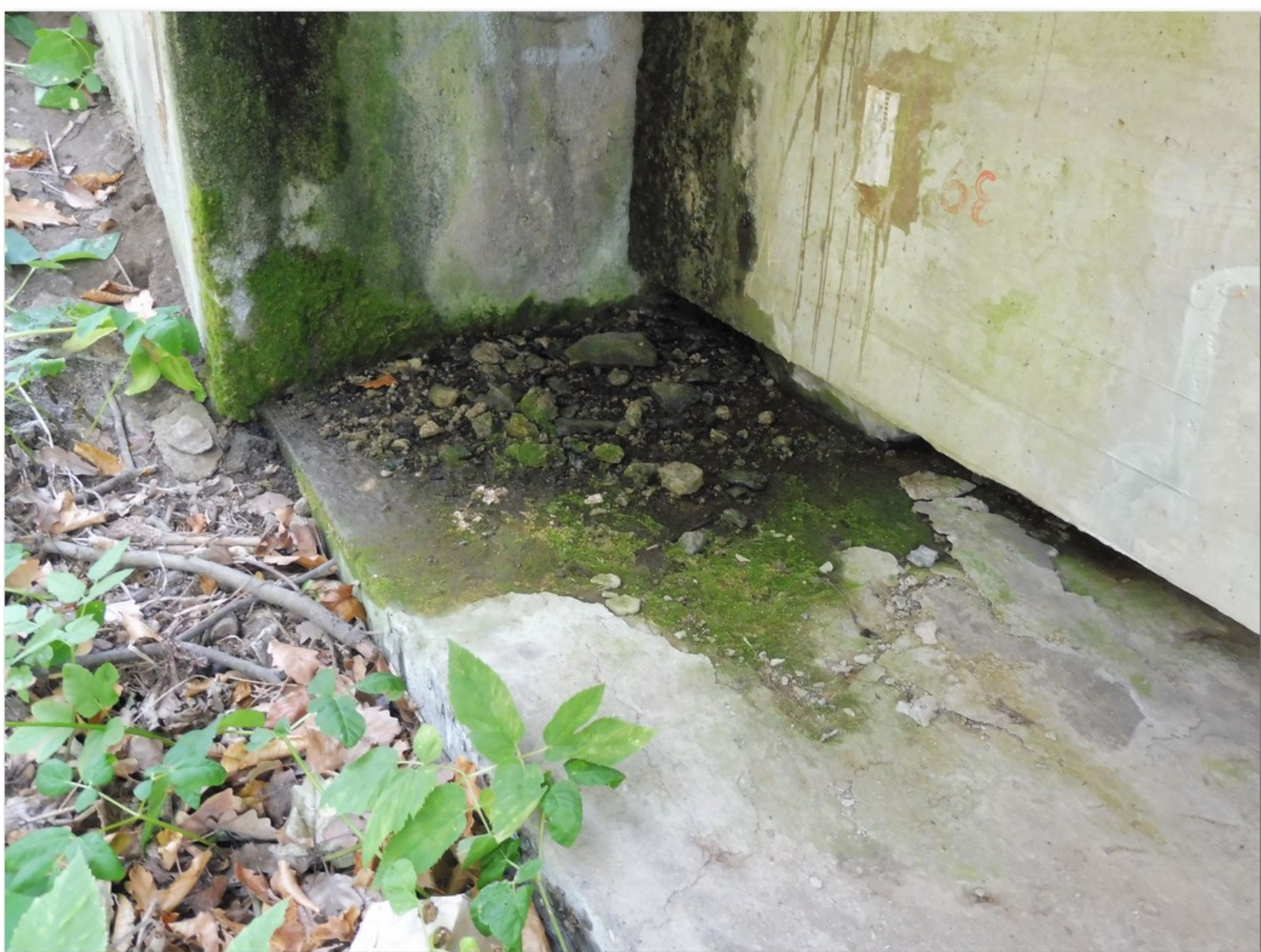
1.2-57 Degradace betonu úložného prahu opěry 4 způsobená permanentním zatékáním
