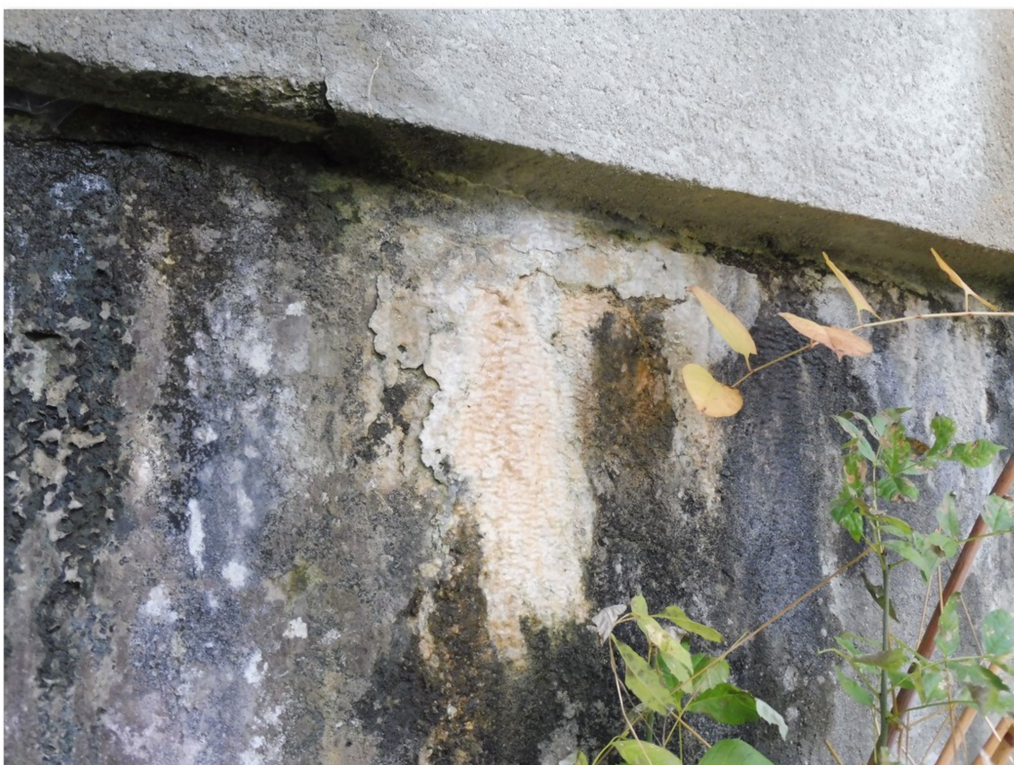
1.2-61 Znamky zatékání ve spáře mezi dříkem a úložným prahem opěry 4 - výluhy - degradace betonu
