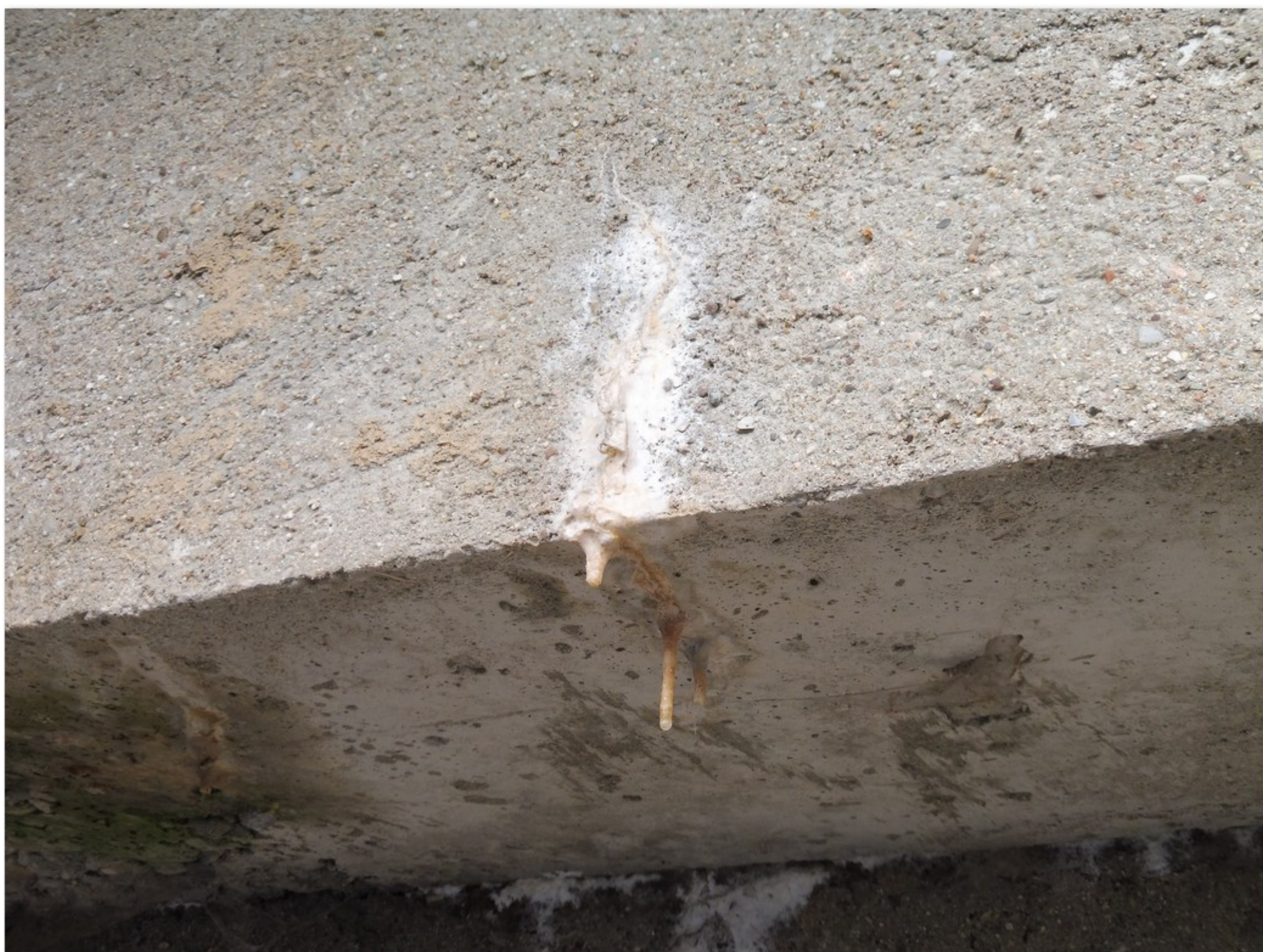
1.2-35 Trhlina s výluhy a krápníky v úložném prahu pilíře 3
