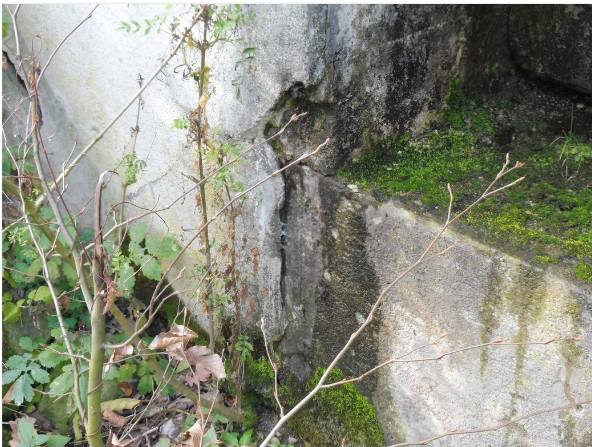
1.2-08 Degradace betonu a omítky opěry 1 způsobená zatékáním
