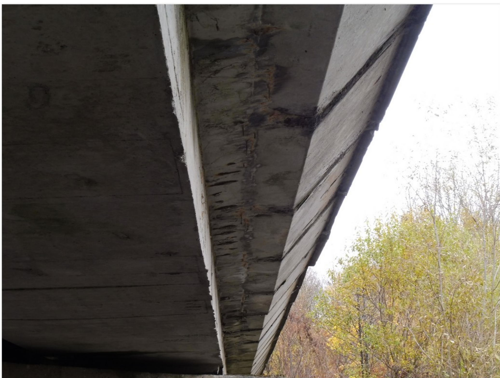
2.1-58 Podhled pravé horní příruby nosníku č. 2.2 a navazující konzoly
