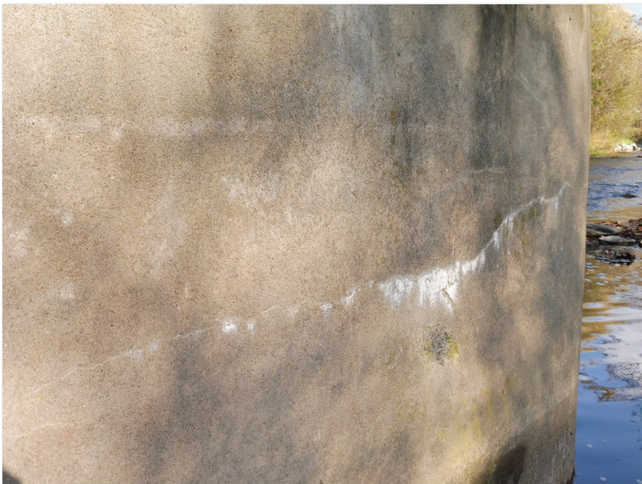
1.2-17 Trhliny s výluhy v dříku pilíře 2
