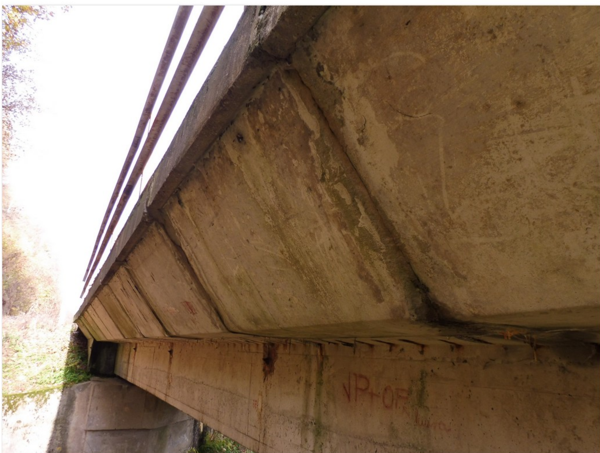
2.1-92 Prefabrikované konzoly na levém okraji mostu ve 3. poli
