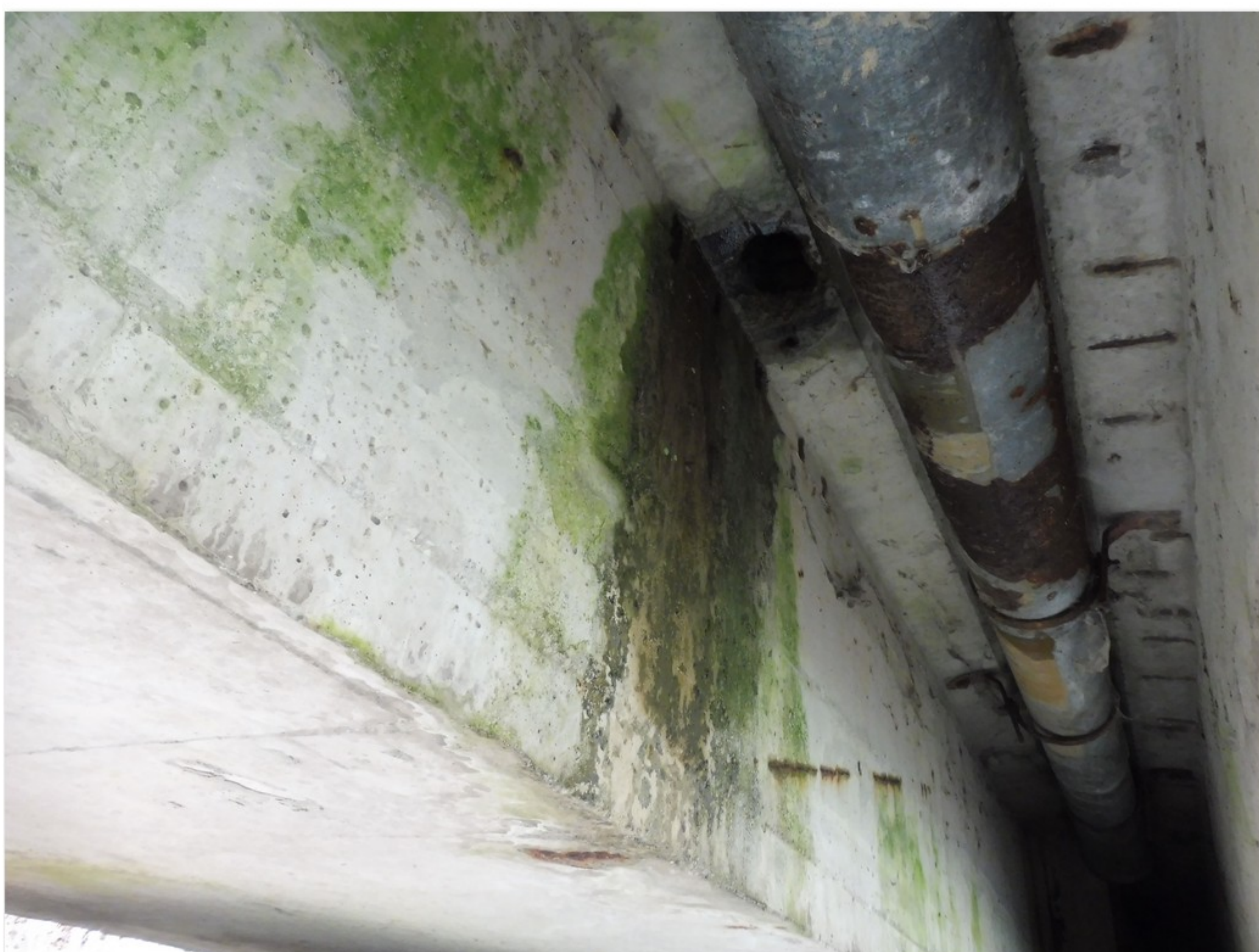
2.1-69 Pravá stěna nosníku č. 3.1 - zatékání nezapraveným montážním otvorem nad opěrou 4
