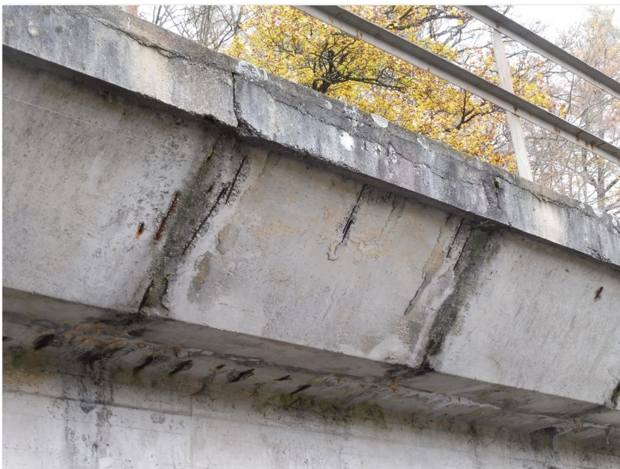
2.1-91 Prefabrikované konzoly na pravém okraji mostu ve 2. poli
