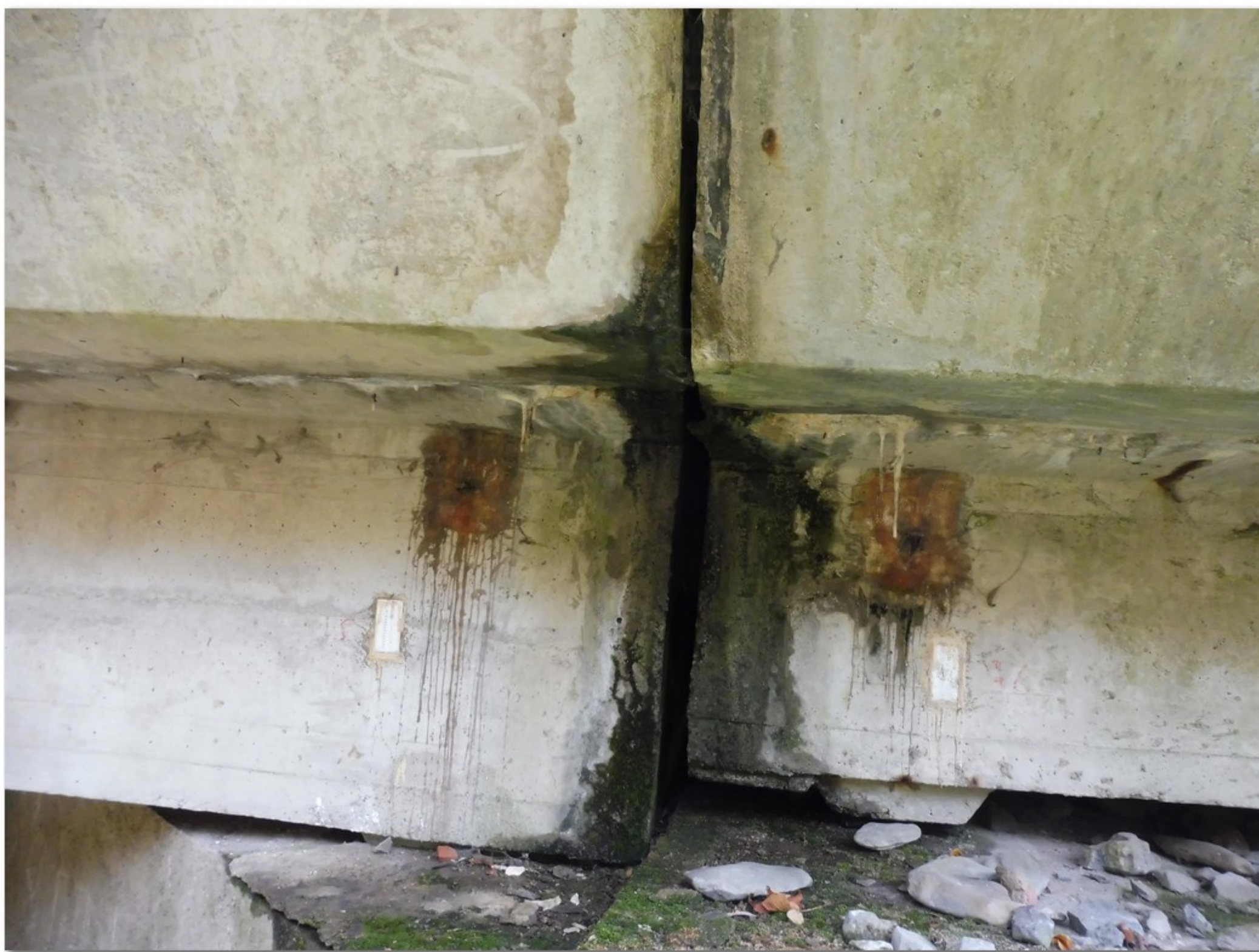
2.1-48 Mezera mezi čely nosníků č. 2.1 a č. 3.1 nad pilířem 3 - pohled zleva
