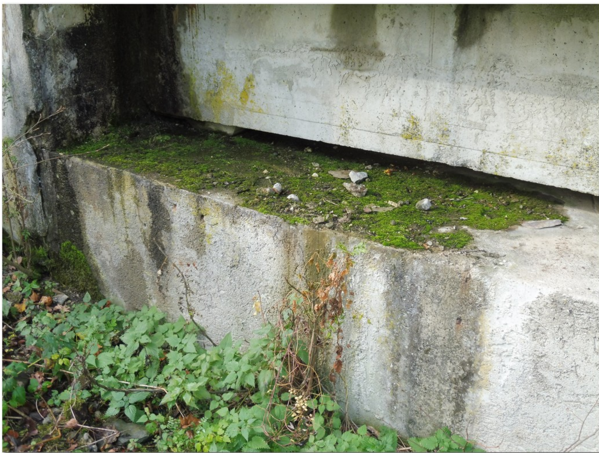
1.2-07 Úložný práh u pravého čela opěry 1 - vegetace uchycená v naplavených nečistotách
