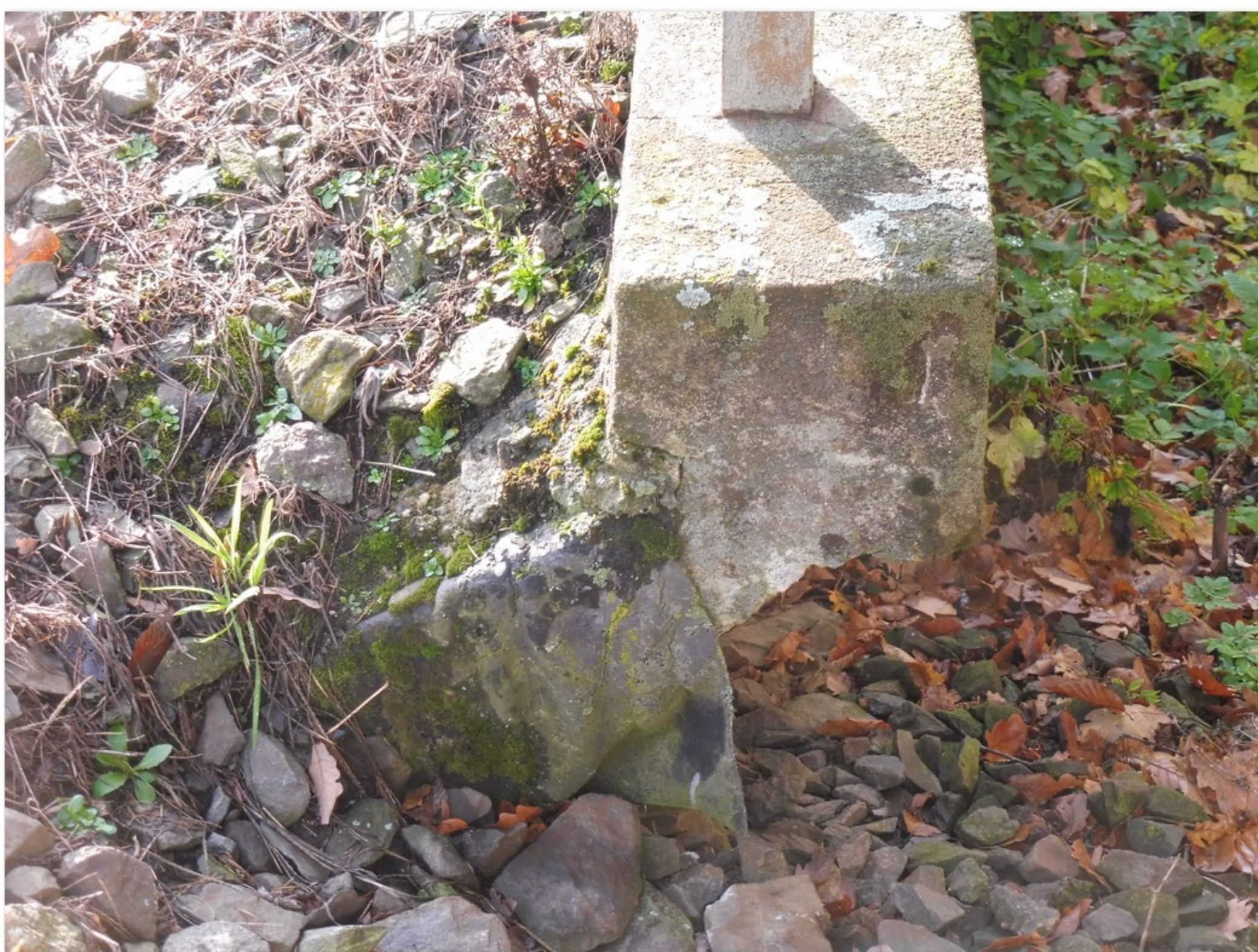
1.3-01 Obnažený konec levé římsy za opěrou 4
