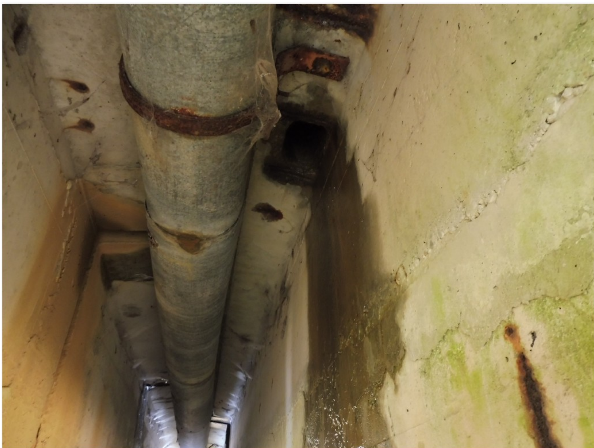
2.1-68 Pravá stěna nosníku č. 3.1 - zatékání nezapraveným montážním otvorem nad pilířem 3
