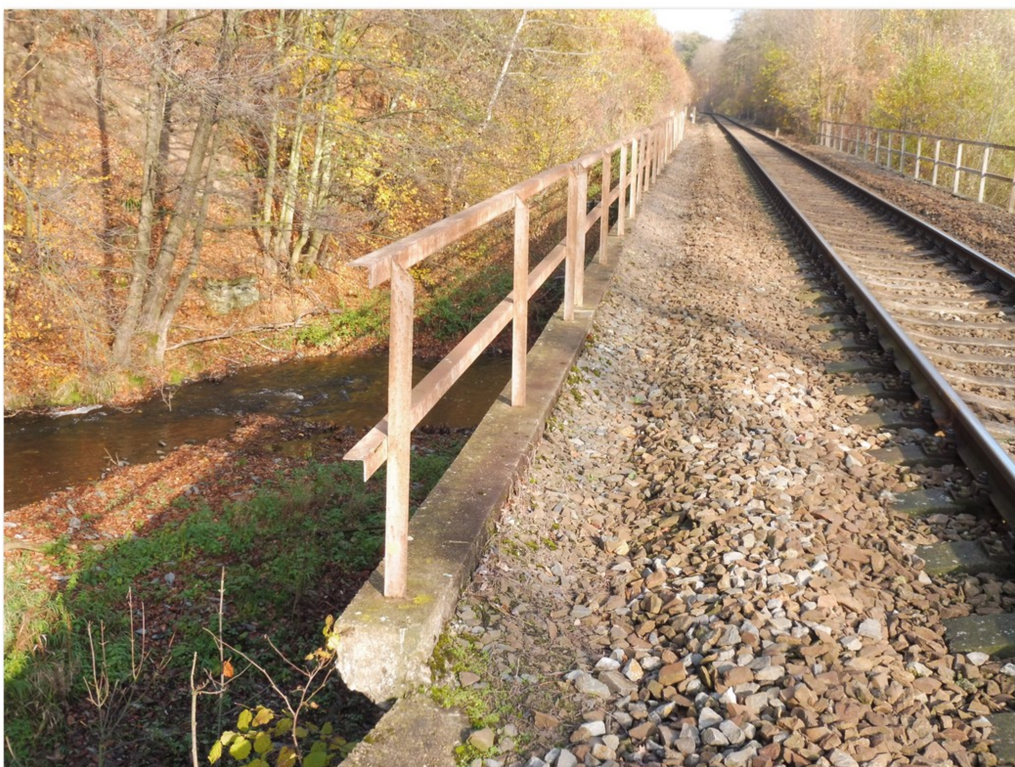
3.2-01 Levá římsa se zábradlím
