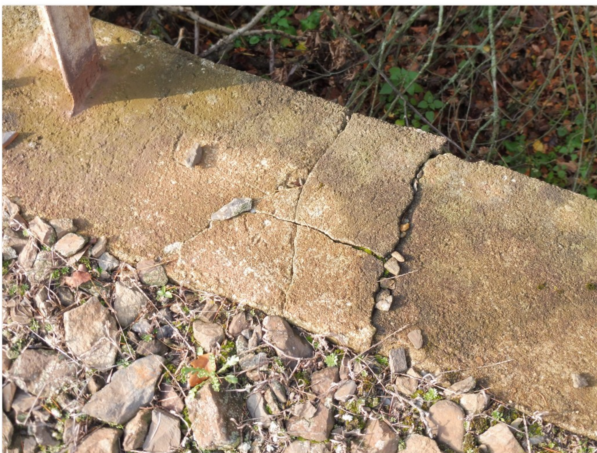
3.2-05 Praskliny na povrchu levé římsy
