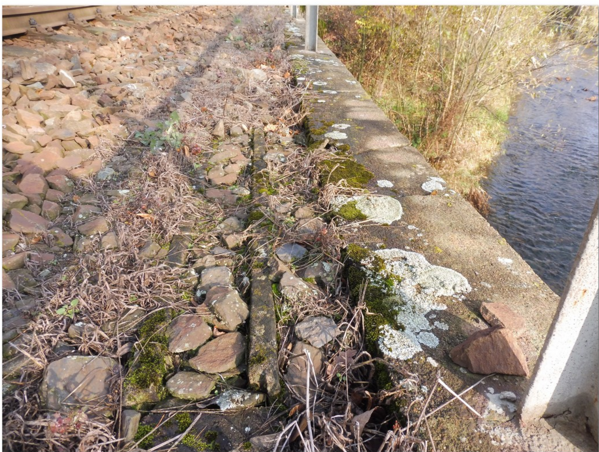
4.2-04 Kabelový žlab ve 2. poli
