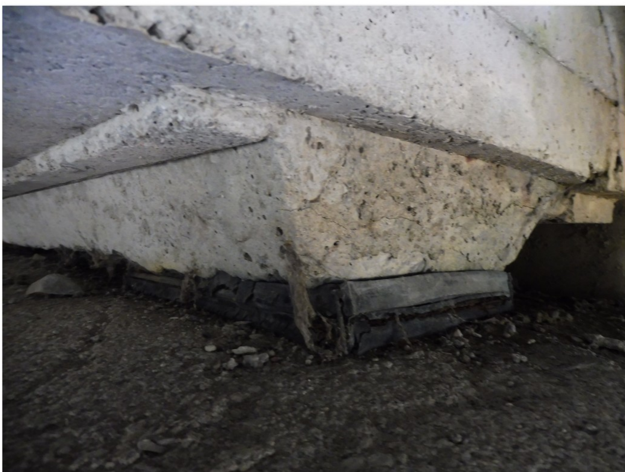
2.2-10 Uložení nosníku č. 2.1 na pilíři 3 - pohled zprava
