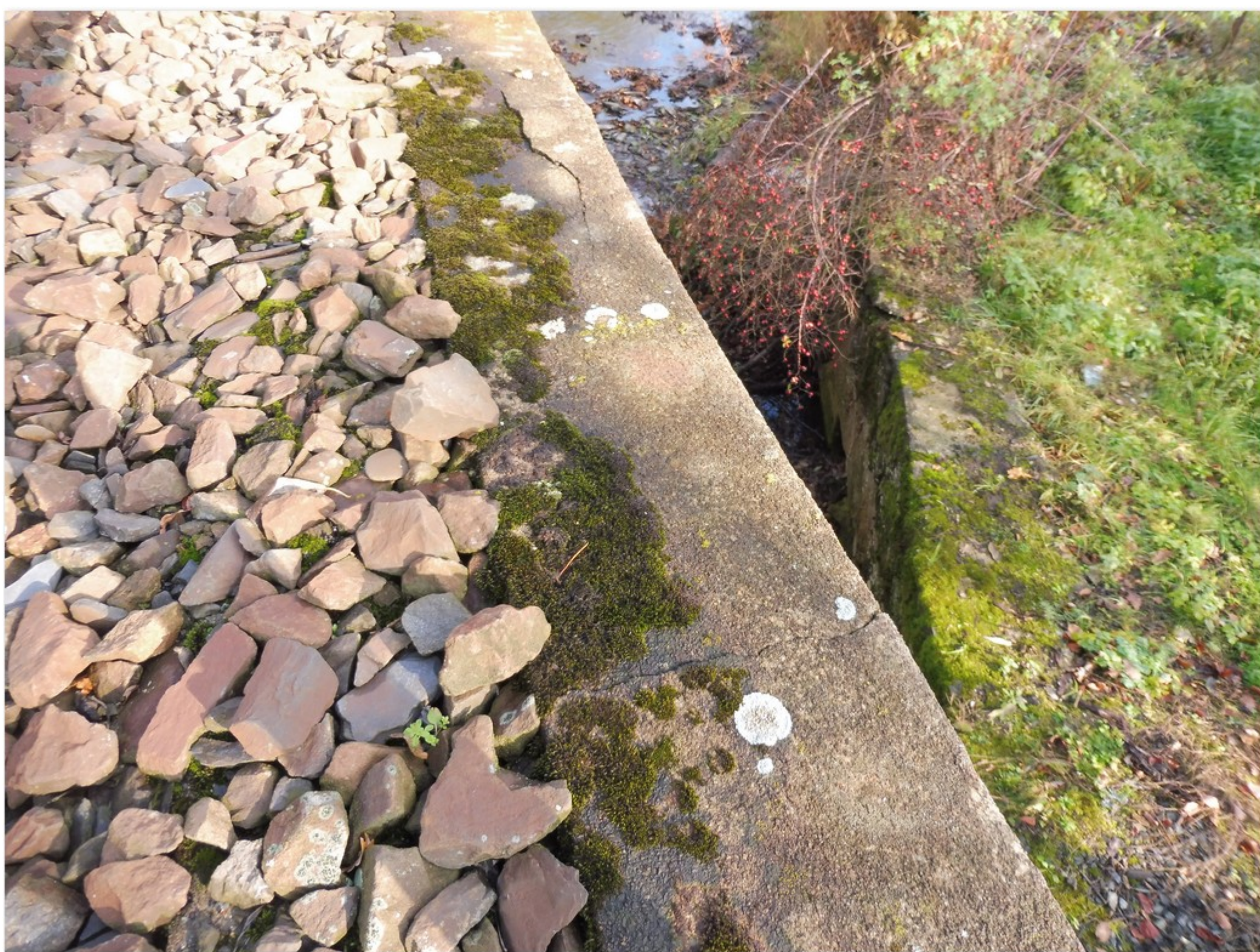
3.2-10 Praskliny na povrchu pravé římsy - uvolněná krycí omítka
