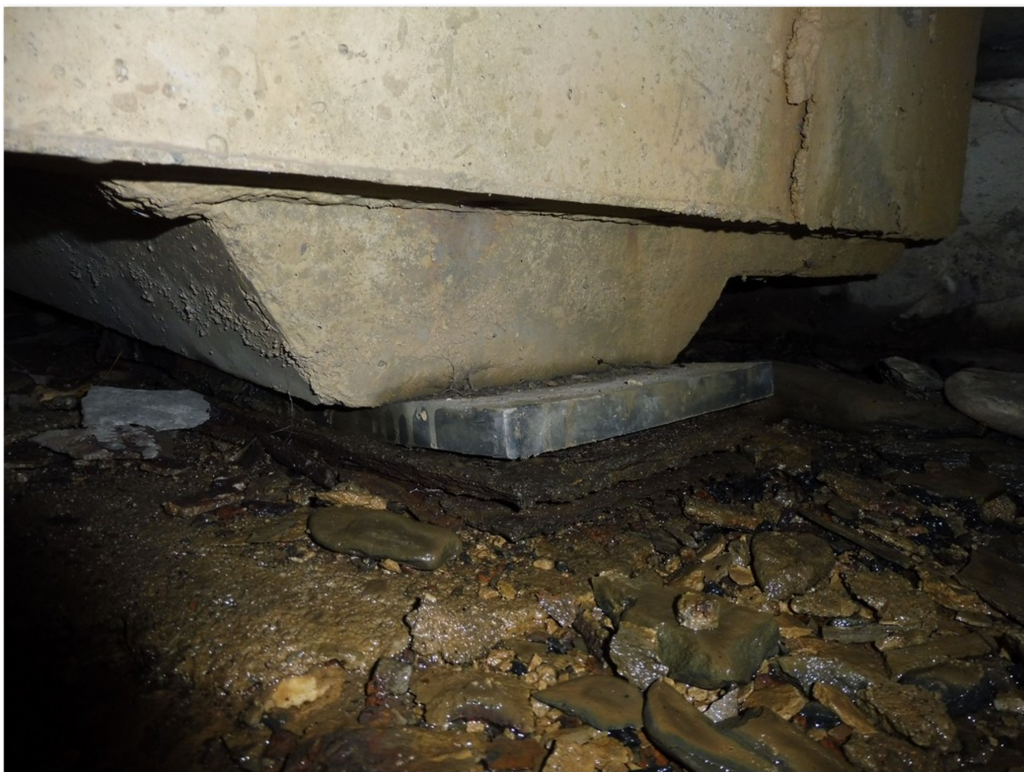
2.2-03 Uložení nosníku č. 1.1 na pilíři 2 vpravo
