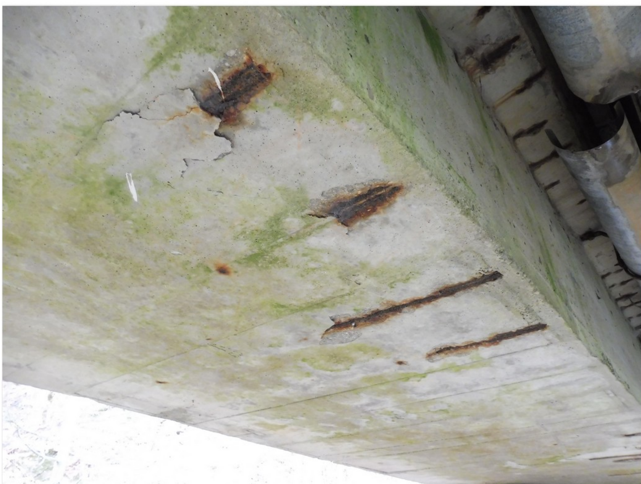
2.1-05 Detail fotografie č. 2.1-04 - korodující výztuž s nedostatečným krytím - beton odlomený působením rozpínavých účinků korozních zplodin
