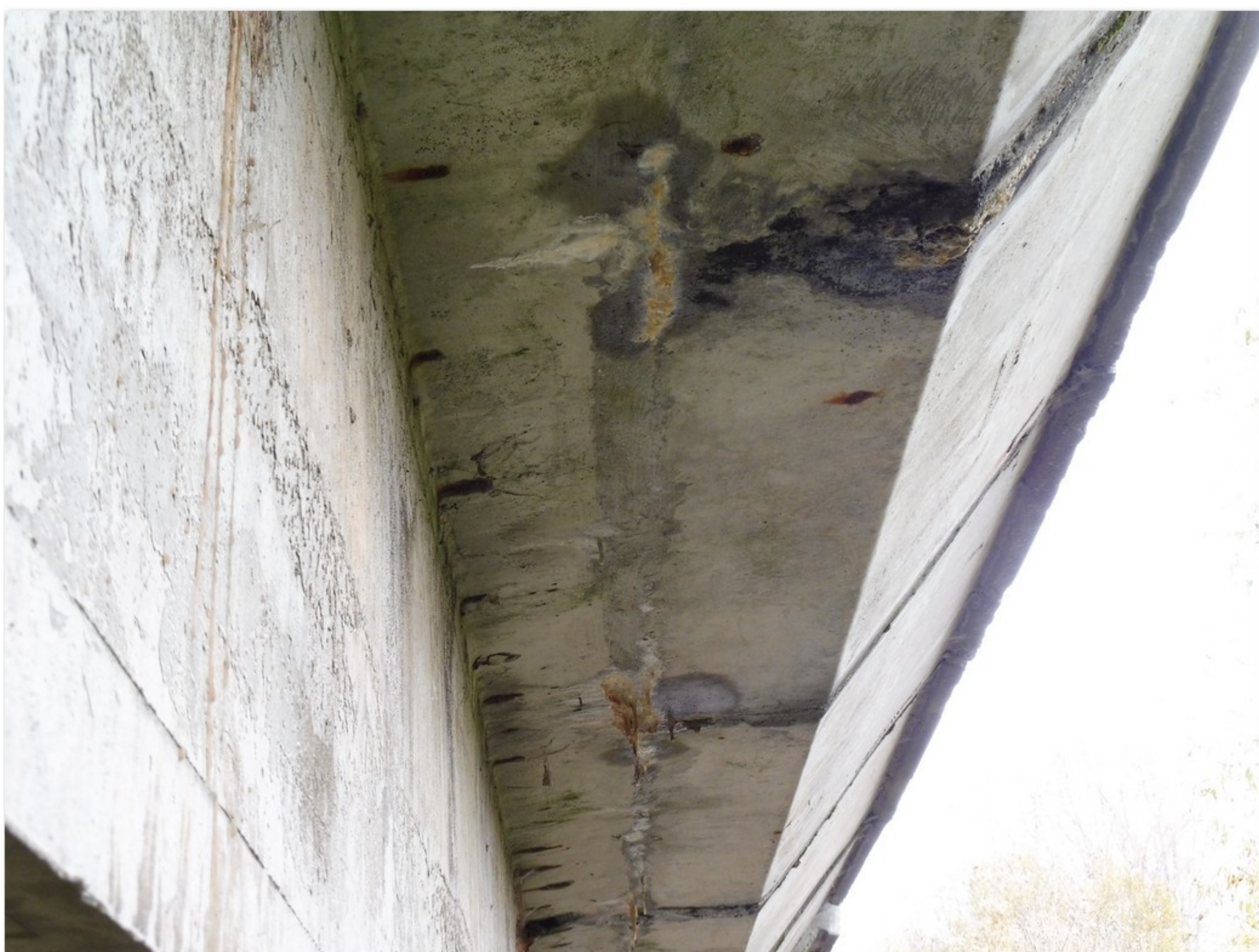
2.1-28 Detail fotografie č. 2.1-27 - v podélné spáře mezi nosníkem a prefabrikovanými konzolami trhliny s výluhy a krápníky
