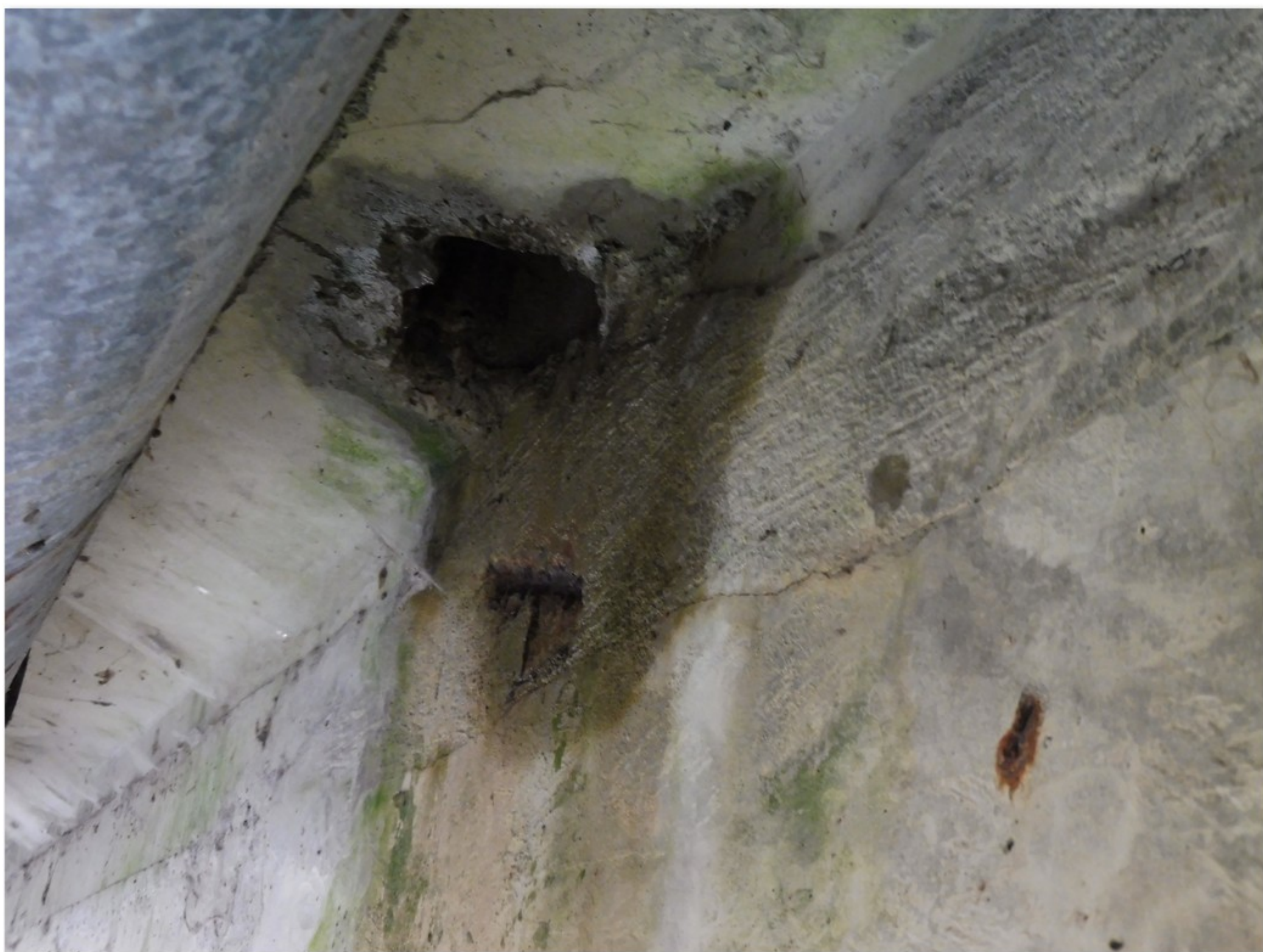
2.1-52 Levá stěna nosníku č. 2.2 - zatékání nezapraveným montážním otvorem
