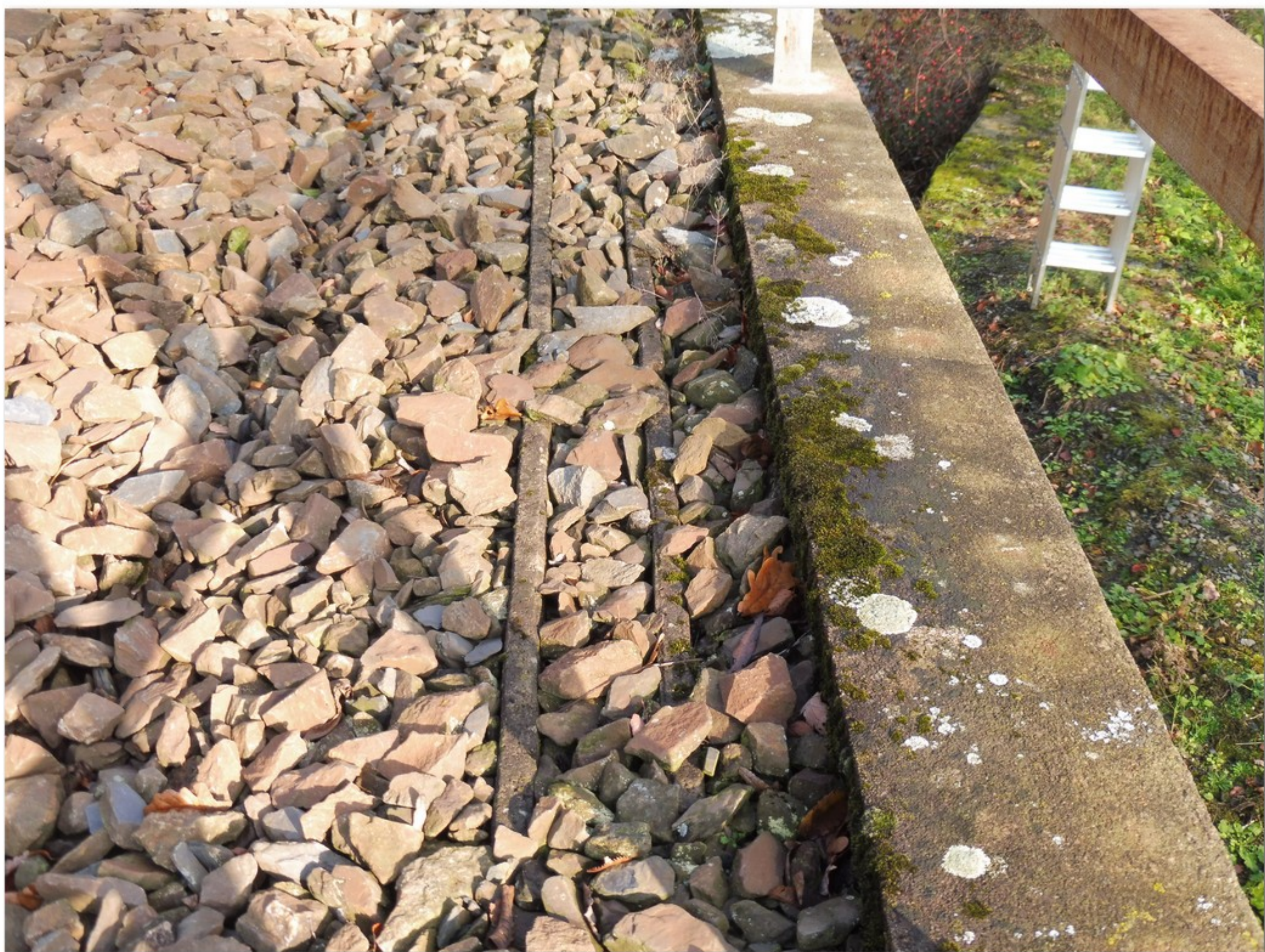
4.2-02 Kabelový žlab na začátku mostu
