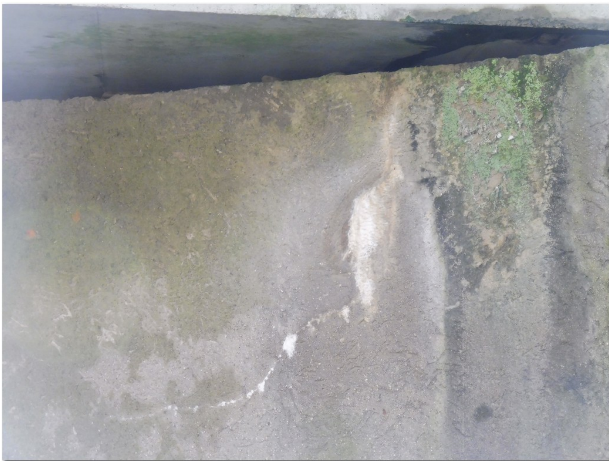
1.2-21 Trhliny s výluhy v úložném prahu pilíře 2
