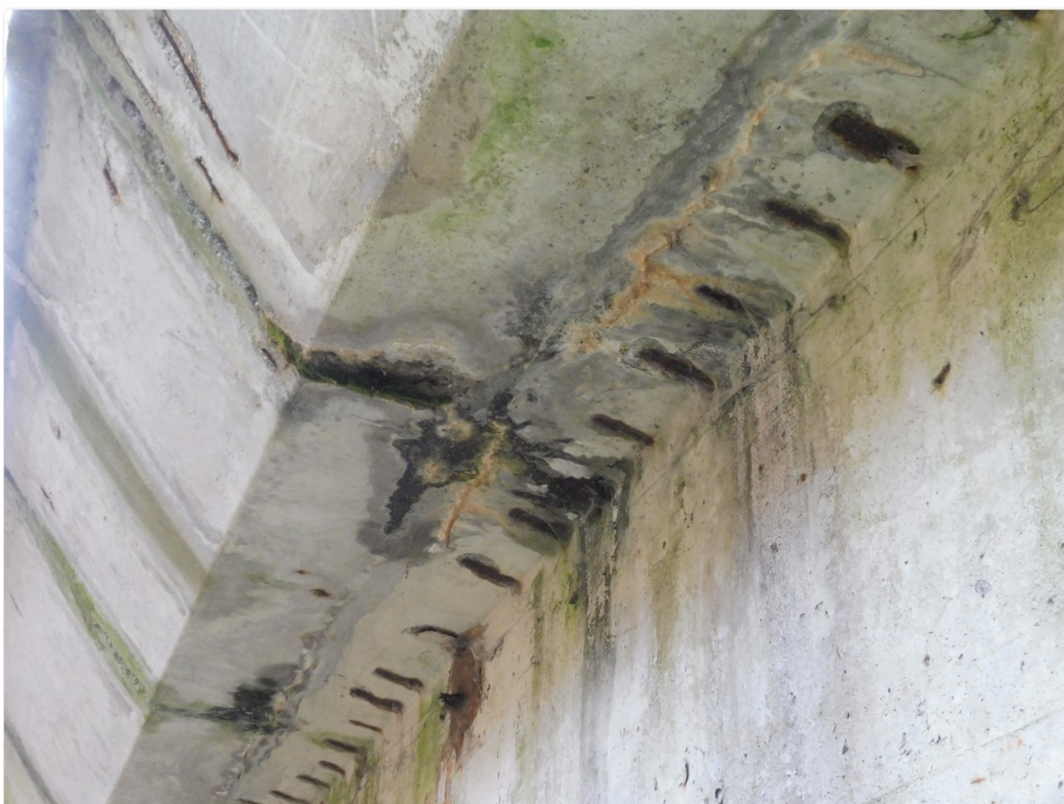
2.1-03 Detail fotografie č. 2.1-02 - v podélné spáře mezi nosníkem a prefabrikovanými konzolami trhliny s výluhy a krápníky
