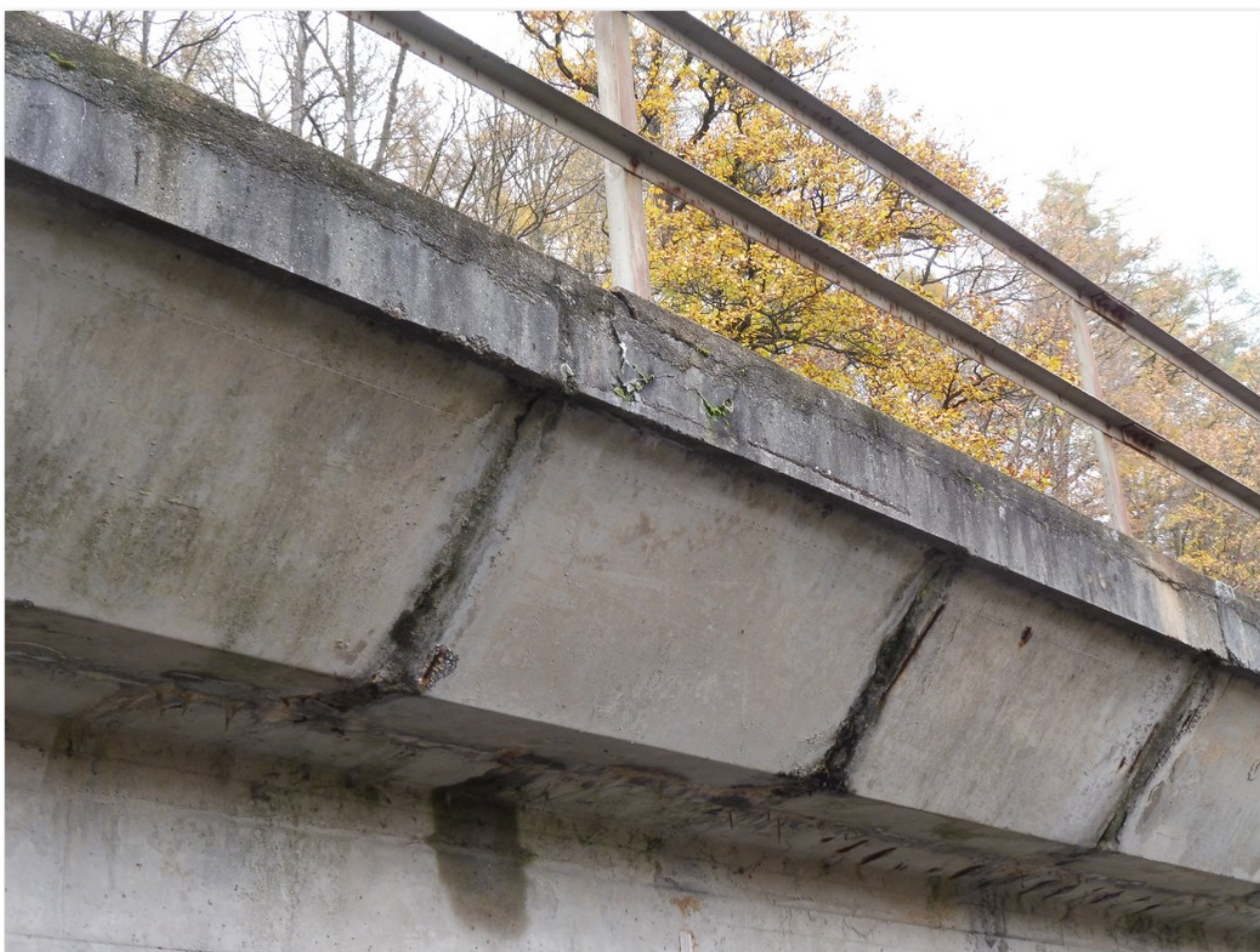
2.1-90 Prefabrikované konzoly na pravém okraji mostu ve 2. poli
