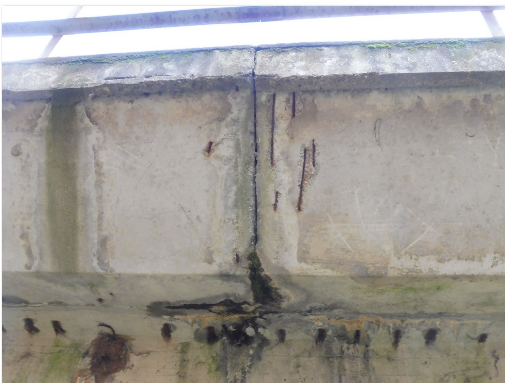
2.1-85 Detail fotografie č. 2.1-83 - beton odlomený působením rozpínavých účinků korozních zplodin výztuže
