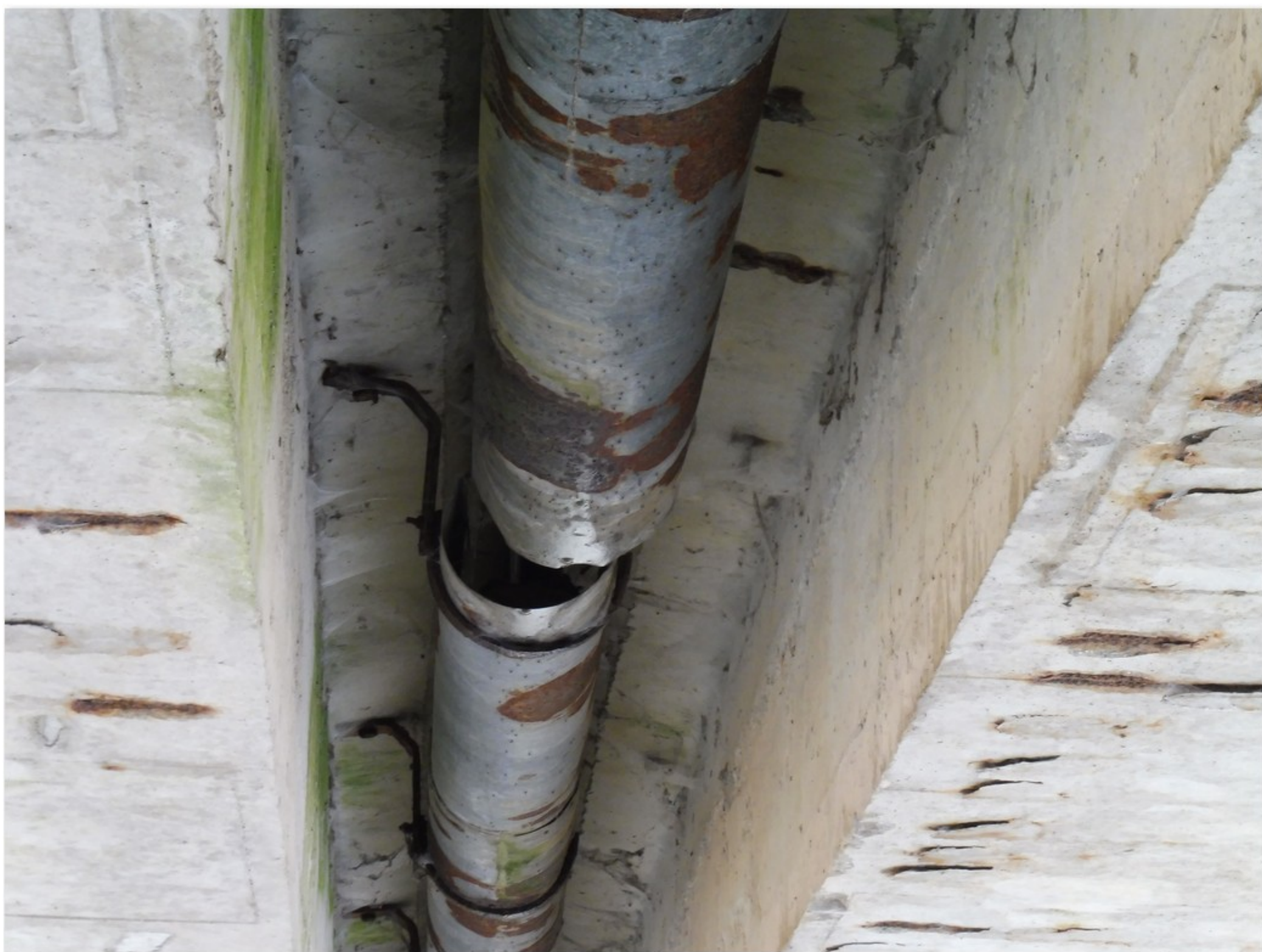
3.4-03 Rozpojený odvodňovací žlab - chybějící kotlík ve 2. poli
