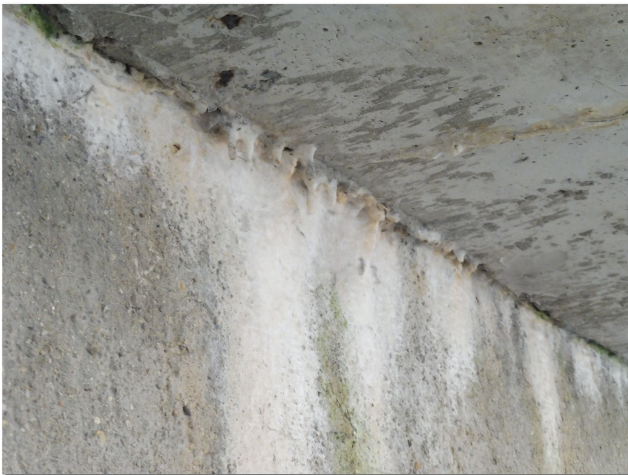
1.2-41 Znamky zatékání ve spáře mezi dříkem a úložným prahem pilíře 3 - výluhy a krápníky
