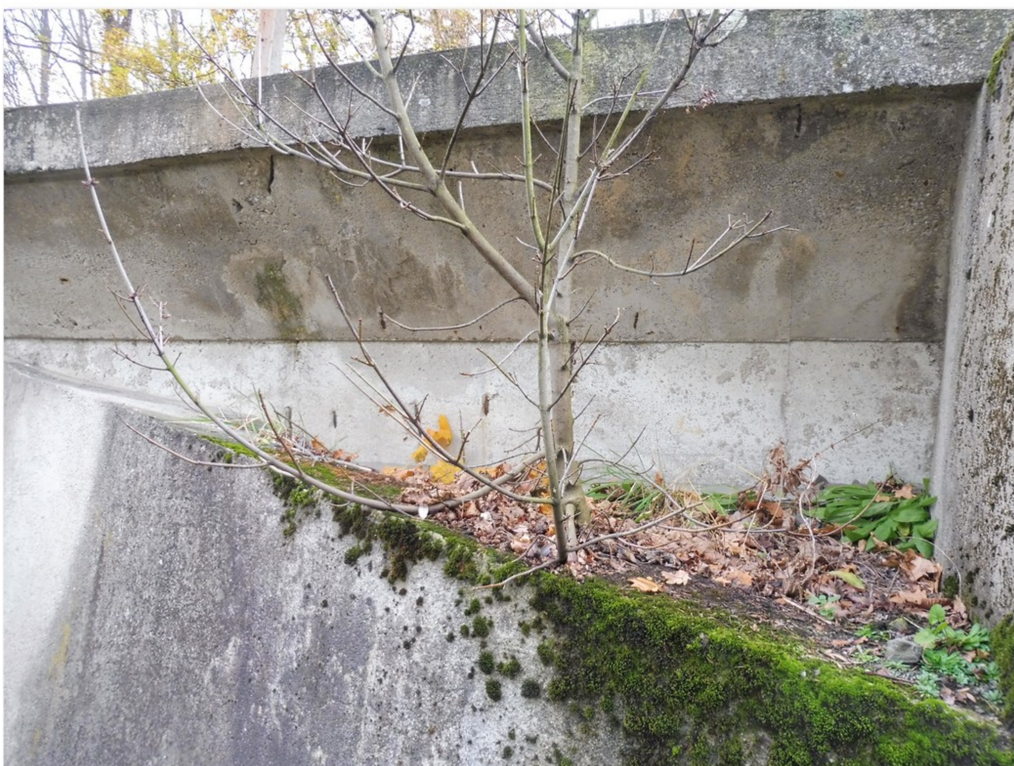
1.2-69 Náletová dřevina uchycená v koruně opěrné zdi před pravým křídlem opěry
