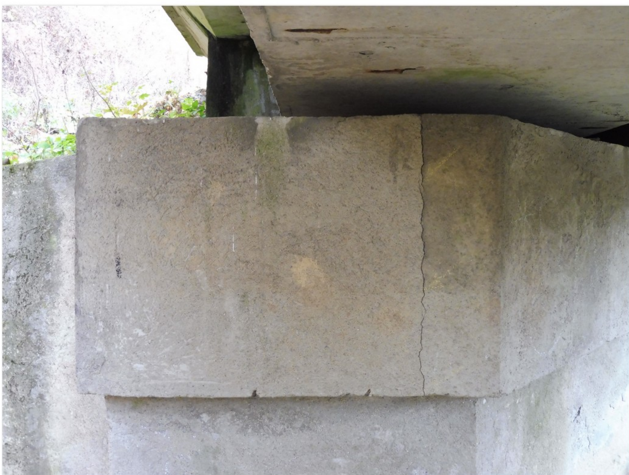
1.2-59 Prasklina v úložném prahu opěry 4
