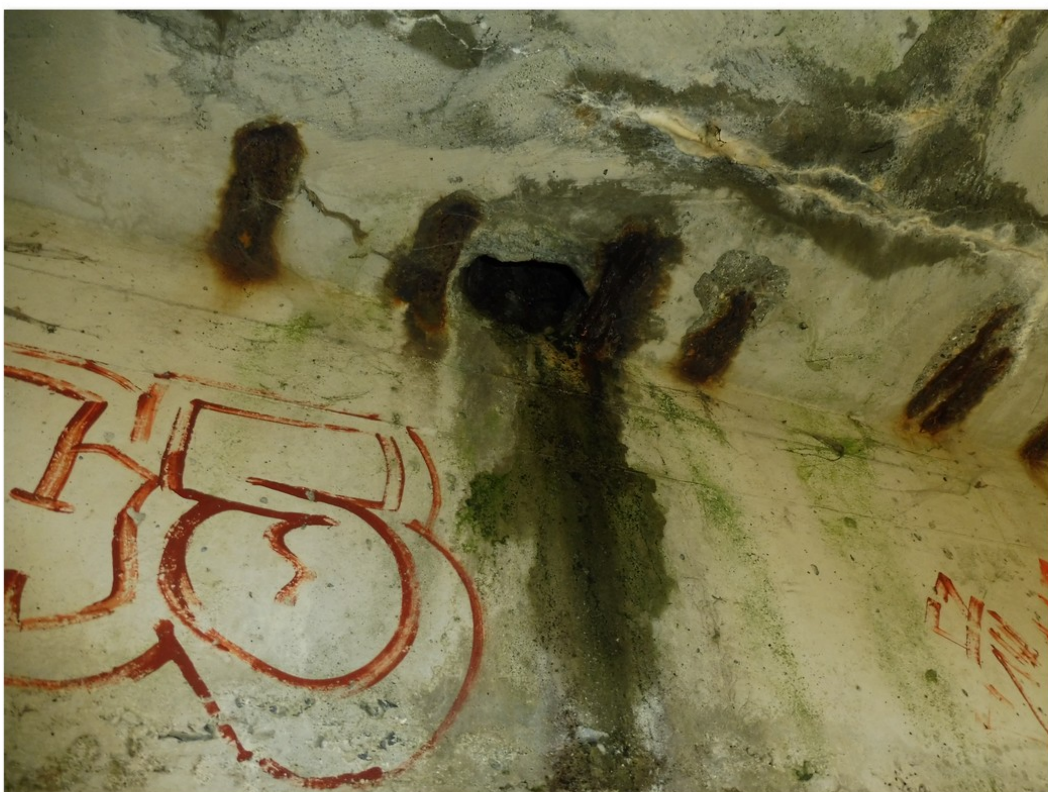
2.1-63 Levá stěna nosníku č. 3.1 - zatékání nezapraveným montážním otvorem
