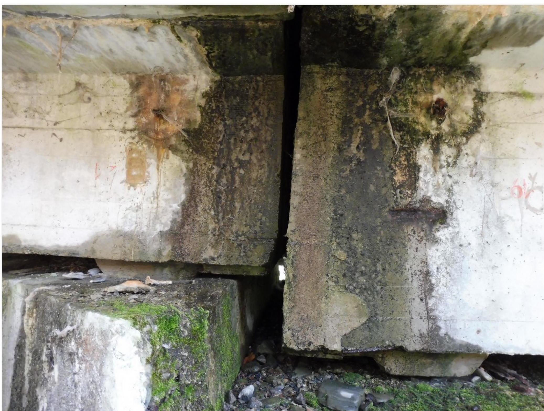
2.1-11 Mezera mezi čely nosníků č. 1.1 a č. 2.1 nad pilířem 2
