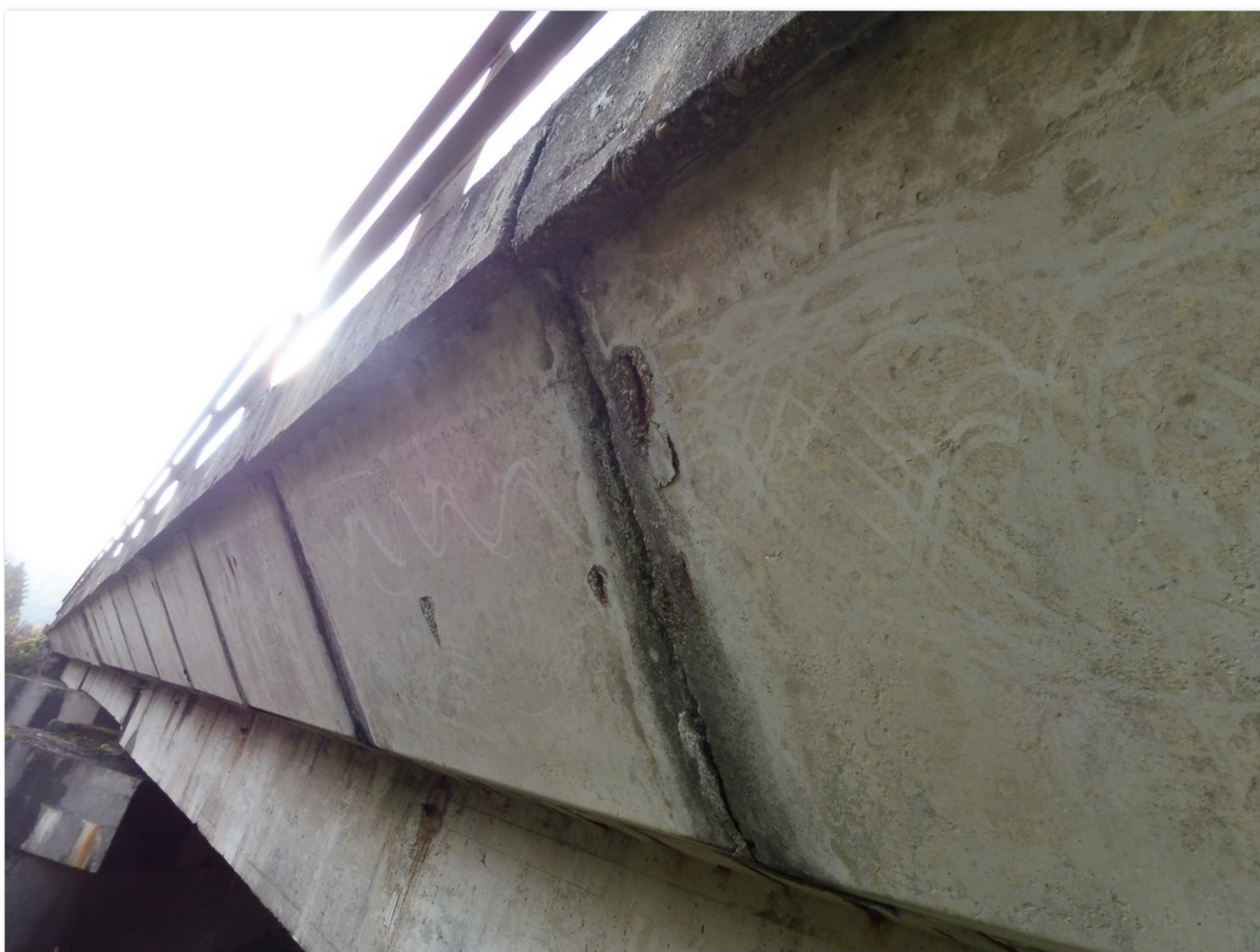
2.1-95 Prefabrikované konzoly na pravém okraji mostu ve 3. poli
