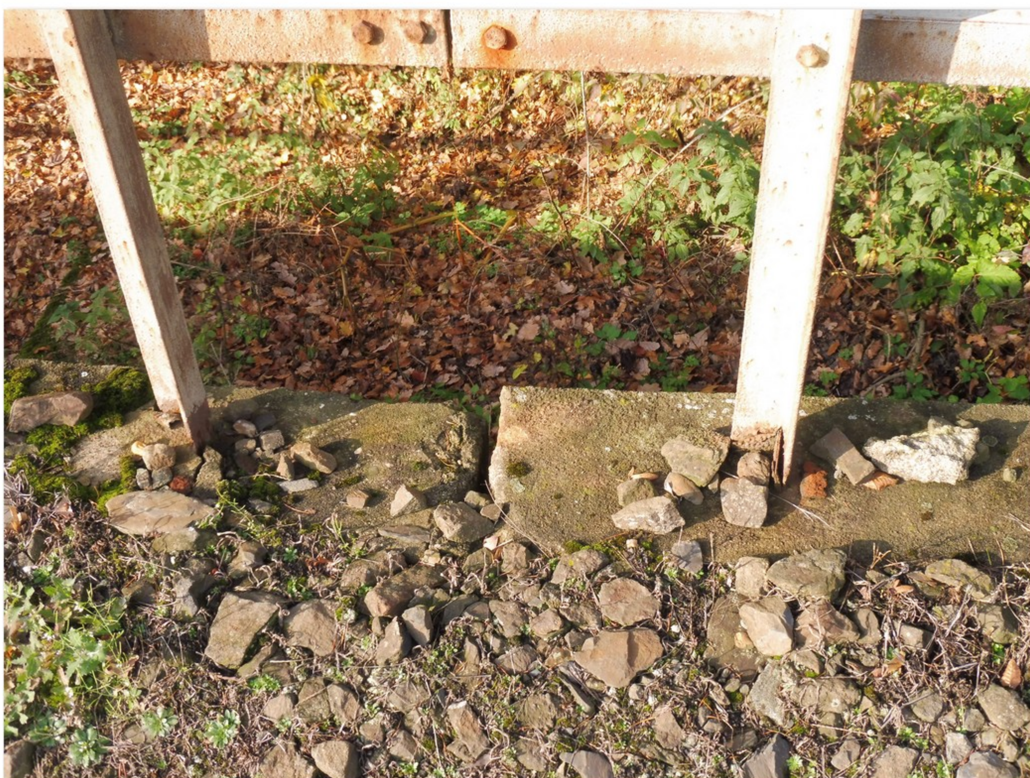
3.2-07 Dilatační spára levé římsy nad opěrou 4
