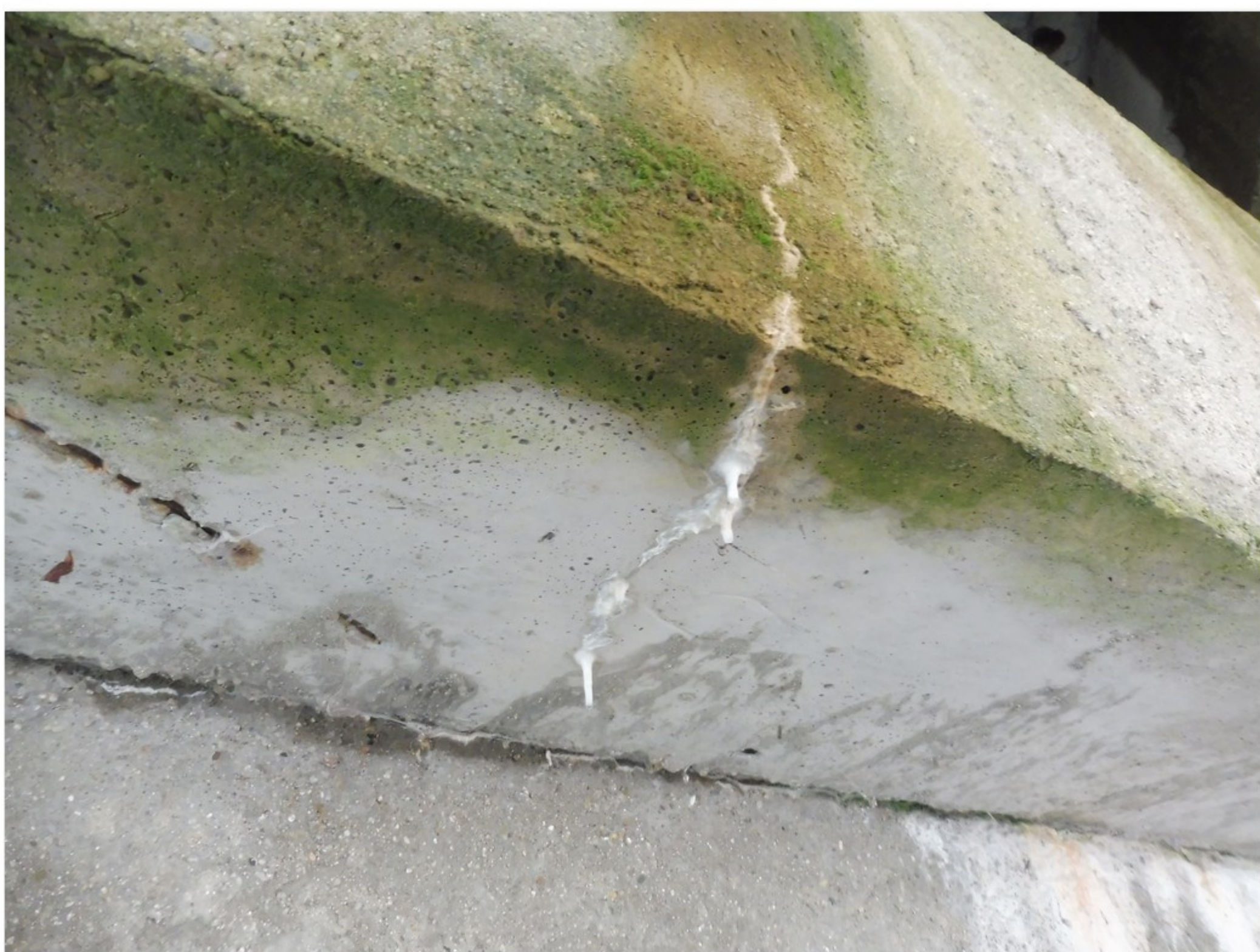
1.2-40 Trhlina s výluhy a krápníky v úložném prahu pilíře 3
