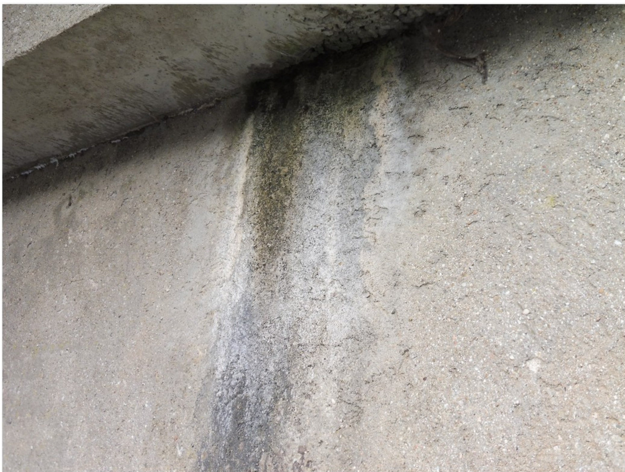
1.2-37 Znamky zatékání ve spáře mezi dříkem a úložným prahem pilíře 3
