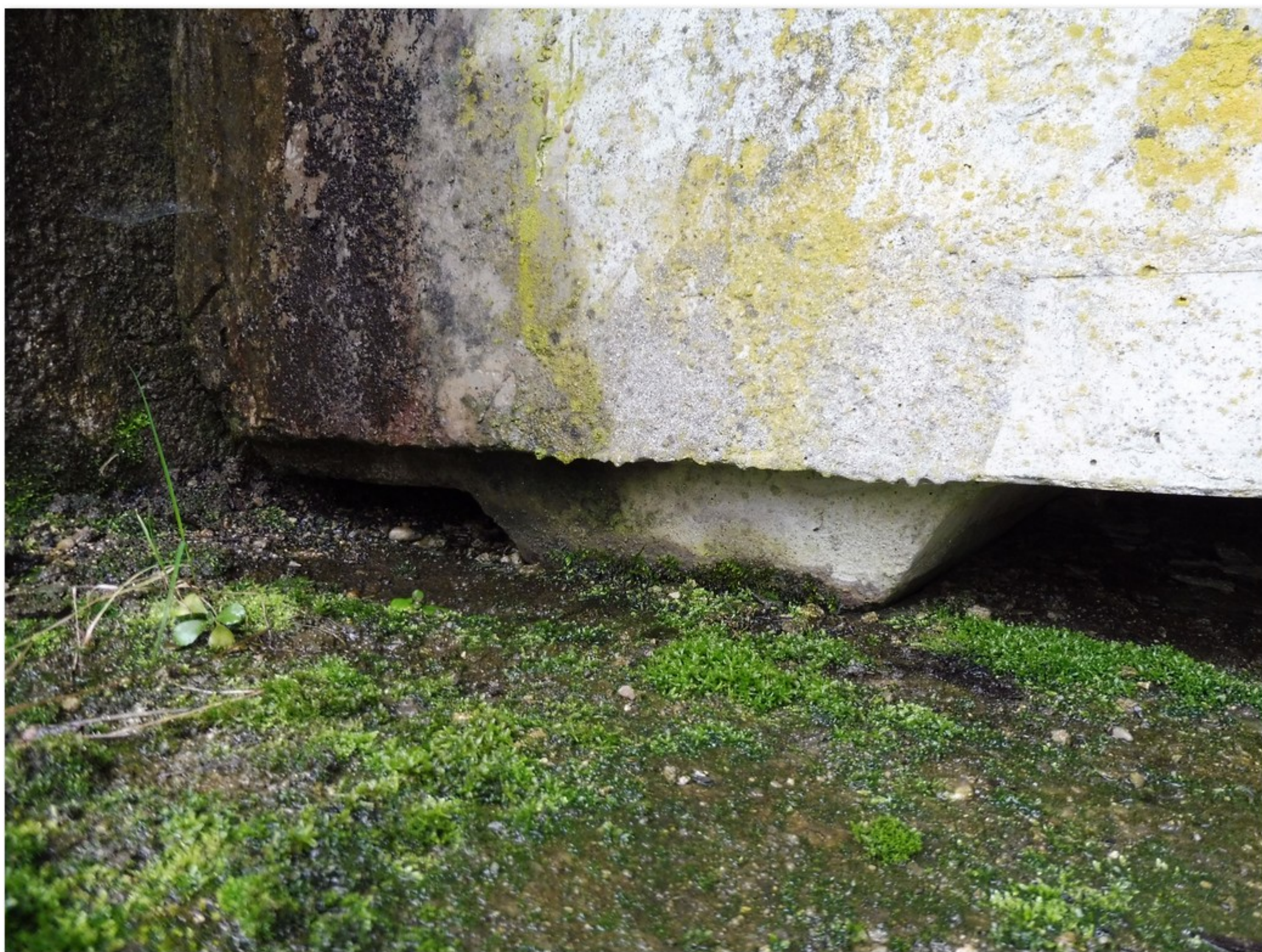
2.2-05 Uložení nosníku č. 1.2 na opěře 1 vpravo
