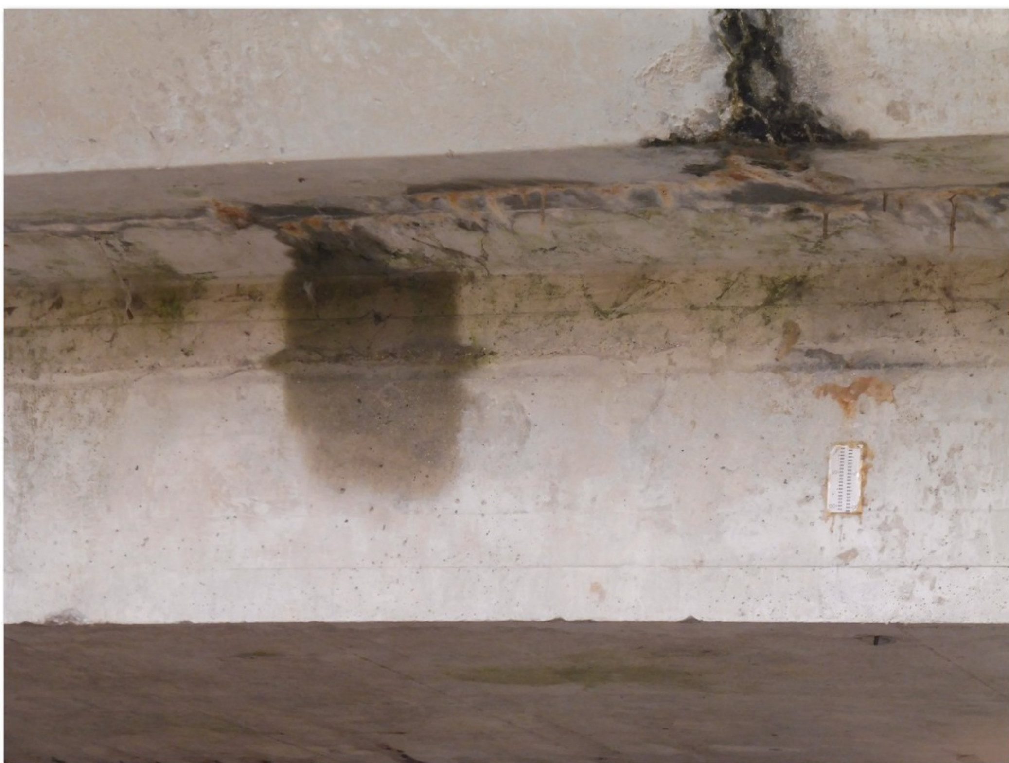
2.1-82 Pravá stěna nosníku č. 3.2 - stopy zatékání z podélné spáry mezi horní přírubou nosníku a konzolou
