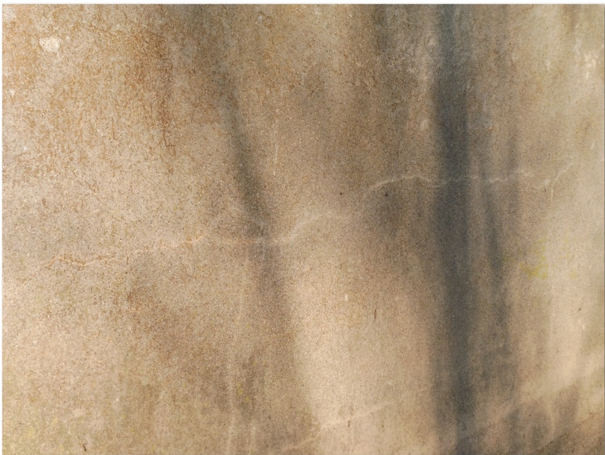
1.2-16 Trhliny v dříku pilíře 2
