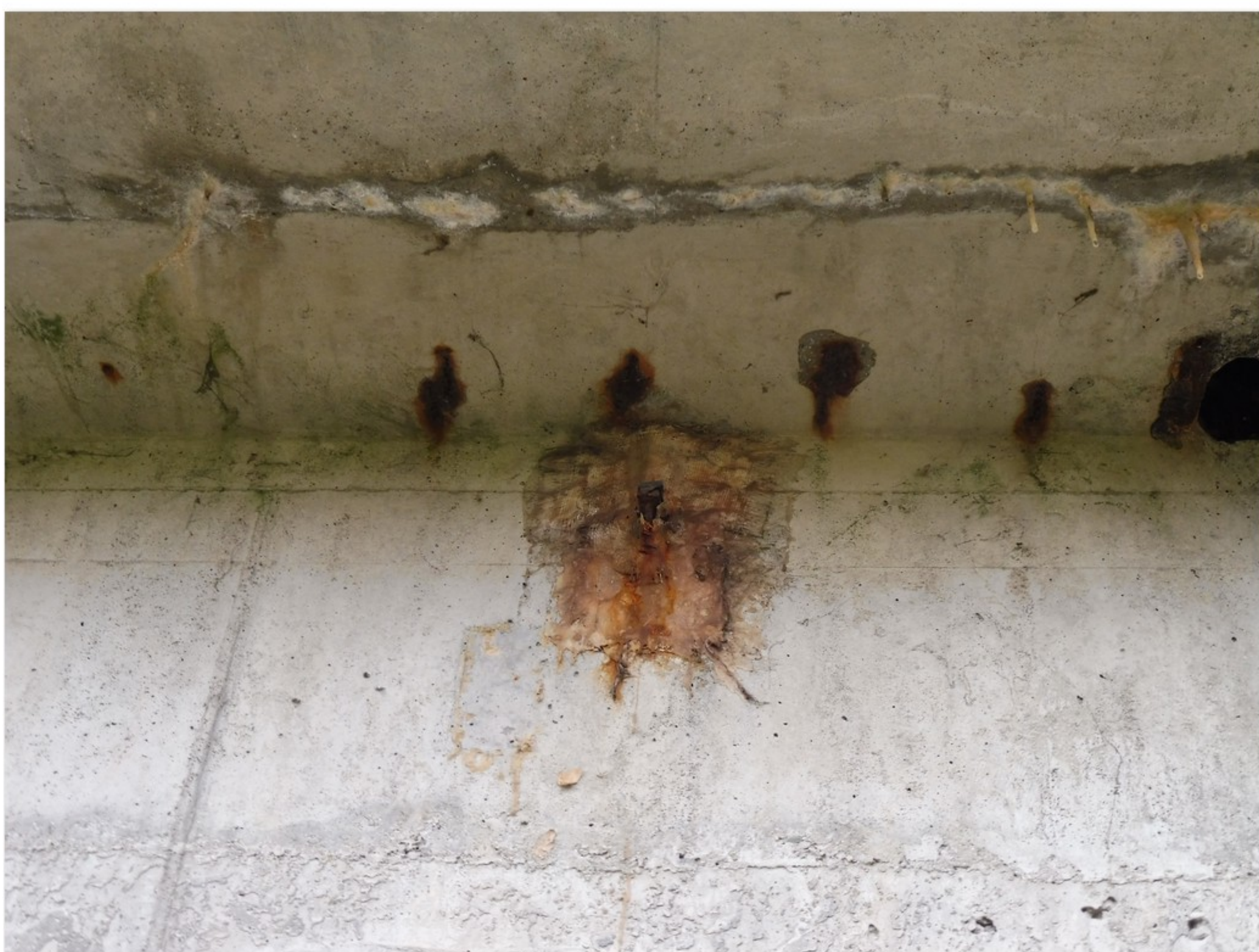
2.1-43 Podhled levé horní příruby nosníku č. 2.1 - korodující výztuž s nedostatečným krytím - beton odlomený působením rozpínavých účinků korozních
