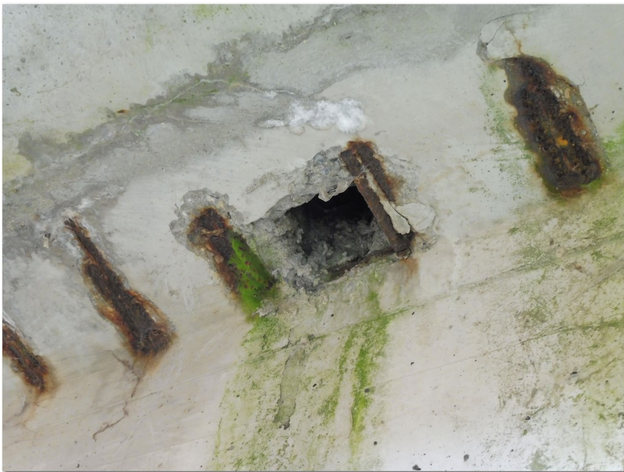
2.1-08 Podhled levé horní příruby nosníku č. 1.1 - stopy zatékání nezapraveným montážním otvorem
