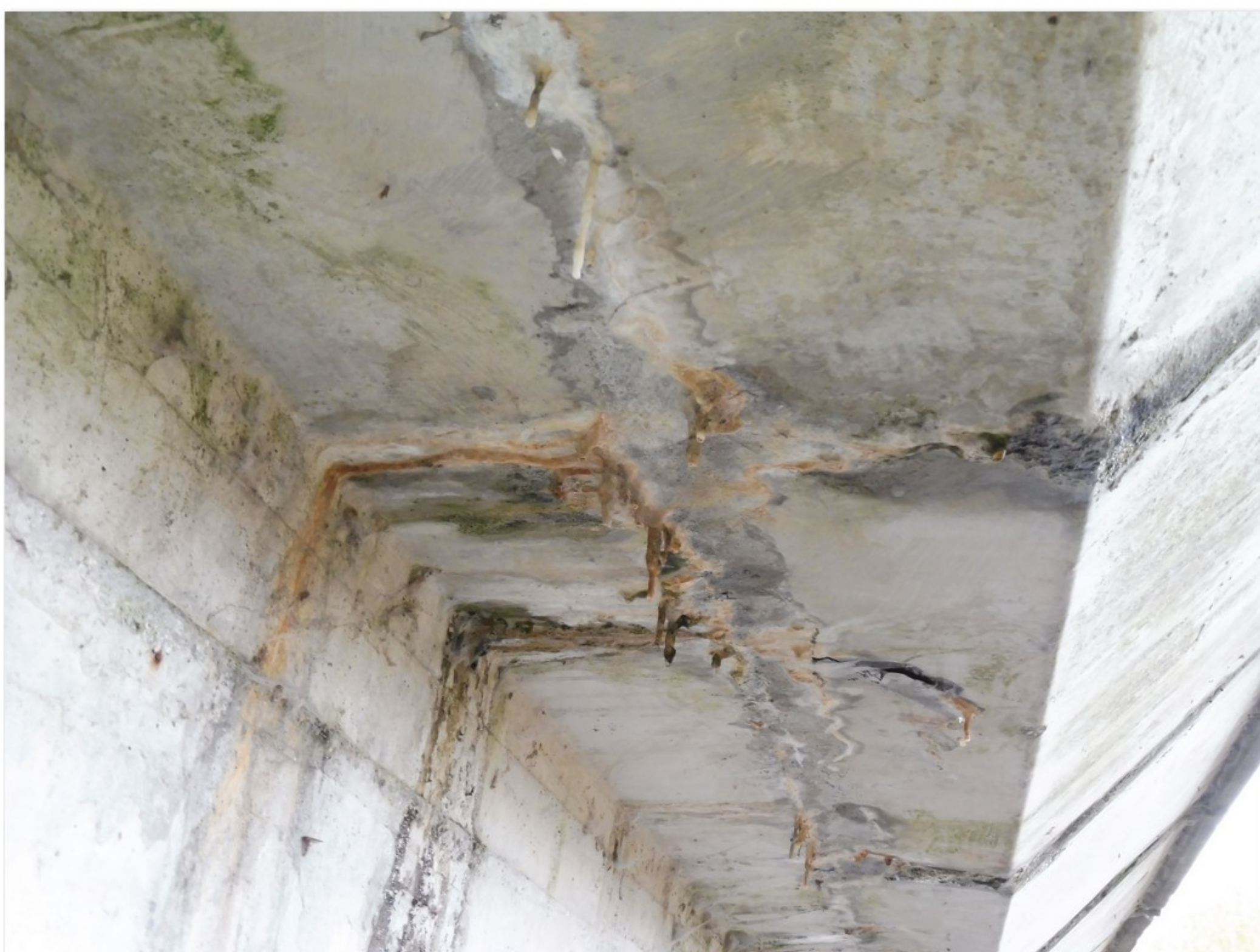
2.1-59 Detail fotografie č. 2.1-58 - zatékání v podélné spáře mezi nosníkem a prefabrikovanými konzolami - výluhy a krápníky
