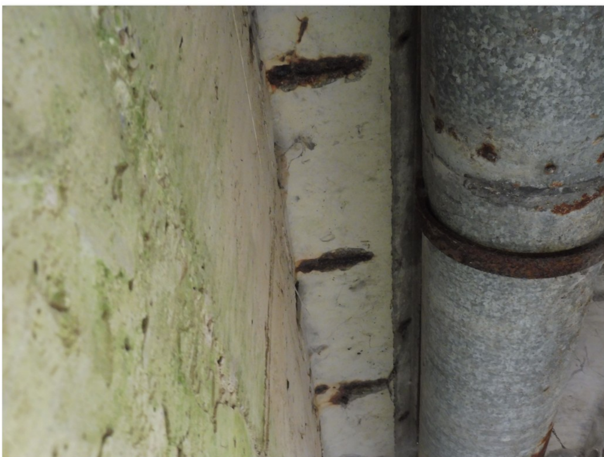
2.1-67 Detail fotografie č. 2.1-66 - v přírubě korodující výztuž s nedostatečným krytím - beton odlomený působením rozpínavých účinků korozních zplodin
