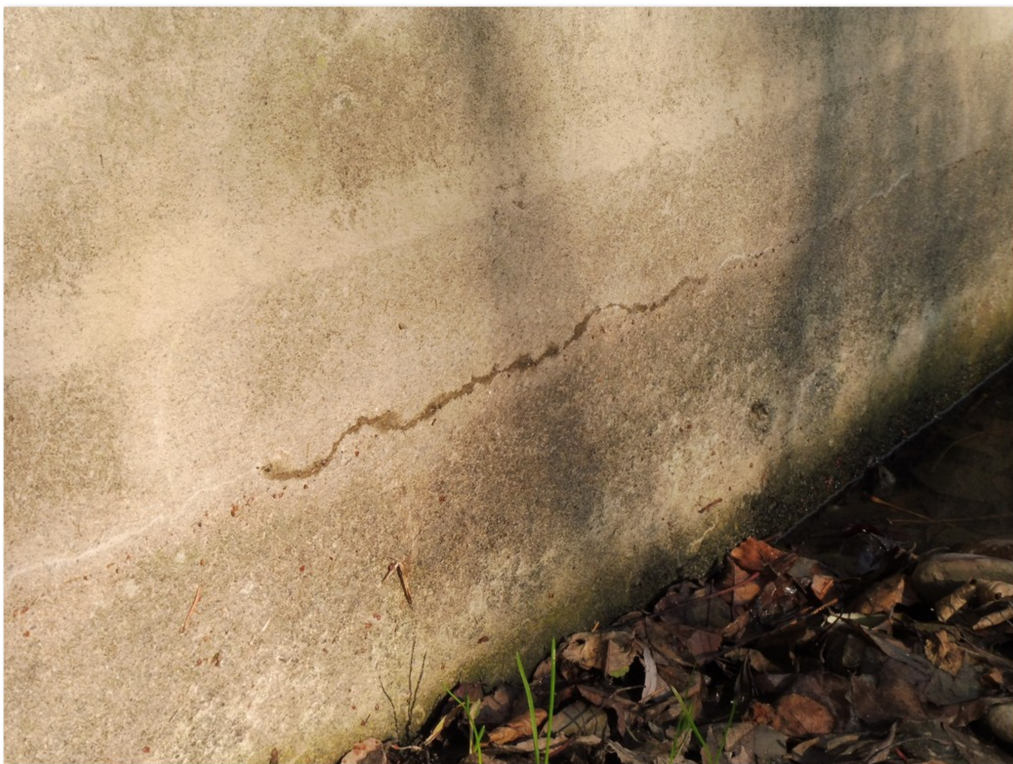
1.2-19 Trhliny v patě dříku pilíře 2
