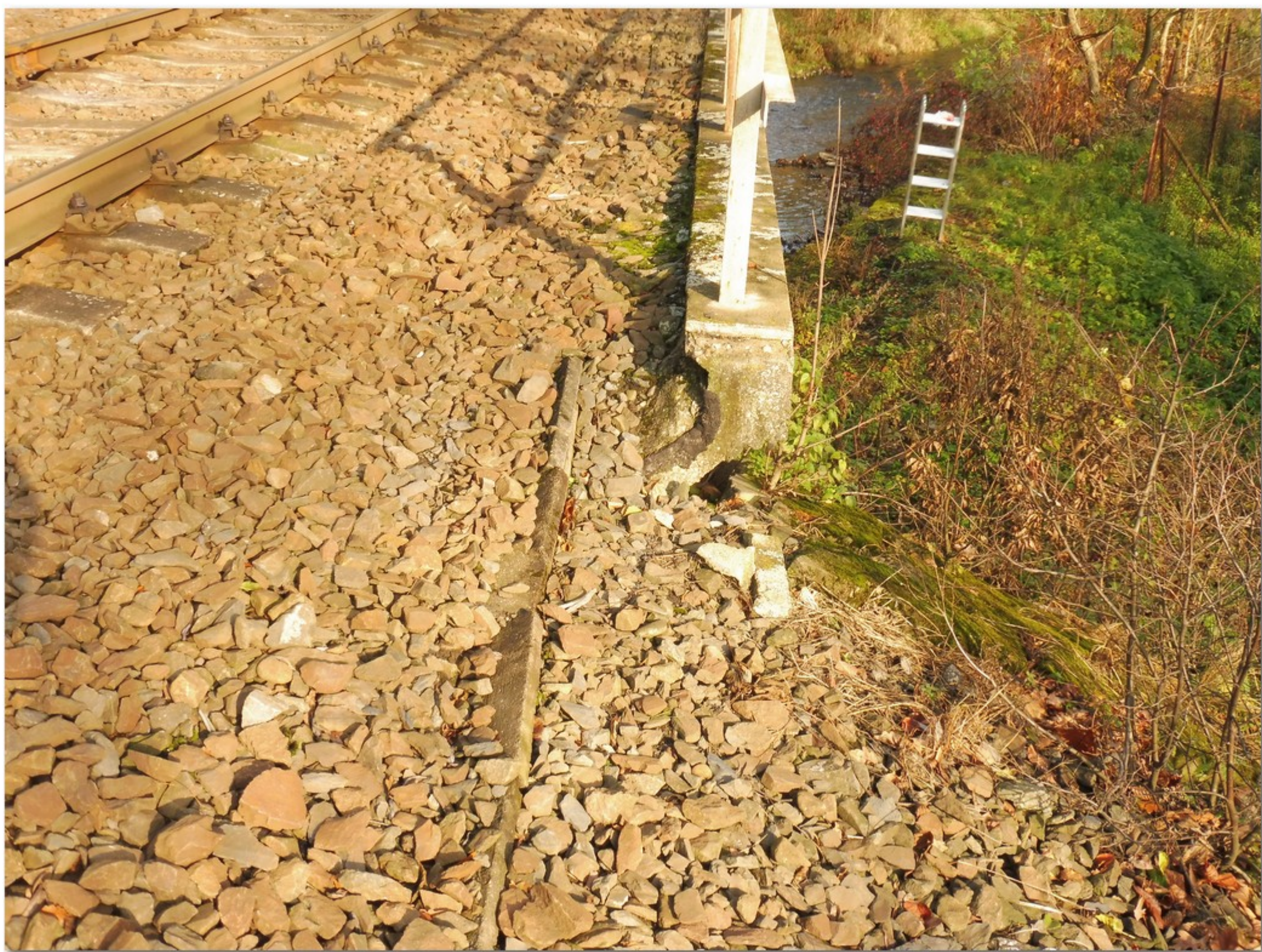
4.2-01 Kabelový žlab před opěrou 1
