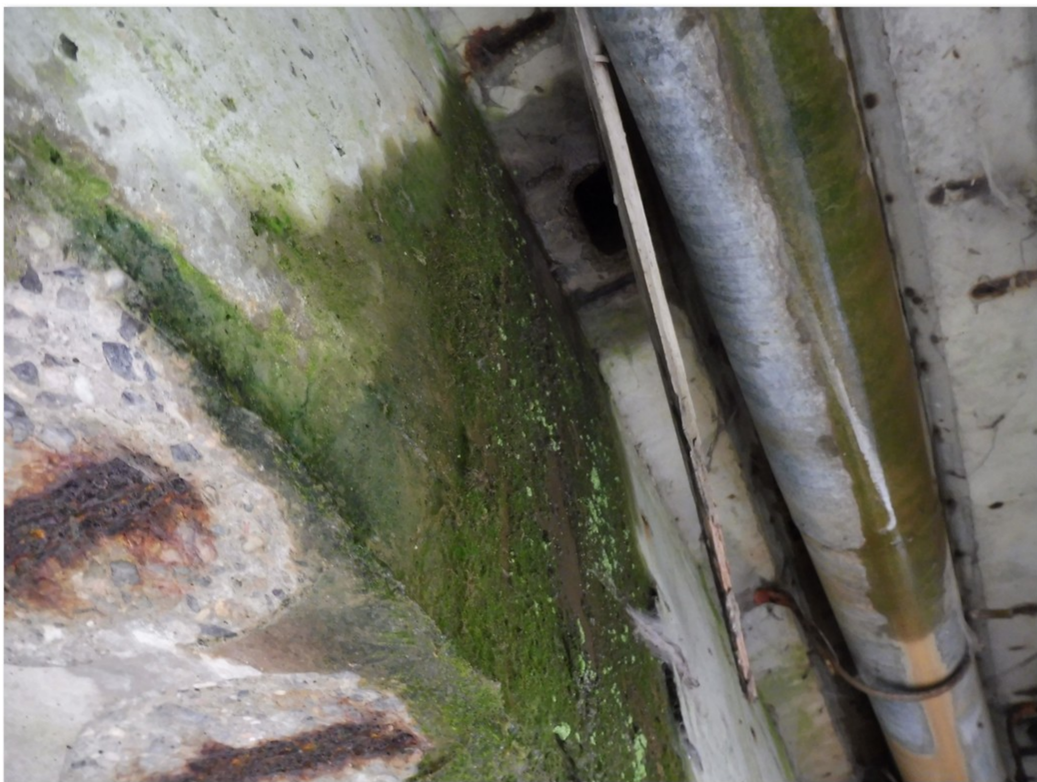
2.1-10 Pravá stěna nosníku č. 1.1 - zatékání nezapraveným montážním otvorem nad pilířem 2
